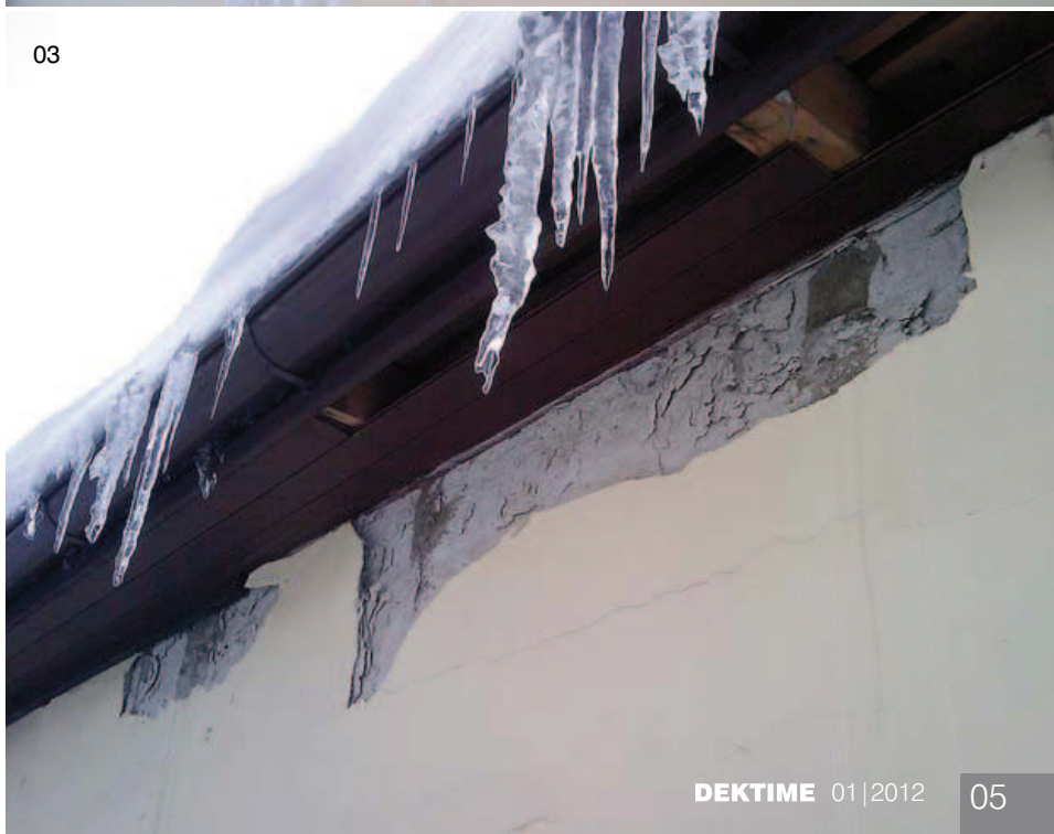
02, 03 | Degradace styku fasády a římsy
