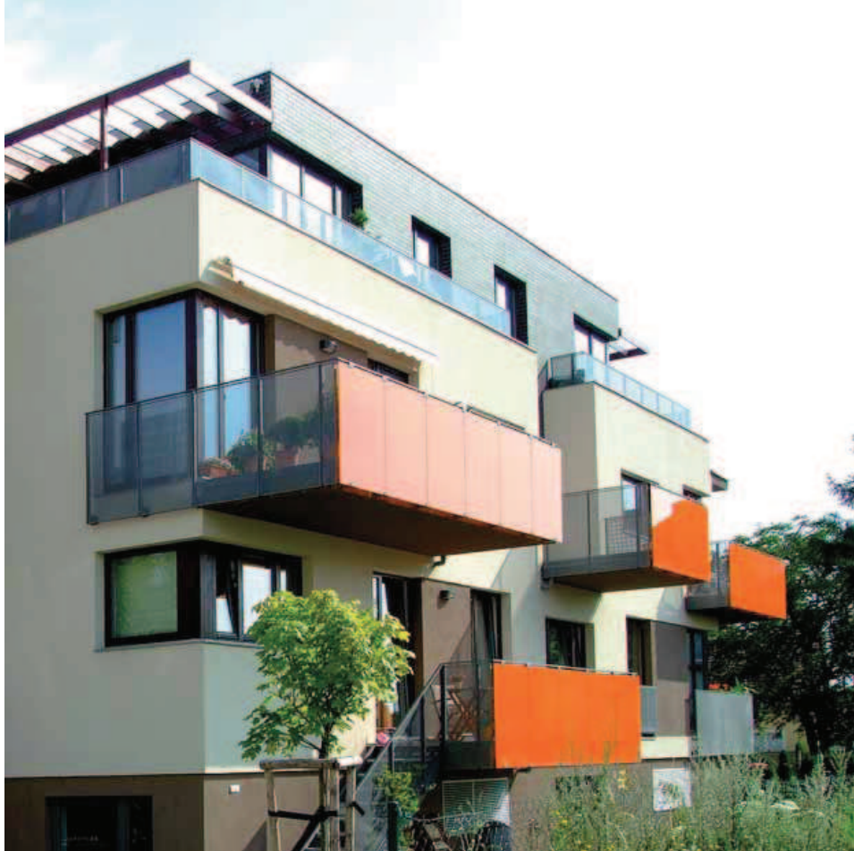
01 | Balkóny stíní okna ve spodním podlaží
