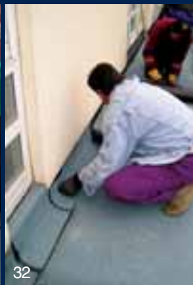
natavení druhého SBS modifikovaného asfaltového pásu (ELASTEK 50 SPECIAL DEKOR)
