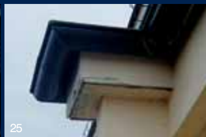
stav před rekonstrukcí zatékání v detailu okapu
