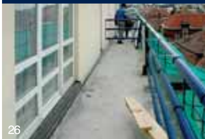
vybourání původní dlažby a původního vyrovnávacího betonu
