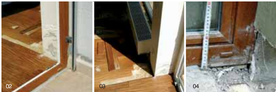
02 - 04 | Příklady vadného řešení vč. projevů poruch; nedostatečná konstrukční výška pro vrstvy terasy; hydroizolace není vodotěsně ukončena, hydroizolační stěrka doblíhá pouze k rámu dveří.
