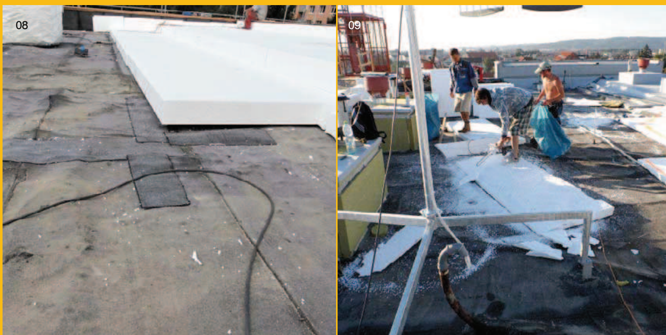
08, 09| Vyrovnávání podkladu upravovanými deskami z EPS 100S
