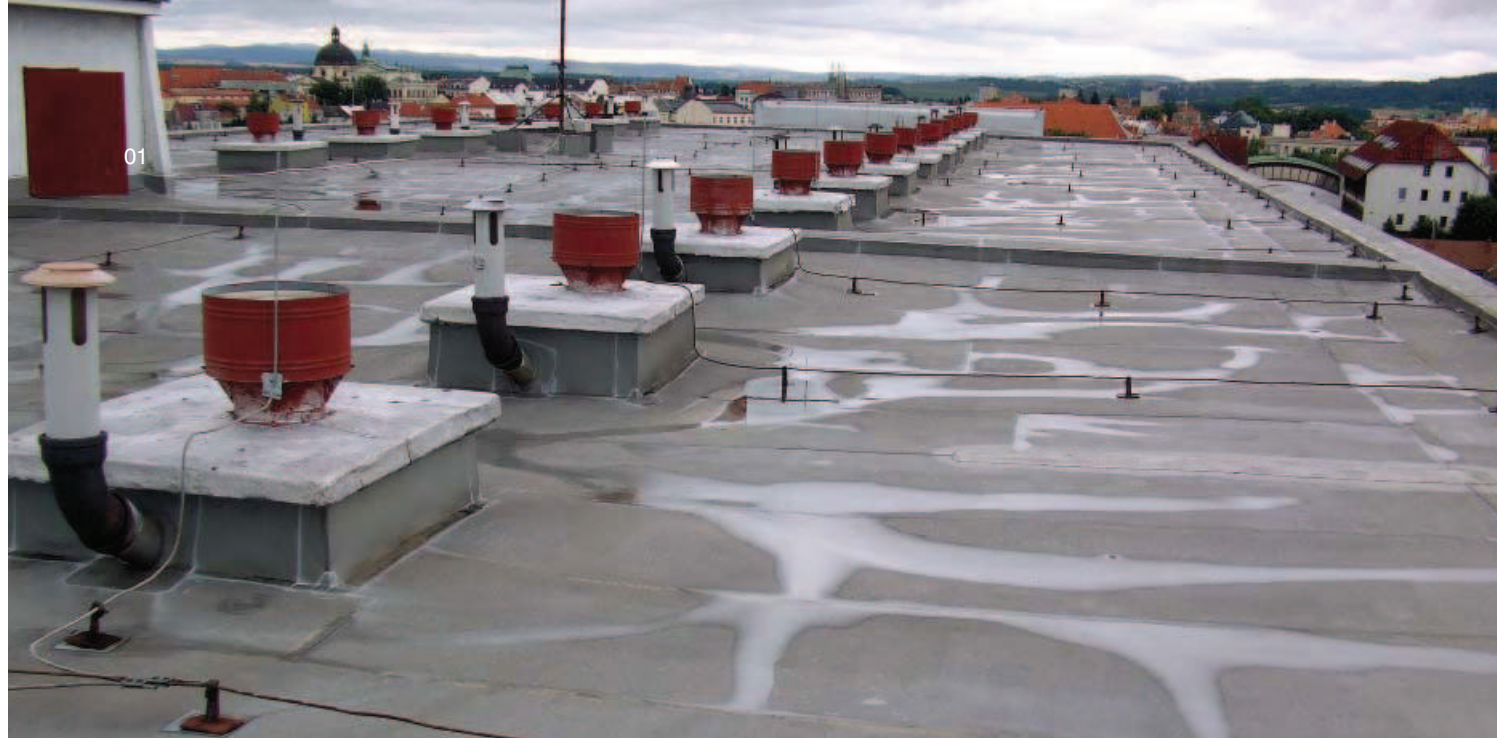
01 | Střecha před rekonstrukcí
