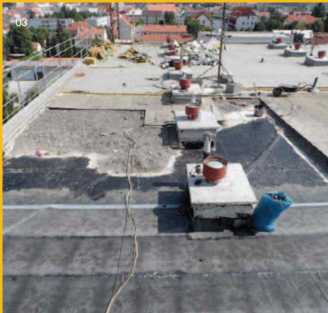
03, 04 | Etapové odstraňování původních vrstev skladby až na ŽB panel
