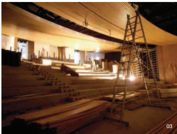
03 – 06 | Záběry z realizace interiéru, na /obr. 04/ rezonátory BF1-SON
