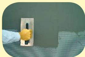
Pokud se vytváří základní vrstva, vkládá se skleněná síťovina do předem nanesené vrstvy stěrkové hmoty a vtláčí se dovnitř zahlažením nerezovým hladítkem směrem od středu ke krajům. Skleněná síťovina je v 1/3 tloušťky základní vrstvy od vrchu.
