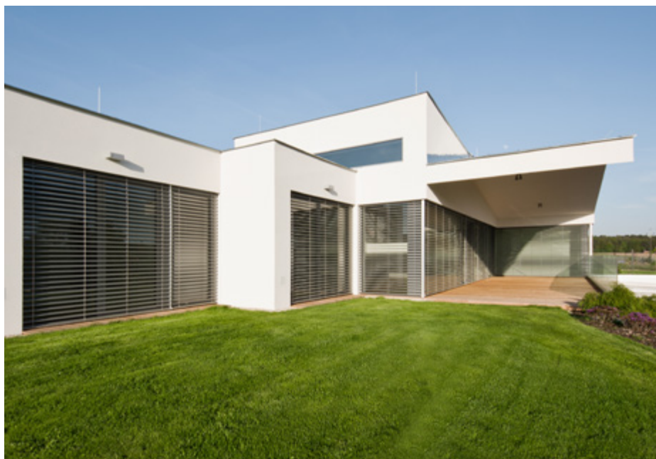
Žaluzie NEVA Z-90 zabudované do schránky ISO-KASTL s použitím sendvičových desek
