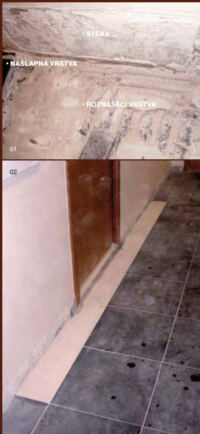
01 | Napojení roznášecí vrstvy podlahy na stěnu bez pružného oddělení (příklad 1)
