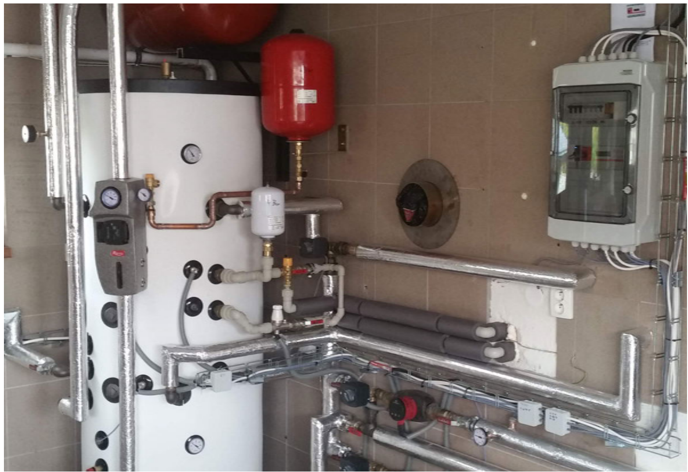
Jednotka topná elektrické topné těleso k zásobníkům
