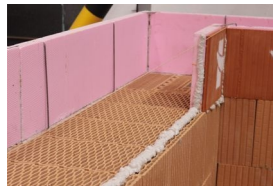
Nejprve se zdí na vnějším líci zdiva a poté na vnitřním.
