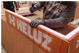
Založení rohů a stabilizace tvarovek pomocí natloukacích kotev.
