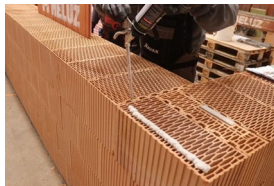
Tvarovky se zdí na PU pěnu HELUZ.
