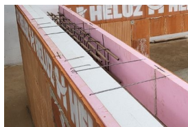
Uloží se výztuž věnce.
