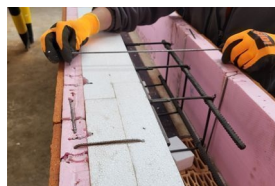
Před betonáží se vrchní strana spojů sponami, které se zaklepou do úrovně horní hrany věnce.
