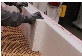
Pomocí PU pěny se na polystyren přilepí tepelná izolace věnce.
