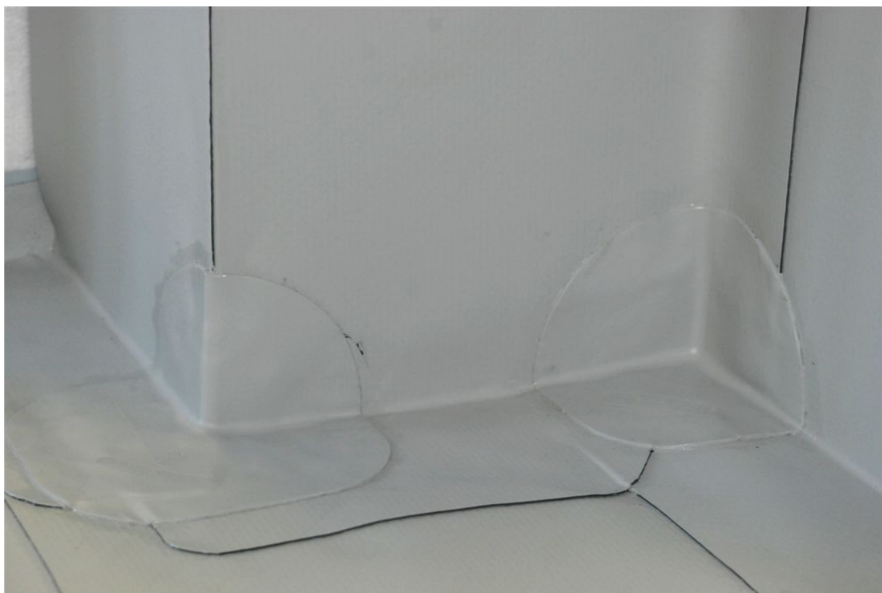
Obrázek 16.: Opracování hydroizolace v koutu a na rohu
