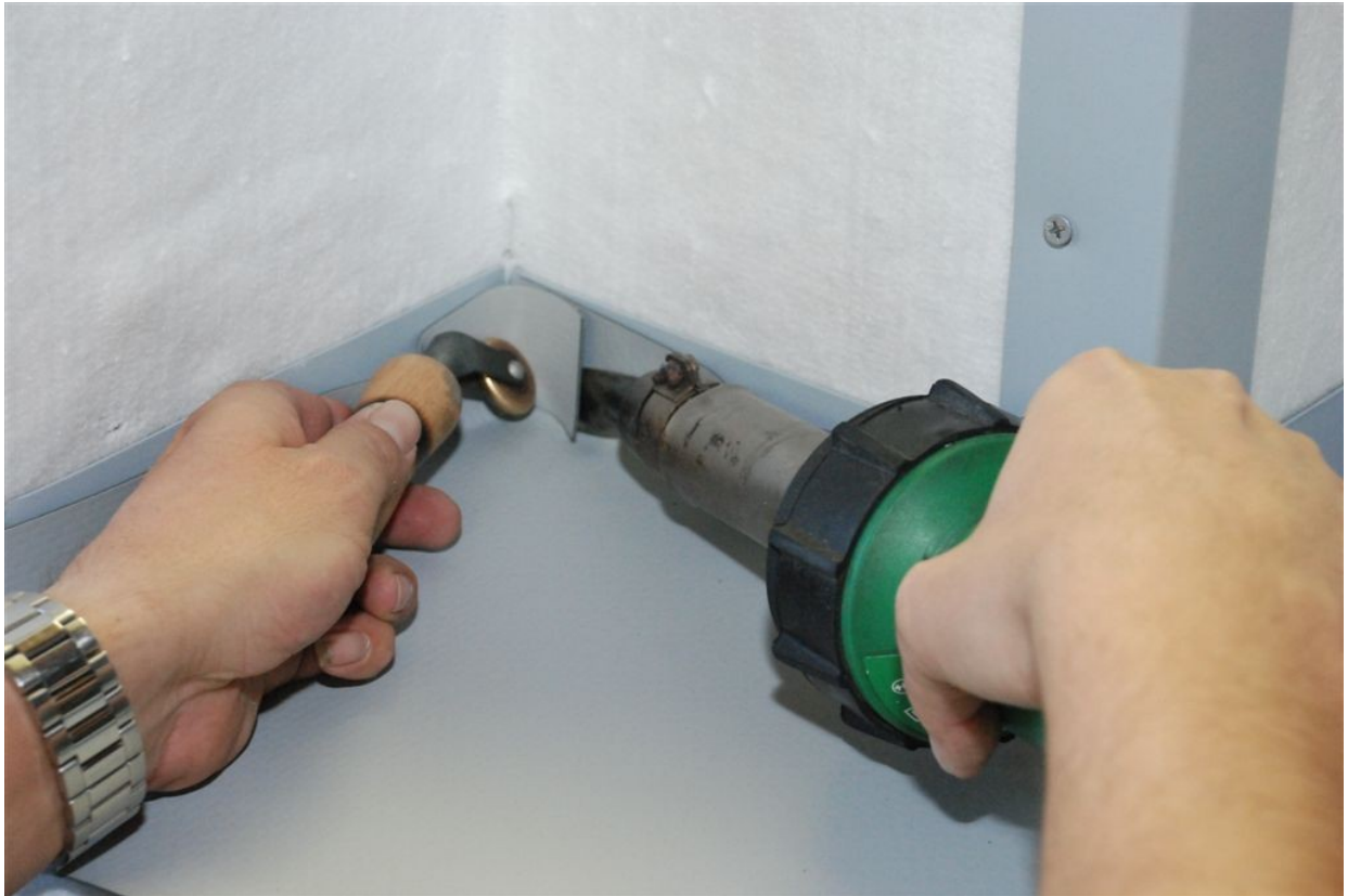
Obrázek 9.: Postup opracování hydroizolace v koutu
