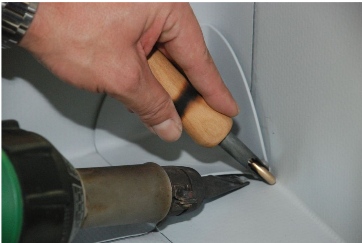
Obrázek 15.: Postup opracování hydroizolace v koutu
