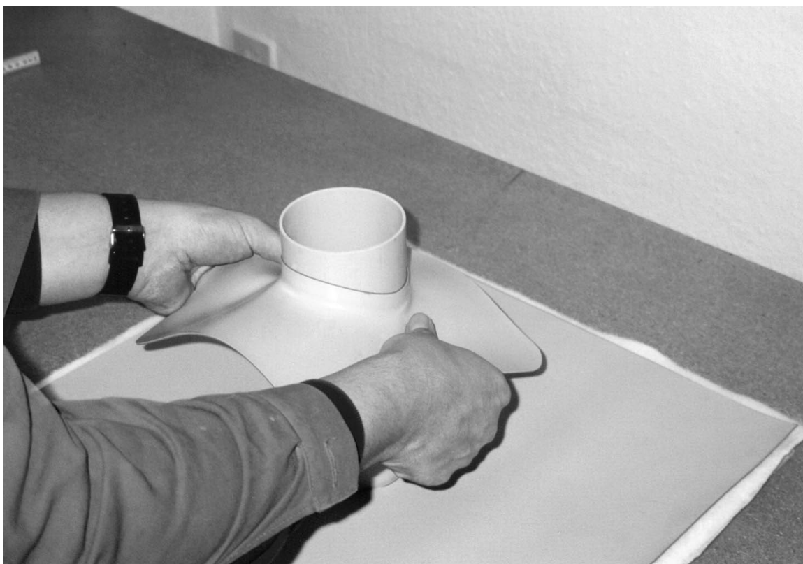
Obrázek 20.: Opracování prostupu - nasazení manžety na prostup
