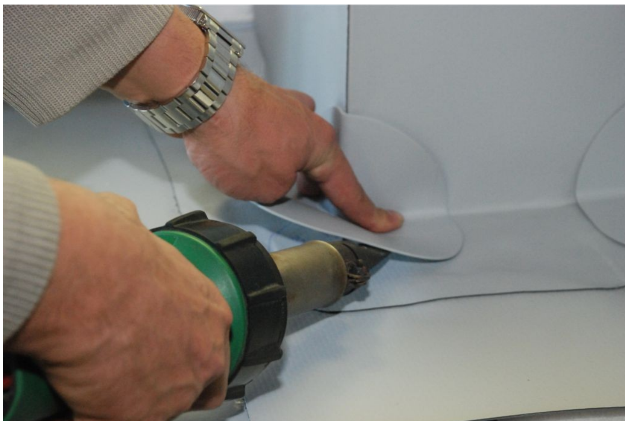
Obrázek 14.: Postup opravování hydroizolace na rohu
