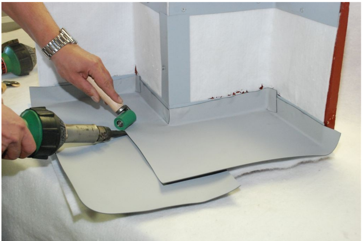
Obrázek 10.: Postup opracování hydroizolace na rohu
