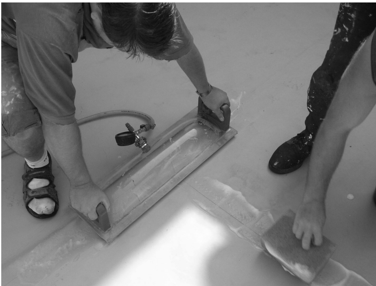
Obrázek 25.: Zkoušení těsnosti spojů vakuovou zkouškou
