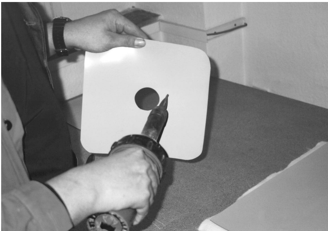
Obrázek 19.: Opracování prostupu - nahřívání manžety pouze z rubové strany
