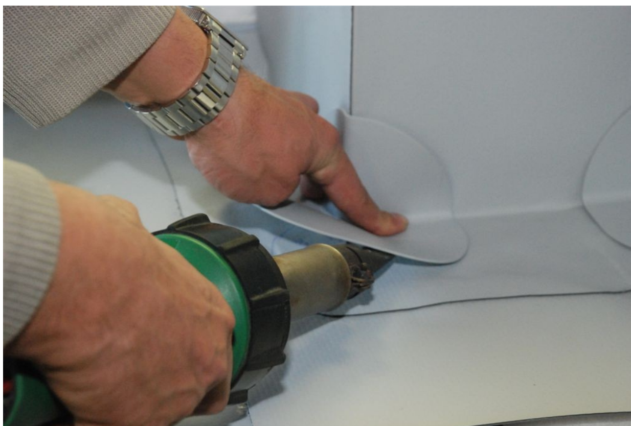
Obrázek 14.: Postup opracování hydroizolace na rohu
