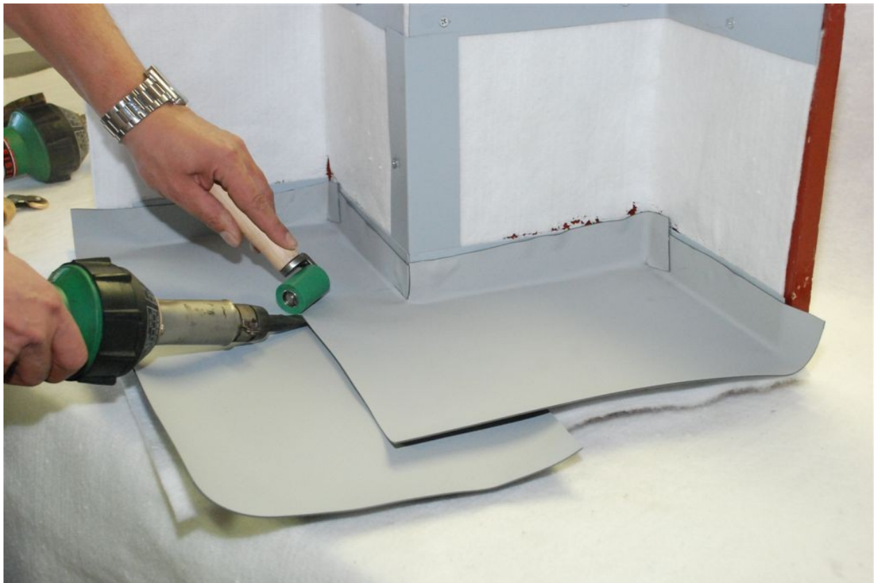
Obrázek 10.: Postup opracování hydroizolace na rohu
