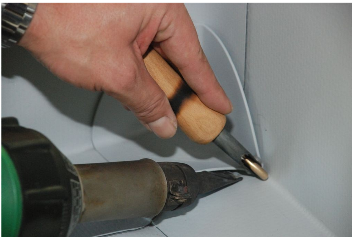
Obrázek 15.: Postup opracování hydroizolace v koutu
