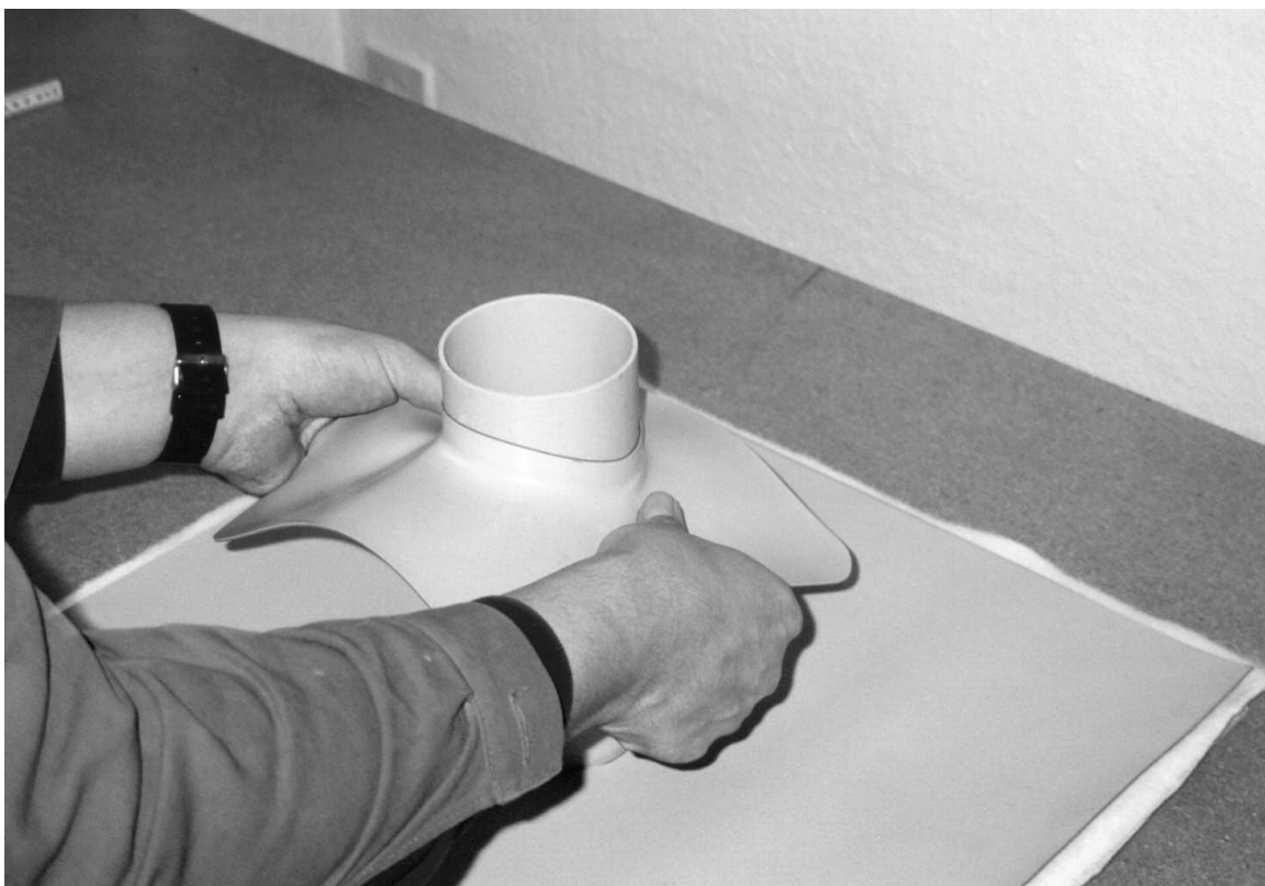
Obrázek 20.: Opracování prostupu - nasazení manžety na prostup
