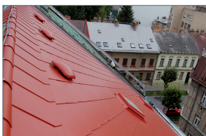
Větrání střešního pláště je realizováno plastovými hlaviciemi.
