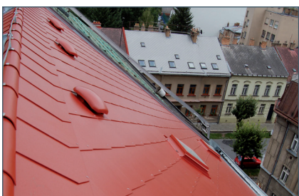
Větrání střešního pláště je realizováno plastovými hlaviciemi.
