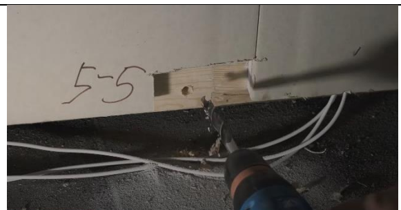
4. Vyvrtní otvor o průměru 10 mm a hloubce přibližně 20 mm.
