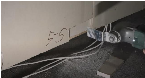
1. Vyříznutí prostoru pro instalaci senzoru (lze použít i vykružovák).
