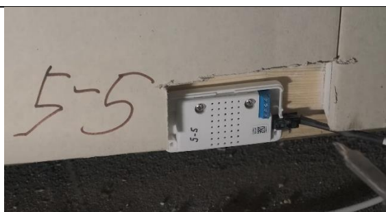
8. Vrutu musí být dotaženy až nadoraz. Je důležité, aby byl senzor uchycen pevně.
