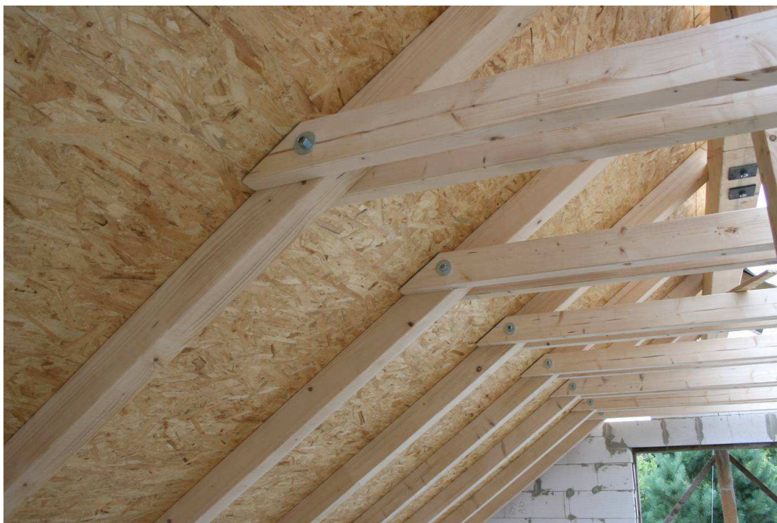
Obr 3. - Montáž bednění z desek OSB
