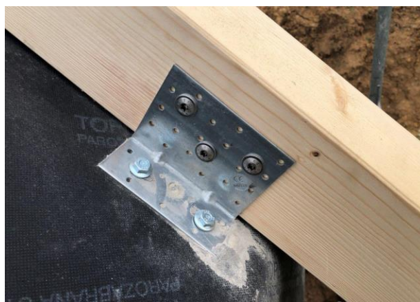
Obr. 38. Připevnění okapové podpory pomocí úhelníků
