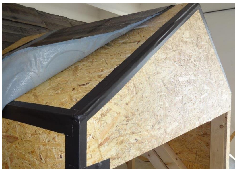
Obr. 30. Přelepení spár opláštění konstrukce vikýře
