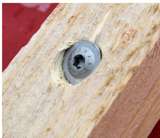
Obr 18. - Osazení vrtu B
