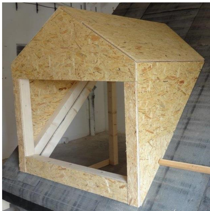
Obr. 29. Dokončené opláštění konstrukce vikýře
