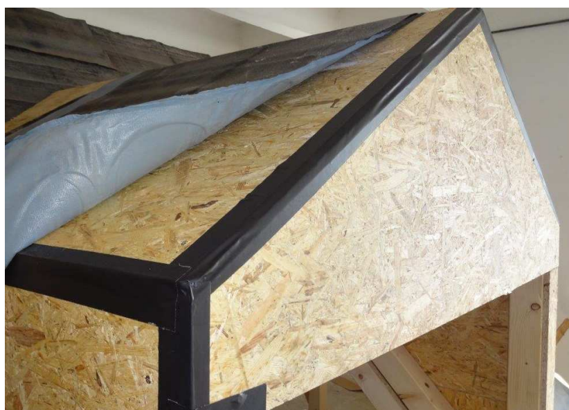
Obr. 30. Přelepení spár opláštění konstrukce vikýře
