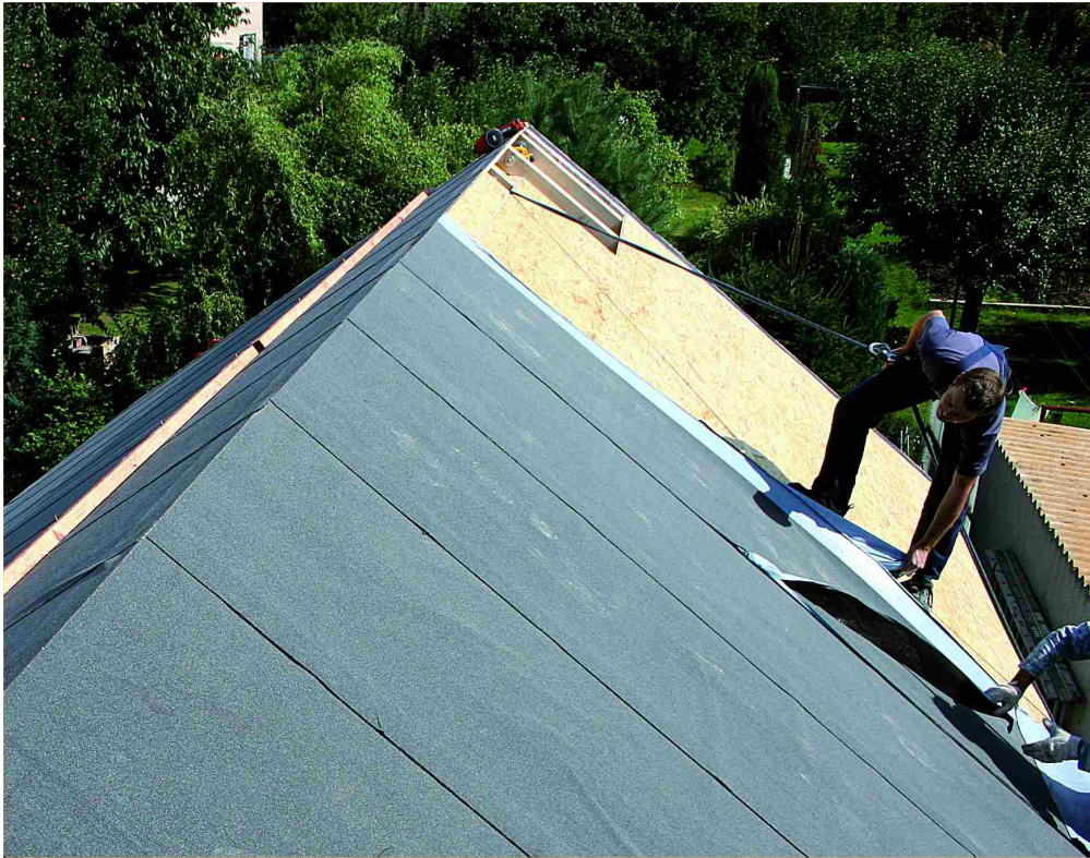
Obr 6. - Pokládka parotěsnicí a vzduchotěsnicí vrstvy ze samolepicího asfaltového pásu TOPDEK AL BARRIER
