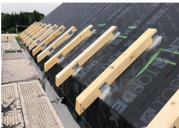
Obr. 37. Systém okapových podpor
