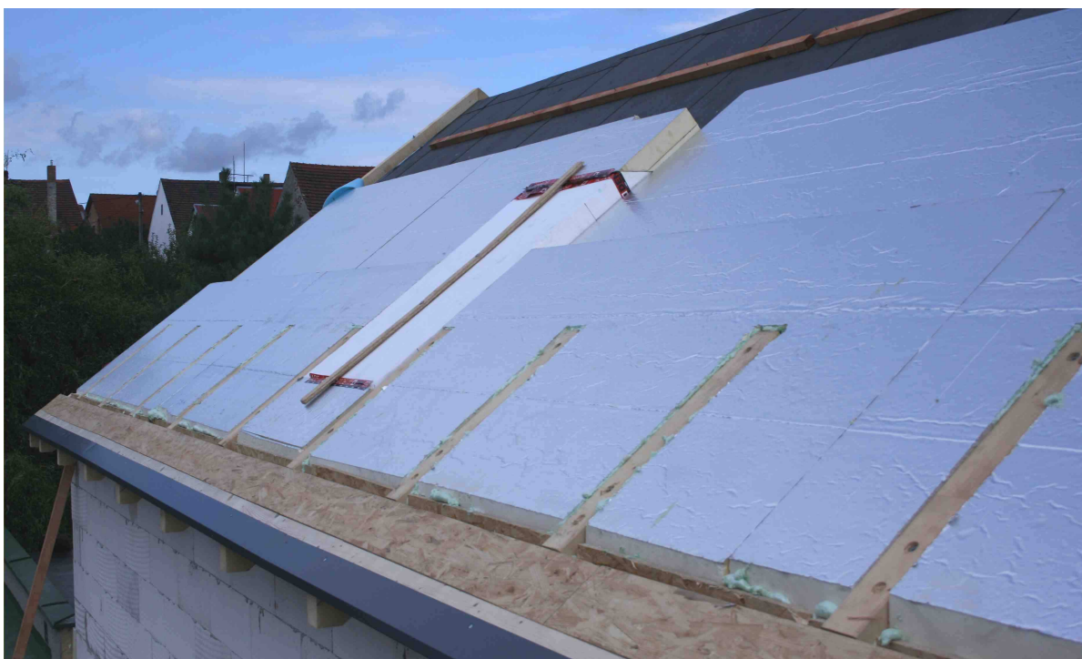
Obr 9. - Ukončení tepelněizolační vrstvy u okapu
