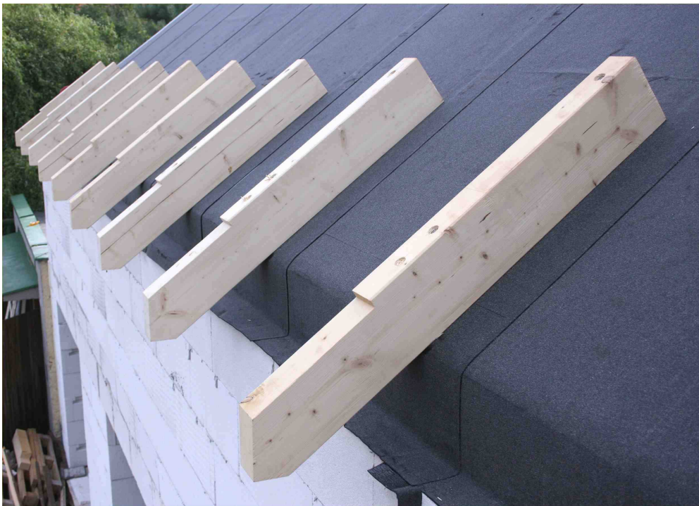
Obr 7. - Upevnění podpor přesahu střechy u okapu
