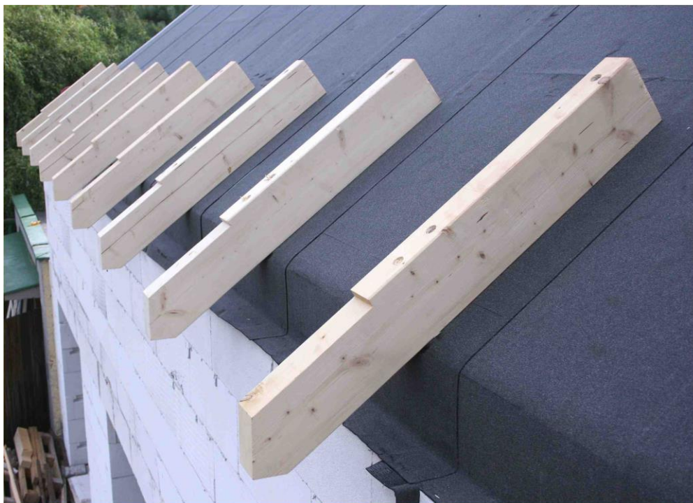
Obr 7. - Upevnění podpor přesahu střechy u okapu
