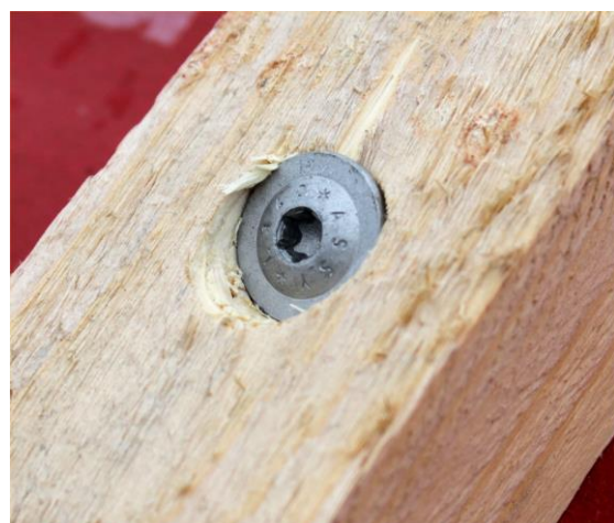
Obr 18. - Osazení vrutu B
