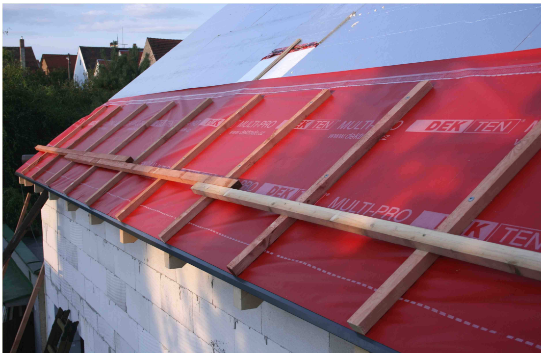
Obr 12. - Pokládka doplňkové hydroizolační vrstvy
