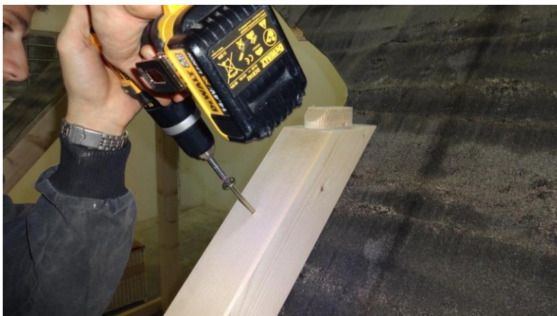
Obr. 26. Upevnění základních bočních dílů ke krokvi
