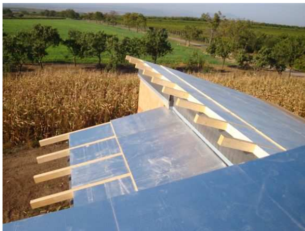
Obr 10. - Pokládka tepelněizolačních desek TOPDEK 022 PIR
