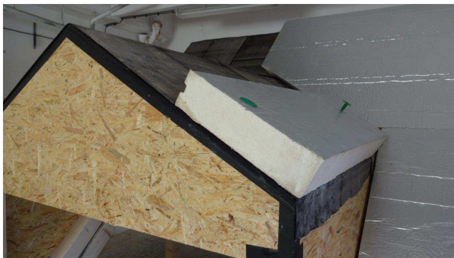
Obr. 31. Pracovní upevnění tepelněizolační vrstvy u okapní hrany
