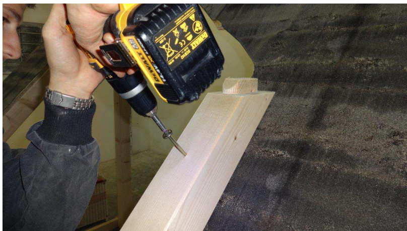
Obr. 26. Upevnění základních bočních dílů ke krokvi
