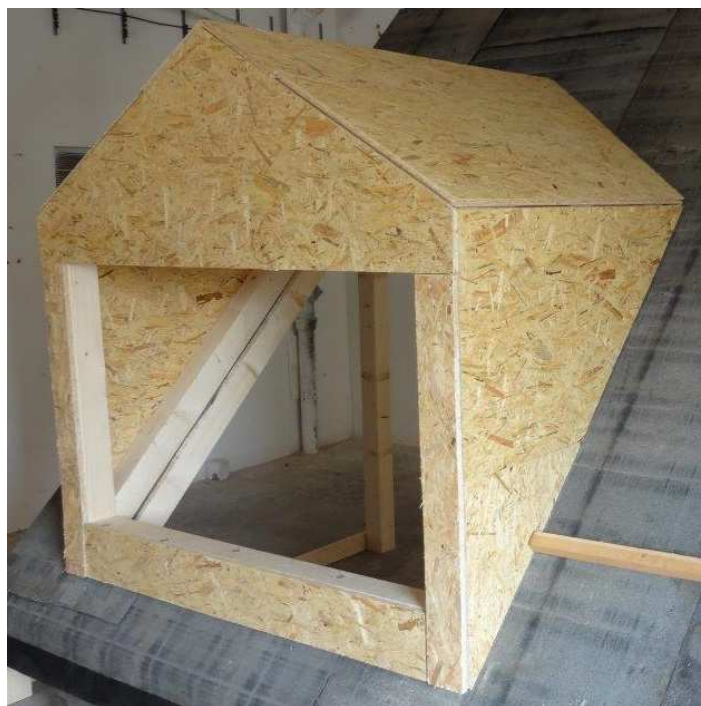
Obr. 29. Dokončené opláštění konstrukce vikýře
