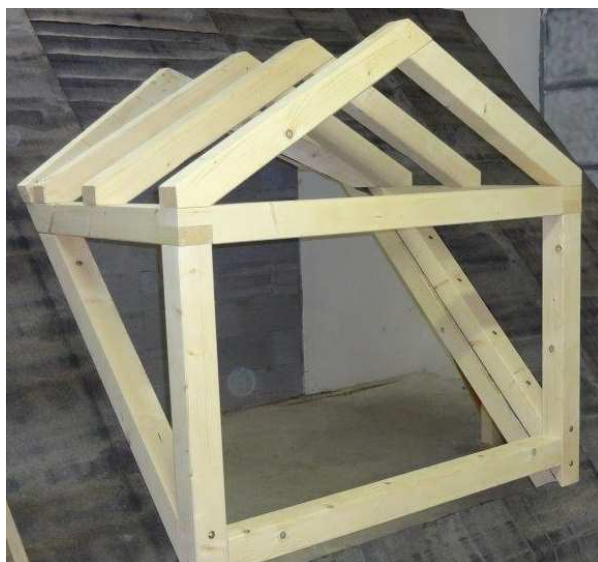
Obr. 27. Sestavená konstrukce vikýře
