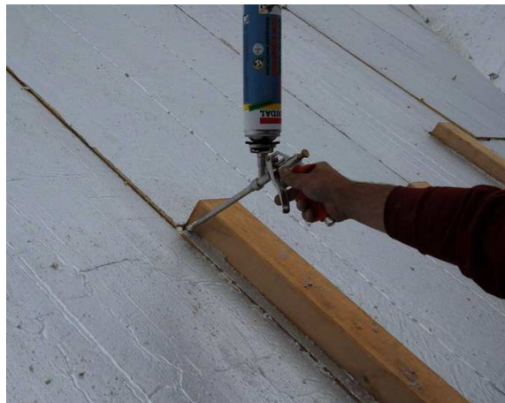
Obr 11. - Vypěnění spáry mezi tepelnou izolací a podporou montážní pěnou
