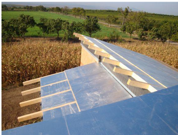
Obr 10. - Pokládka tepelněizolačních desek TOPDEK 022 PIR
