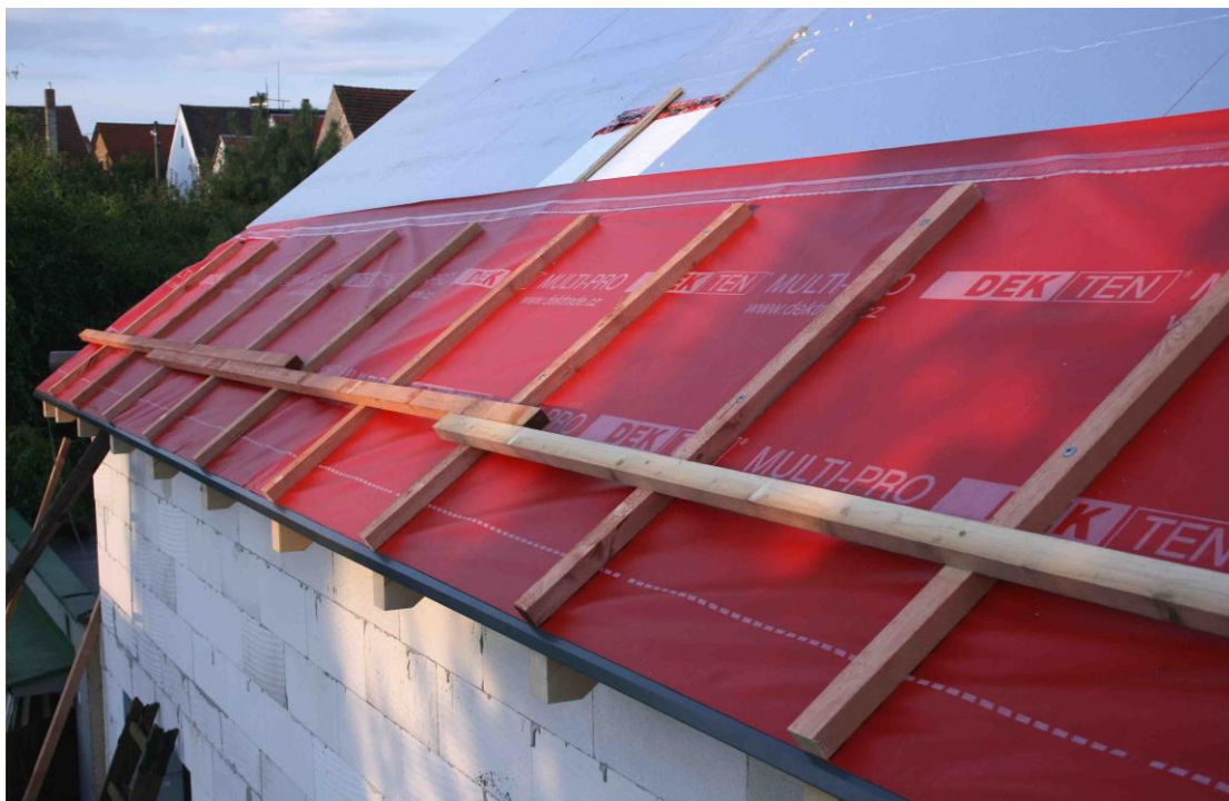
Obr 12. - Pokládka doplňkové hydroizolační vrstvy
