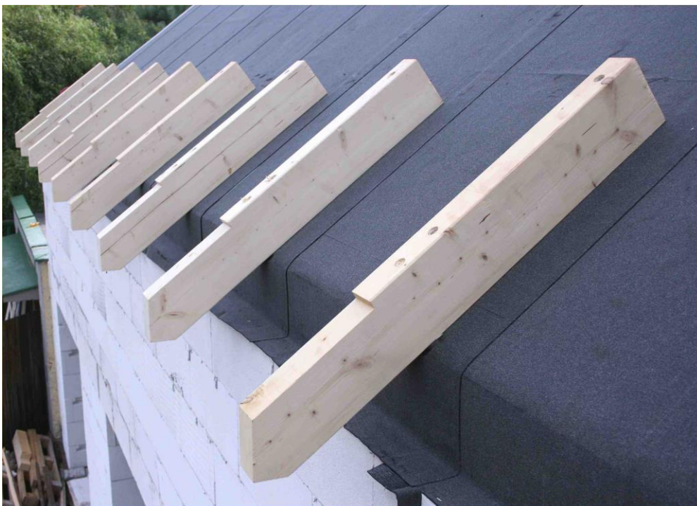
Obr 7. - Upevnění podpor přesahu střechy u okapu
