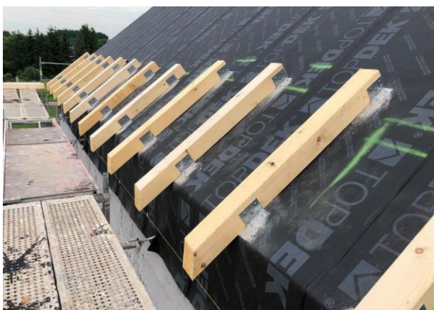
Obr. 37. Systém okapových podpor
