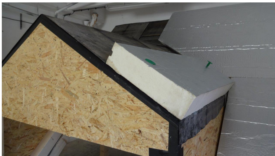
Obr. 31. Pracovní upevnění tepelněizolační vrstvy u okapní hrany
