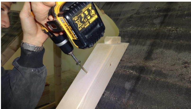
Obr. 26. Upevnění základních bočních dílů ke krokvi
