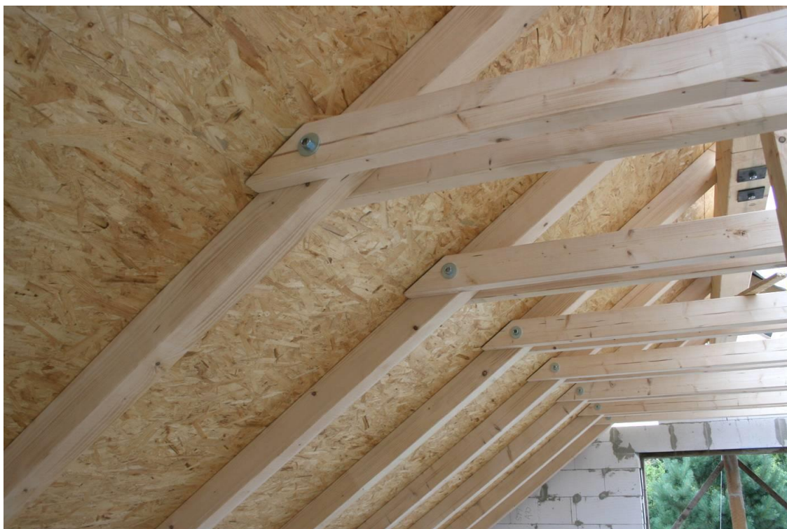
Obr 3. - Montáž bednění z desek OSB
