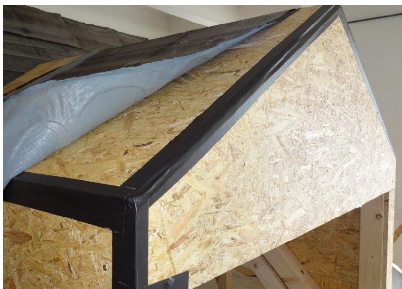
Obr. 30. Přelepení spár opláštění konstrukce vikýře
