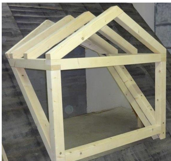
Obr. 27. Sestavená konstrukce vikýře
