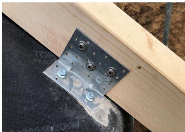
Obr. 38. Připevnění okapové podpory pomocí úhelníků
