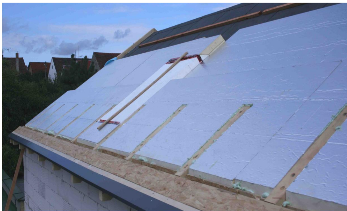
Obr 9. - Ukončení tepelněizolační vrstvy u okapu
