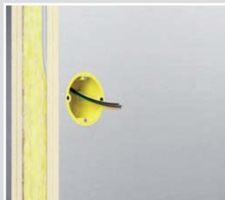
Montáž protiradiační krabice do stěny.
