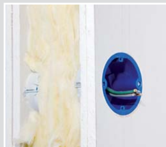
Protilehlá montáž zvukotěsné krabice.
