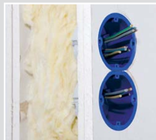
Jednostranné použití zvukotěsné krabice ve dvojnásobné kombinaci.
