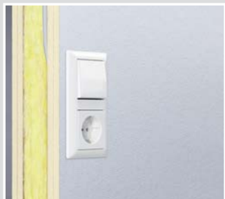
Příklad montáže s kombinací vypínače a zásuvky.
