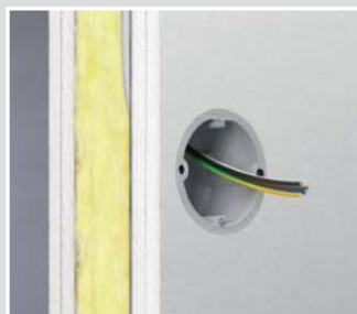
Instalace protiradiační krabice do stěny.
