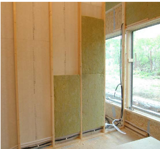
Obr. 1 – Příklad použití izolace ISOVER Orsik
