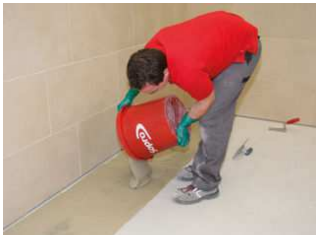
1. Nalijte vrstvu FKM XL v tekuté konzistenci na připravený podpovrch.
