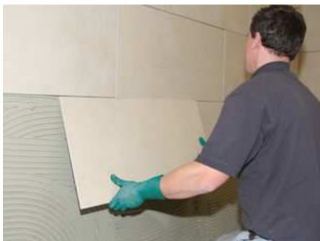
2. Pokládejte velkoformátové obklady, přebytečné lepidlo odstraňte než zatvrdne.
