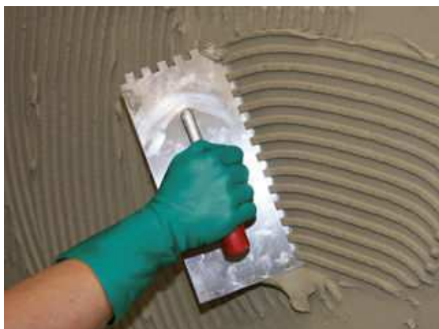
1. Naneste vrstvu lepidla zubovou stěrkou na stěnu s připraveným povrchem.
