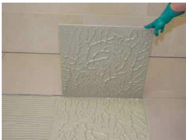
4. Optimální instalace téměř bez bublin je se Sopro FKM XL možná.
