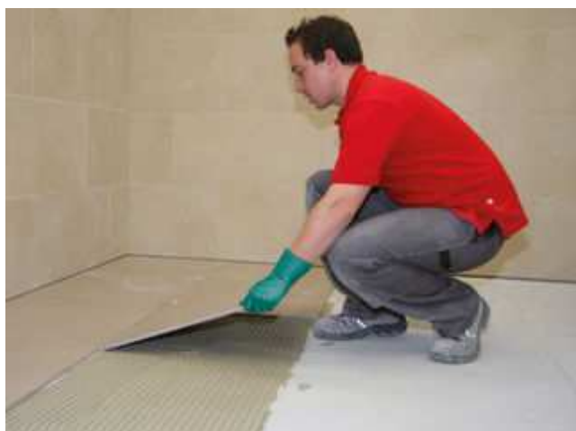
3. Vložte s rovnoměrně pokládejte velkoformátové obklady.
