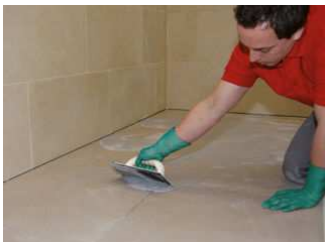
5 Spojování povrchu spárovací hmotou Sopro (např. Sopro DF 10 DesignFuge Flex, Sopro Brillant Perfuge).
