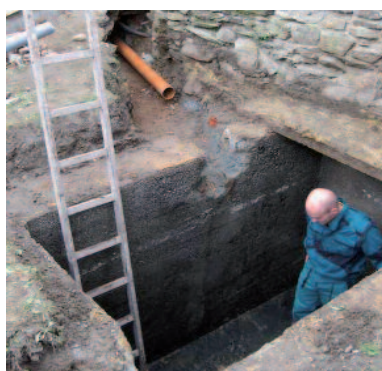
Příklad osazení domovní ČOV Aquatec AT6 do původního septiku
