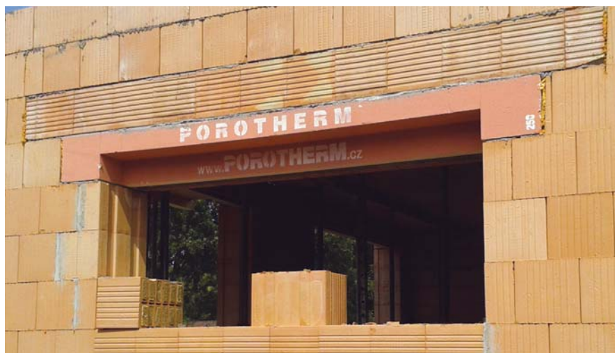
Použití překládů Vario s rozpětím 2500 mm u stěn tl. 44 cm
