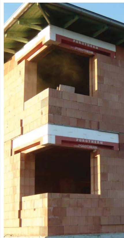
Každý případ řešení rohového okna bez sloupku musí být individuálně posouzen formou statického posudku pro konkrétní zatížení a vyložení
