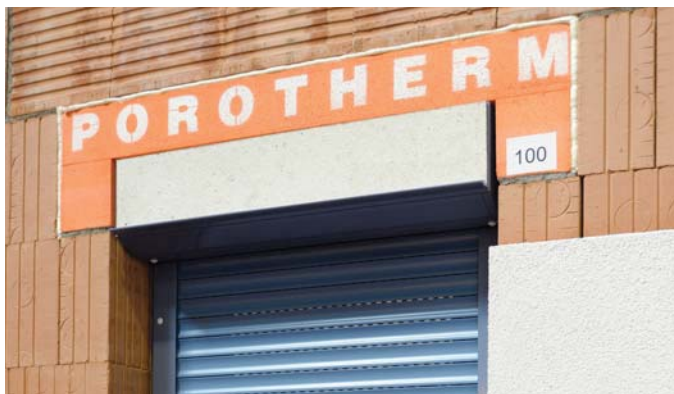
překlad KP Vario v délce 1000 mm pro světlost otvoru do 750 mm
