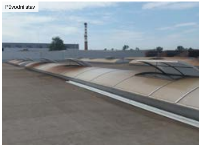
Odstraňování původní hydroizolace střechy
