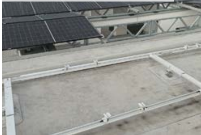
Montáž FVE panelů na konstrukci připevněnou k DEK kotevnímu bodu
