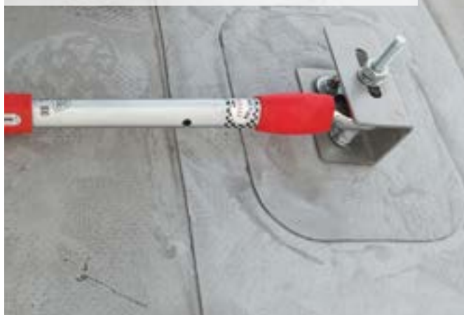
Montáž konstrukce pro instalaci FVE panelů na DEK kotevní bod s C-nástavbou
