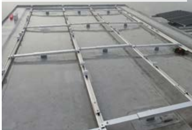
Montáž FVE panelů na konstrukci připevněnou k DEK kotevnímu bodu
