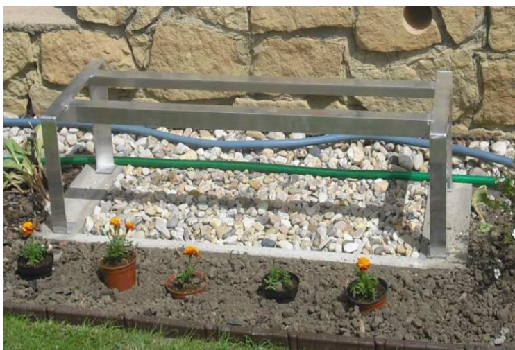
Obrázek 9: Ukázka provedení základu pro tepelné čerpadlo
