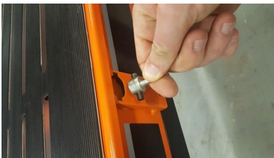
Vložte šrouby do otvorů rámu stroje
