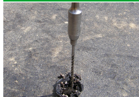
03 | Předvrtání otvoru pro kotevní prvek
