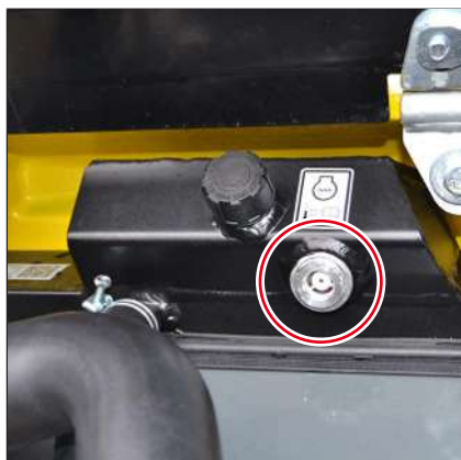
Obr. 247: Kontrola stavu chladiva
