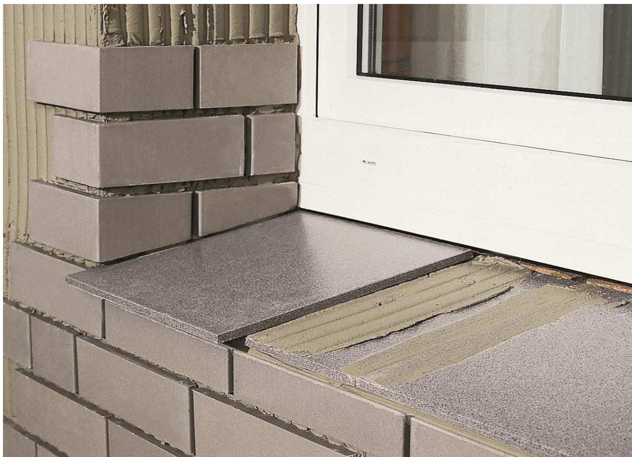
Obrázek 52. - Vnější parapet okna s obkladem - rozpracovaný
