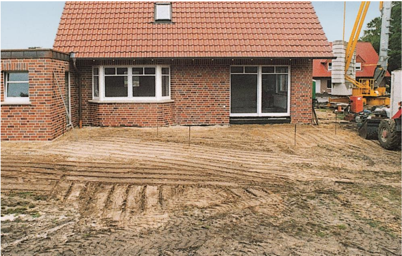
Obrázek 3. - Hrubé urovnání a zhutnění terénu
