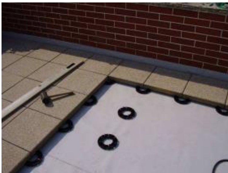
Obrázek 35. – Realizace dlažby na podločkách
