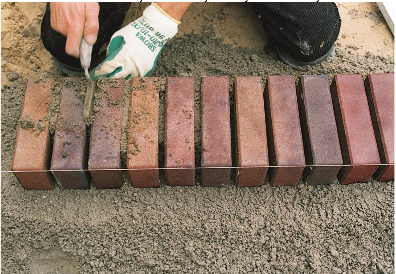
Obrázek 13. - Spárování okraje dlažby
