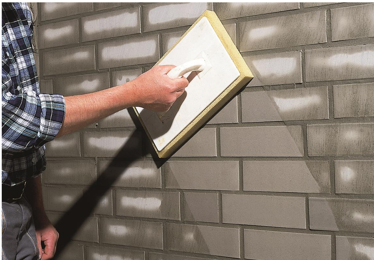
Obrázek 56. - Čištění obkladu
