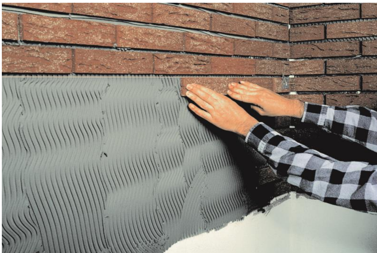
Obrázek 58. - Lepení keramických pásků – plocha
