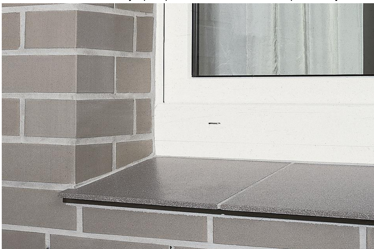
Obrázek 53. - Vnější parapet okna s obkladem - hotový
