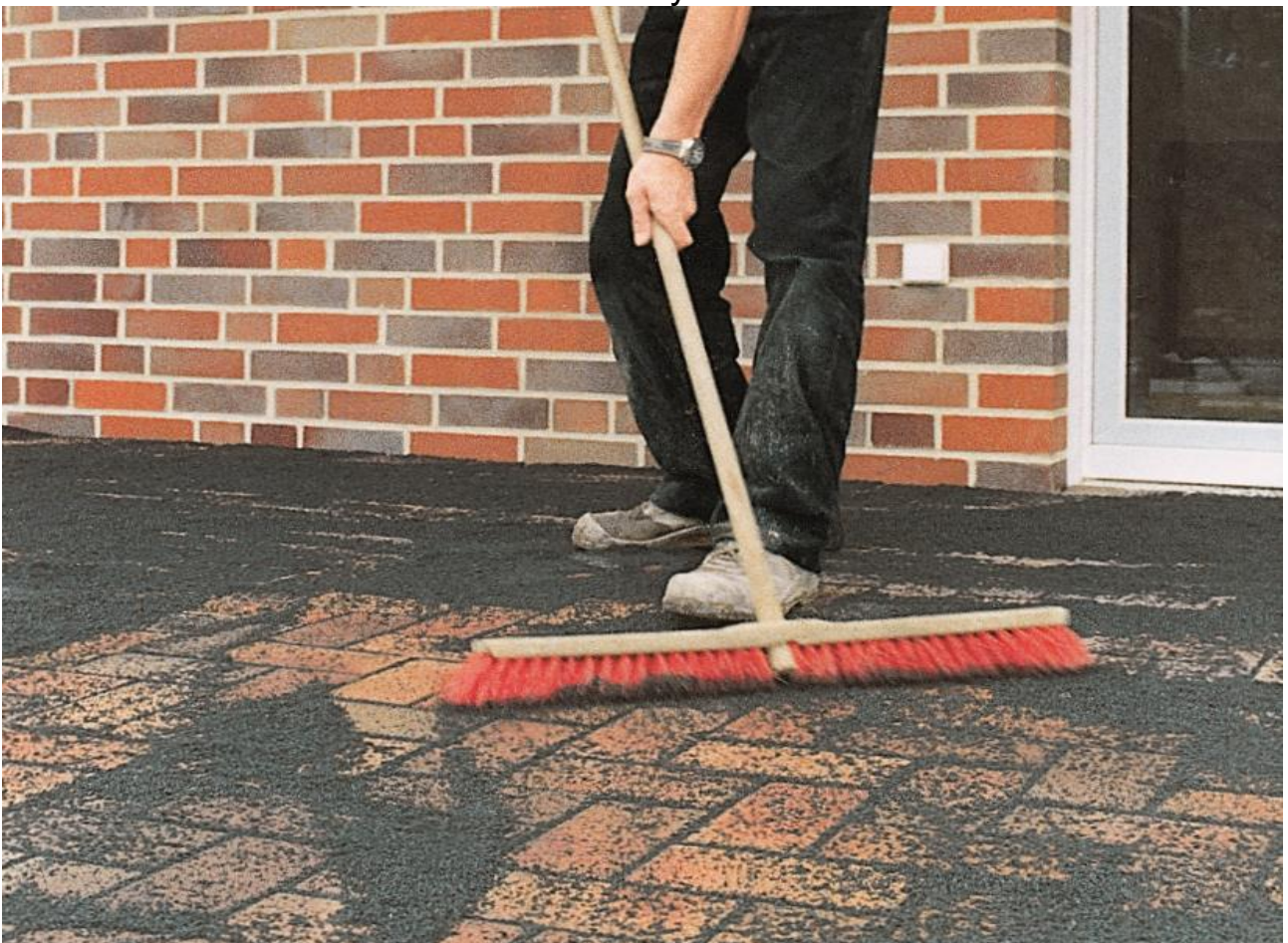
Obrázek 31. - Nametení písku (drtě) do spár
