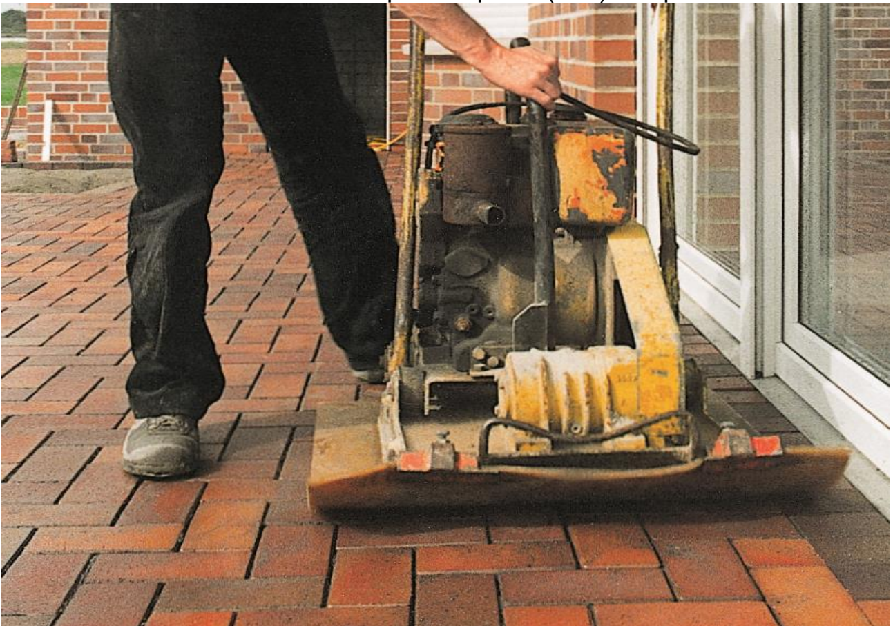
Obrázek 33. - Hutnění dlažby
