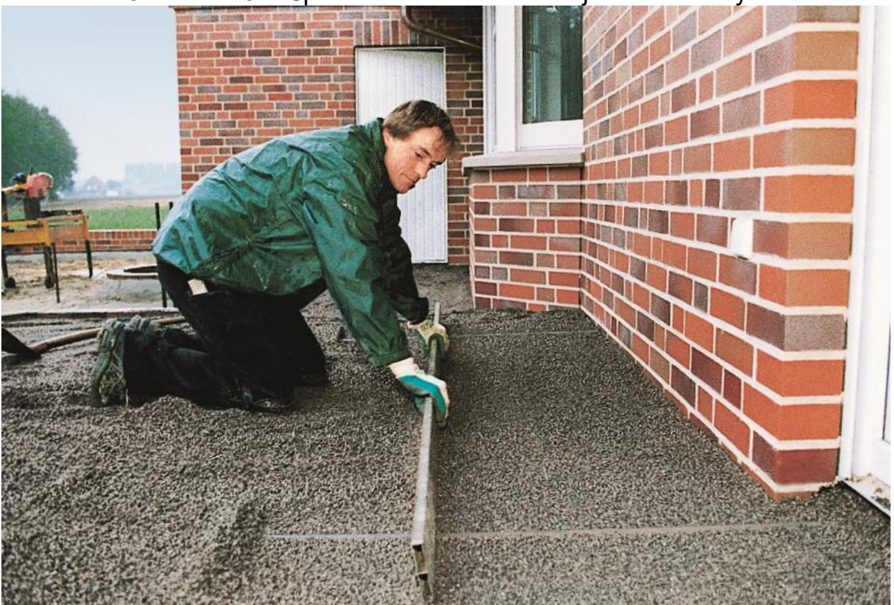
Obrázek 20. - Spádování lože mezi okrajem a vodicí tyčí
