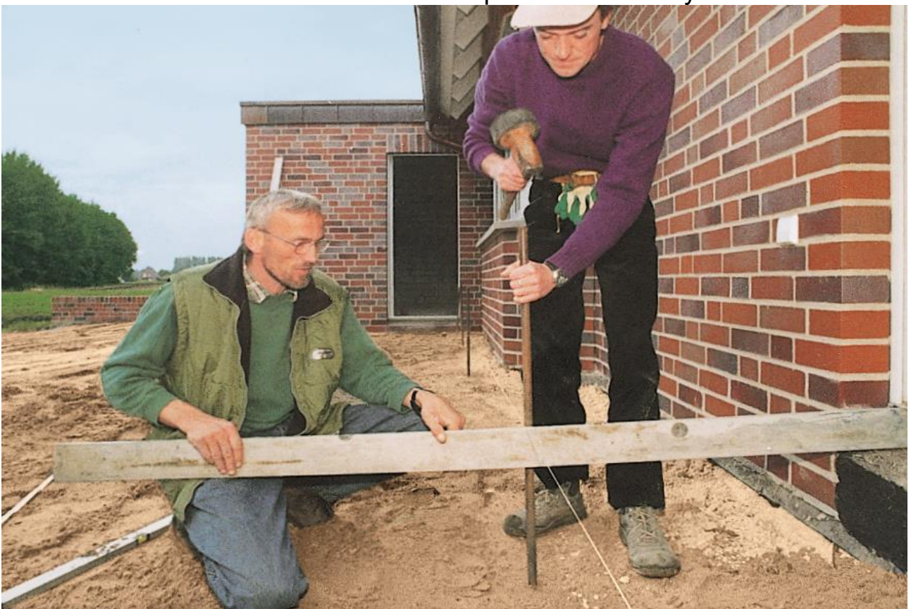
Obrázek 5. - Stanovení spádu pomocí latě a vodováhy
