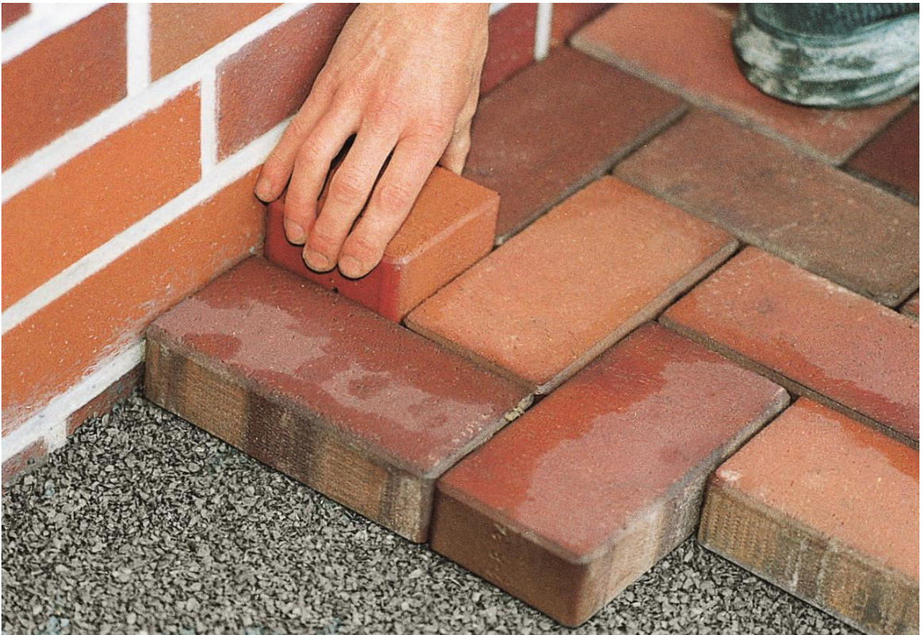
Obrázek 28. - Použití originální půlcihly u okraje dlažby
