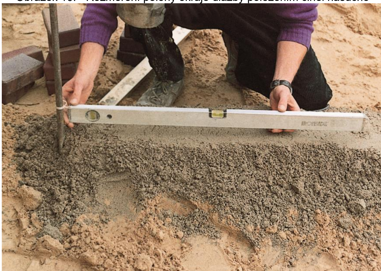
Obrázek 11. - Nivelace betonového lože
