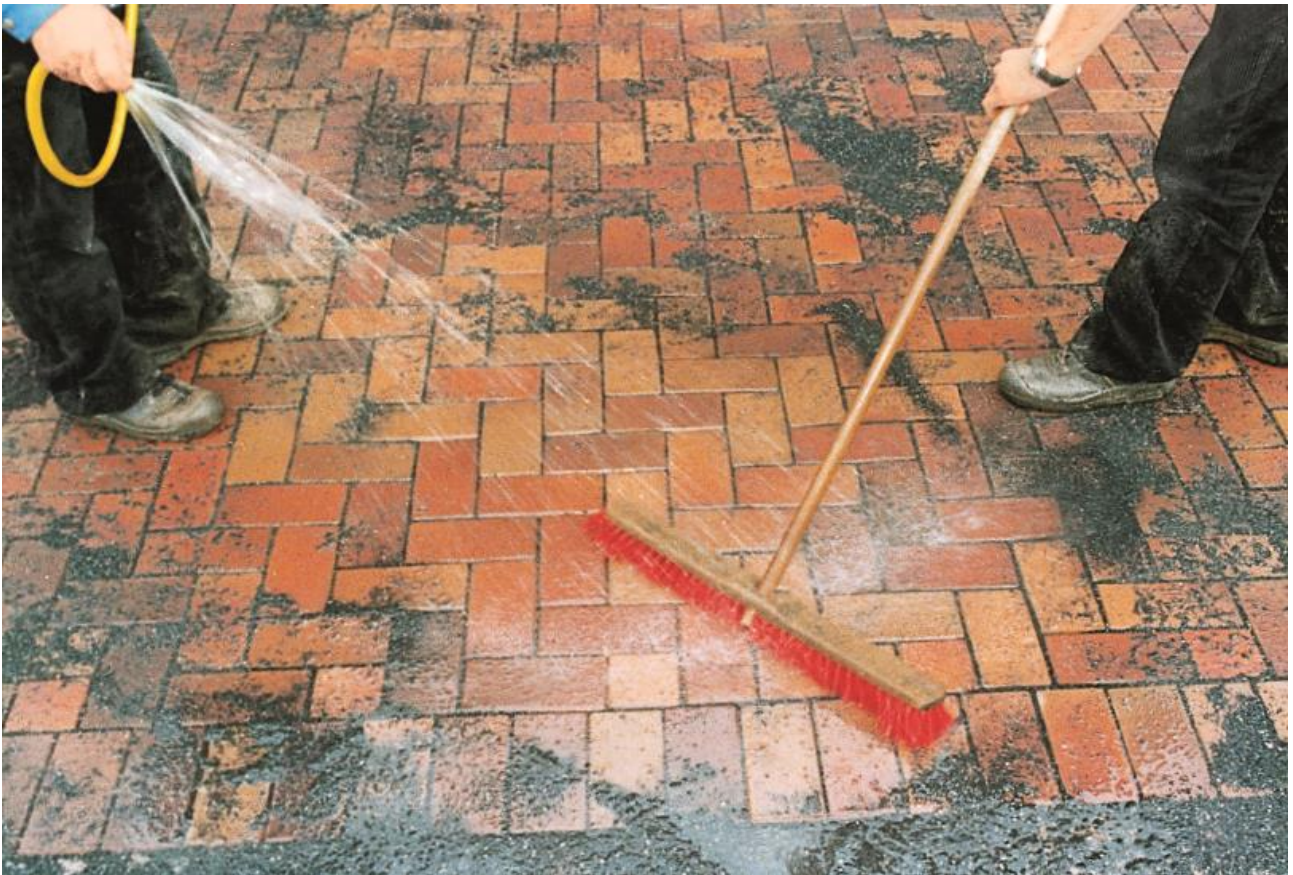
Obrázek 32. - Naplavení písku (drtě) do spár
