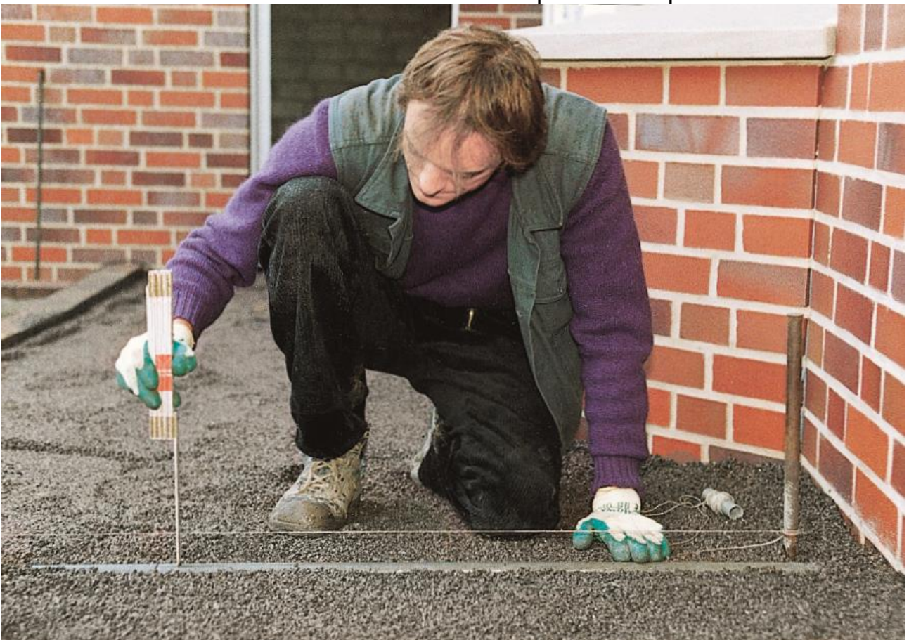
Obrázek 18. - Osazení vodící tyče ve zvoleném spádu
