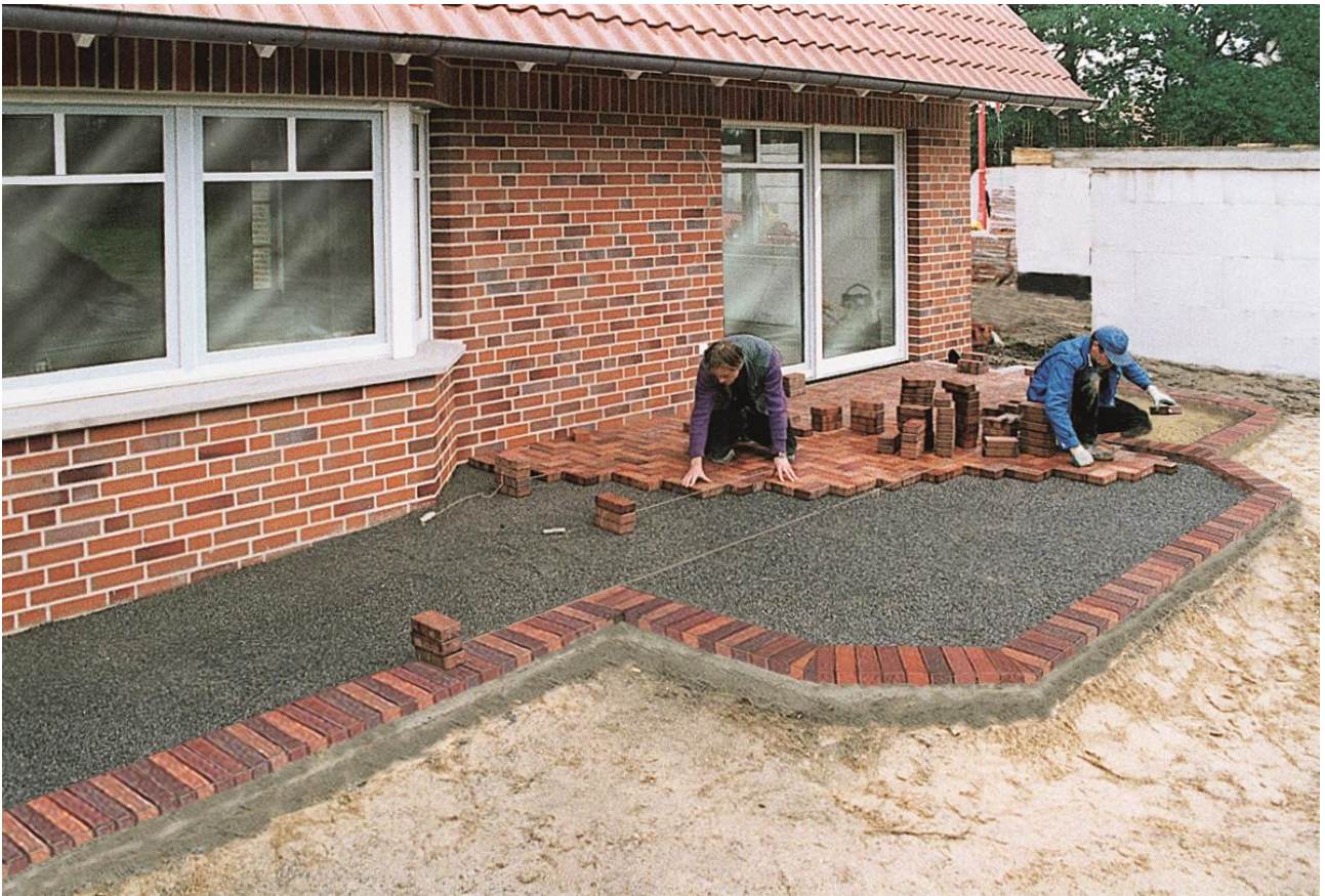
Obrázek 24. - Vytyčení zbytku vzoru dlažby pomocí provázků
