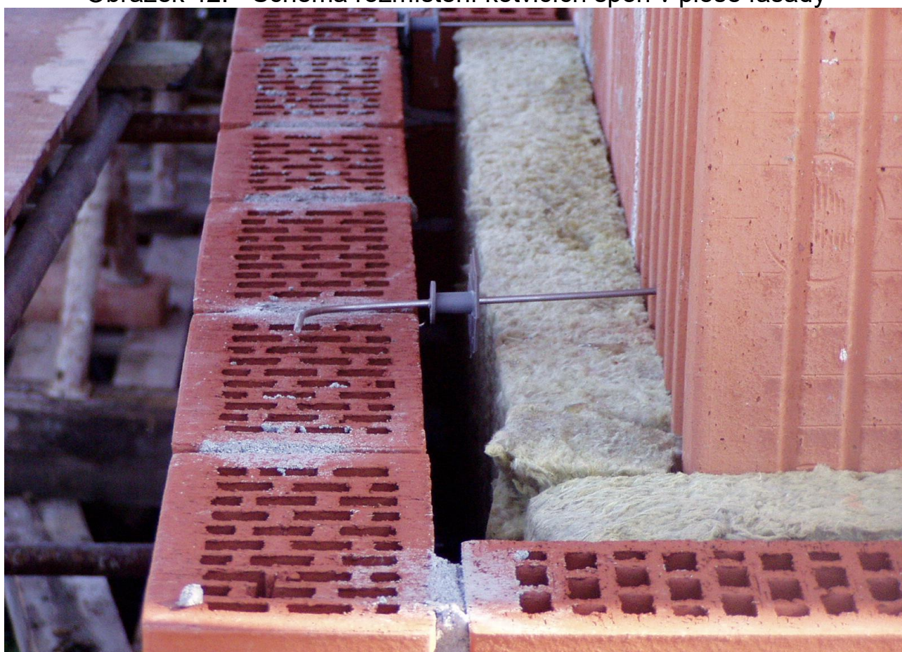
Obrázek 43. - Detail kotvicí spony
