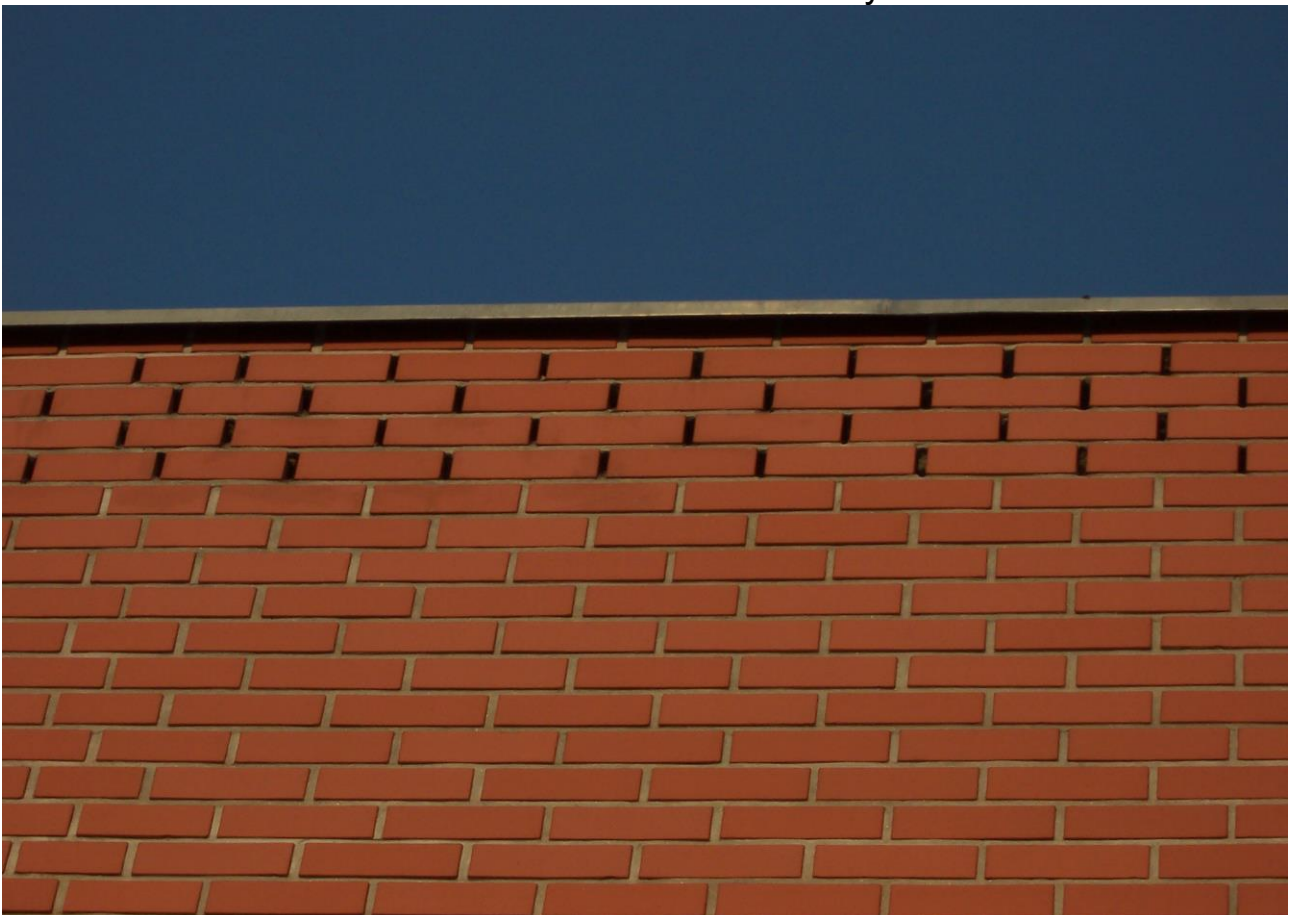
Obrázek 40. - Odváděcí otvory v atice
