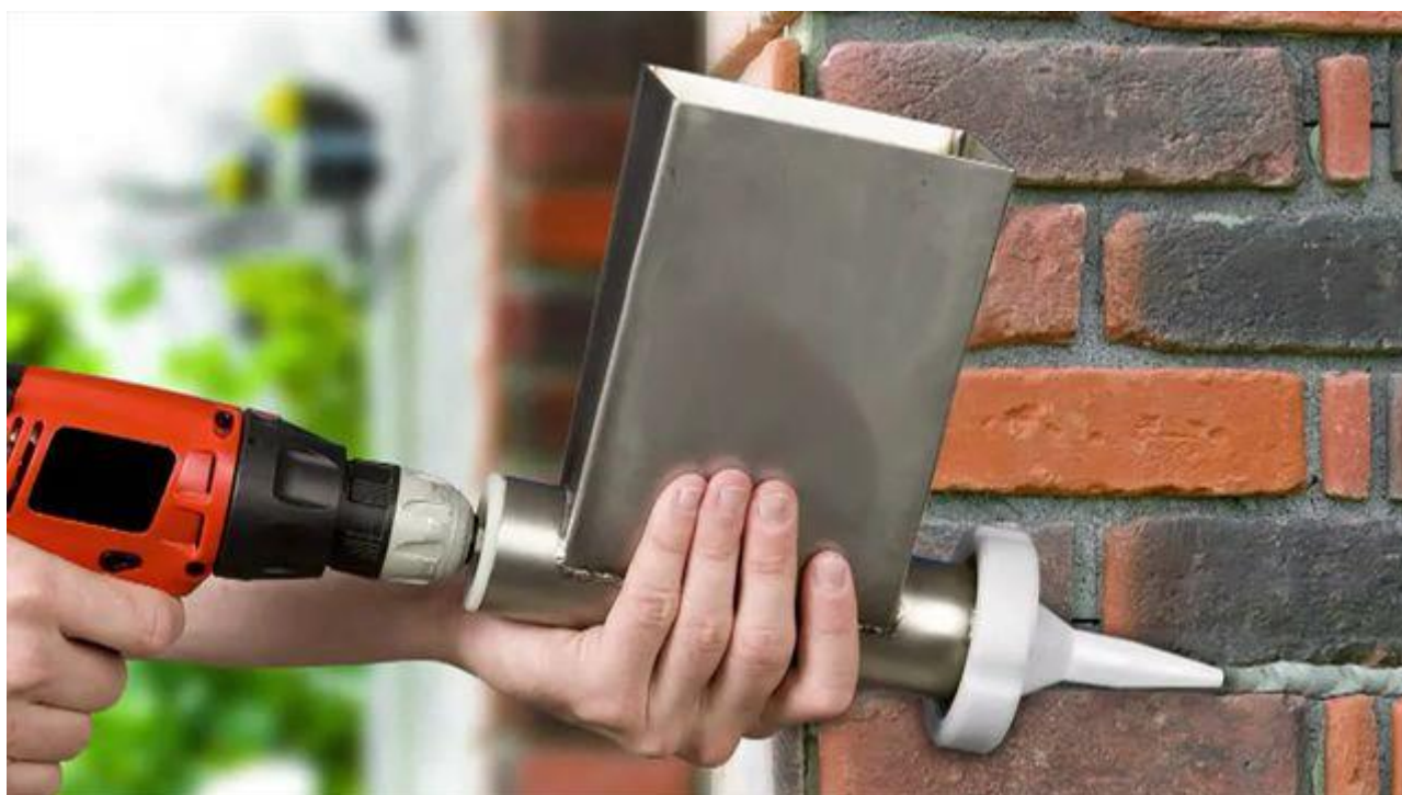
Obrázek 54. - Aplikace spárovací malty šnekovým aplikátorem
