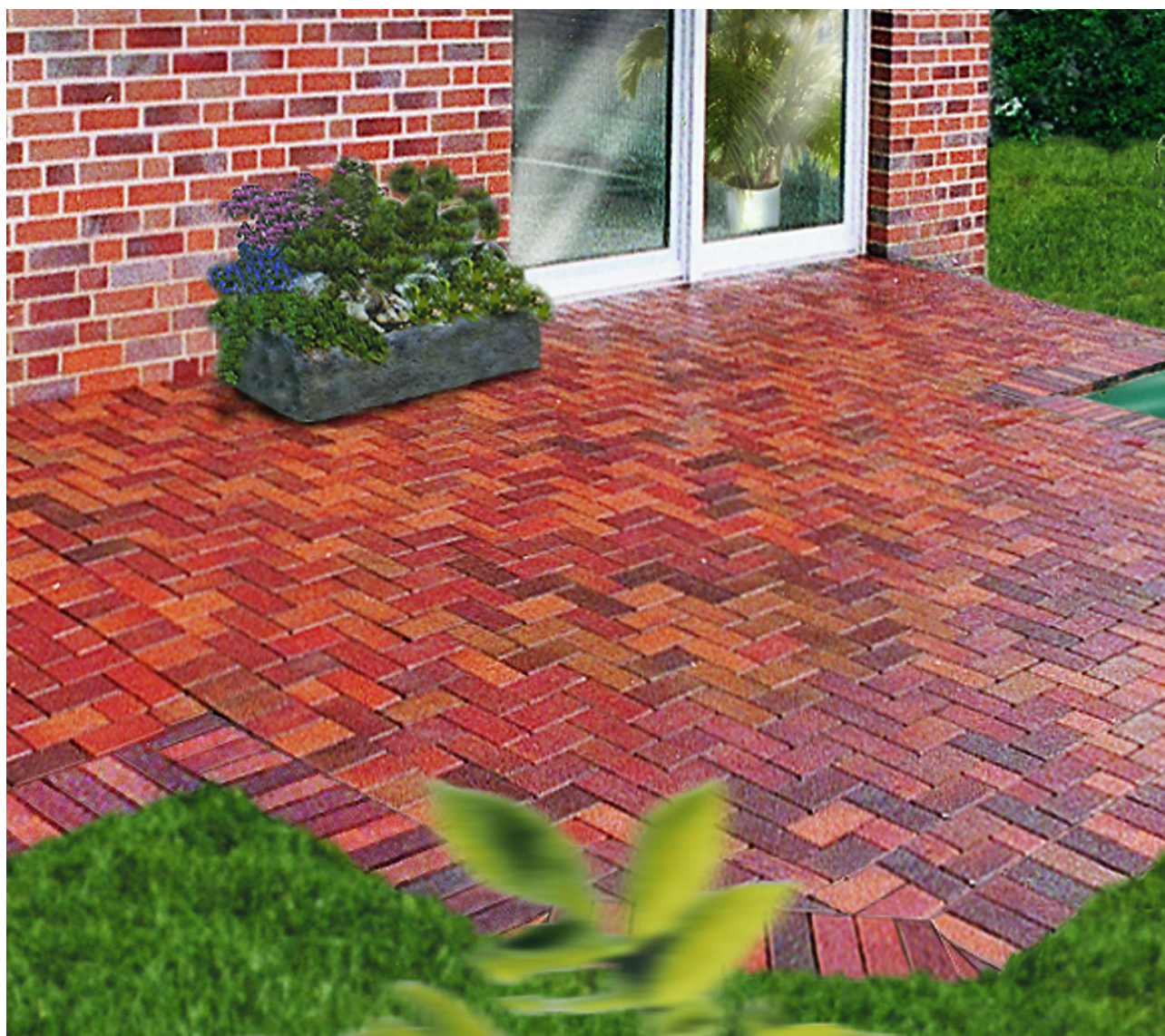
Obrázek 34. - Pohled na hotovou dlažbu
