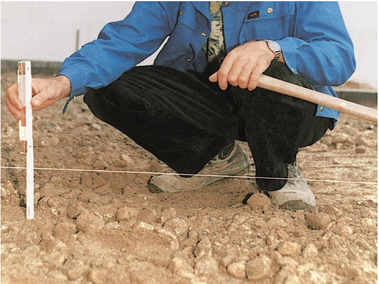
Obrázek 6. - Fixace spádu provázkem
