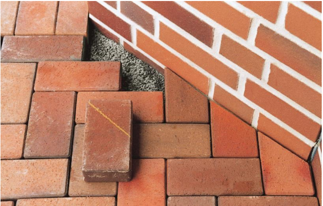
Obrázek 30. – Dořez dlažby v návaznosti na stěnu
