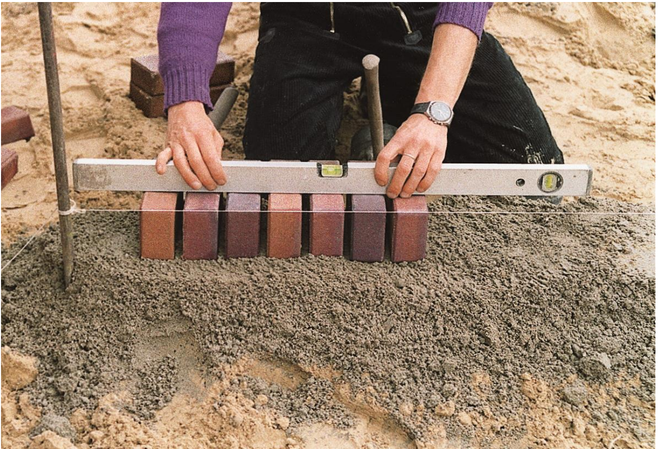
Obrázek 12. - Vytvoření okraje dlažby z cihel nastojato
