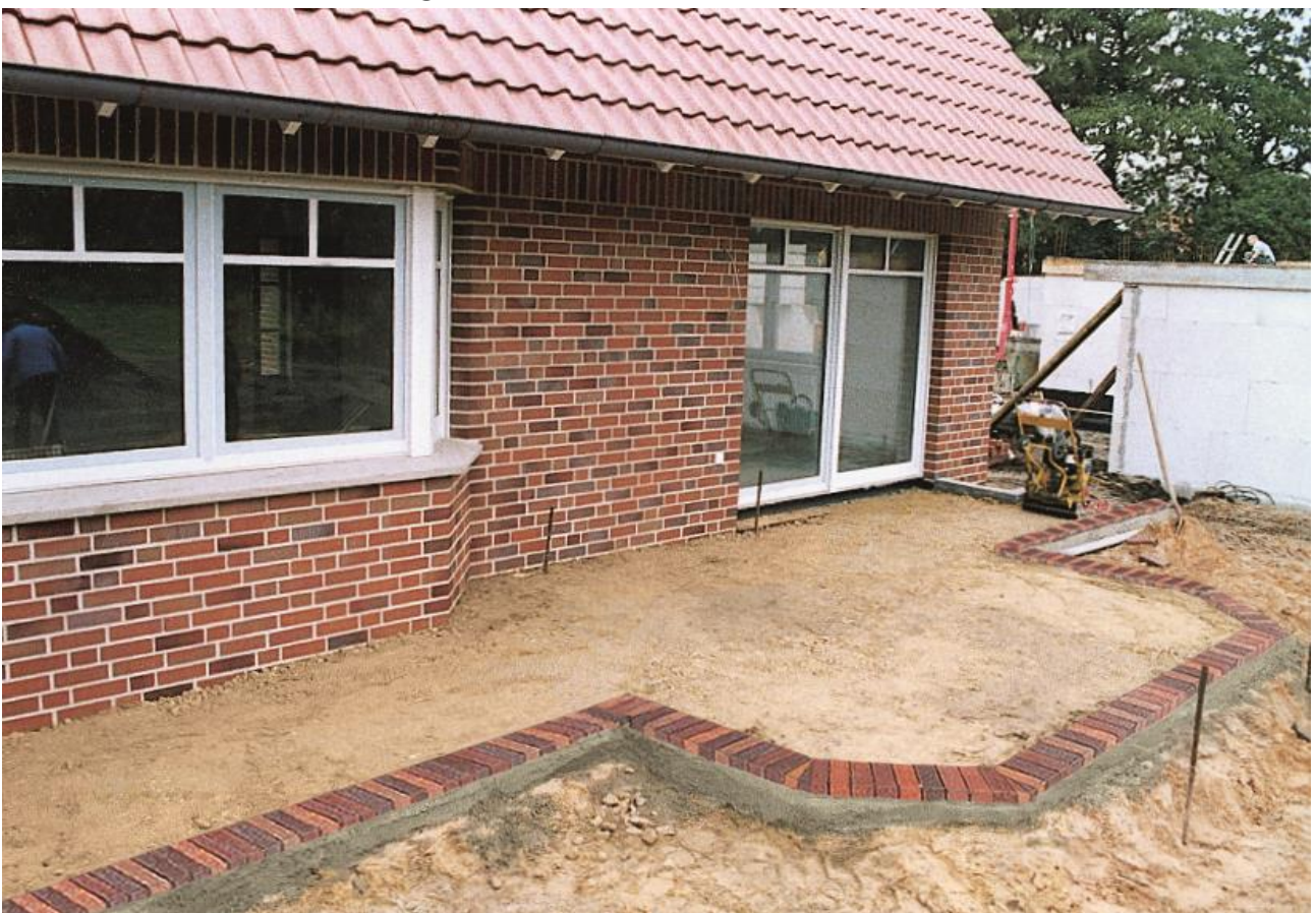
Obrázek 15. - Dokončený okraj dlažby se ztuhnutou nosnou vrstvou
