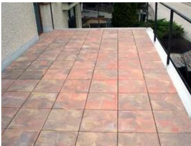
Obrázek 36. - Pohled na hotovou dlažbu na střešní terase
