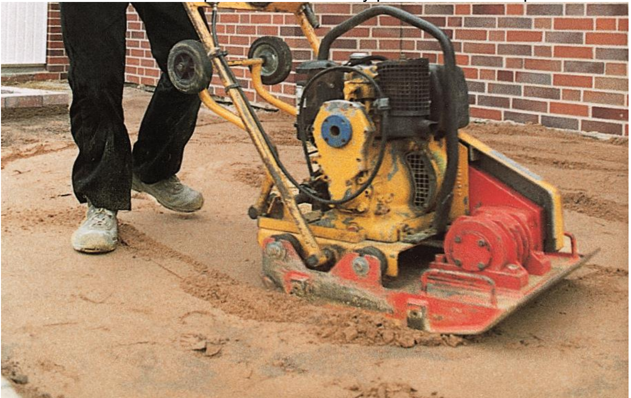
Obrázek 9. - Finální hutnění nosné vrstvy
