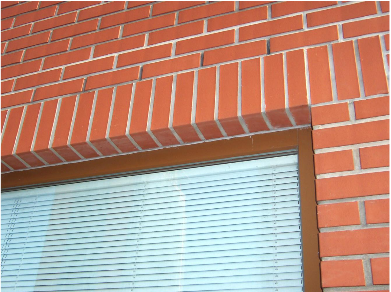
Obrázek 47. - Příklad řešení překladu
