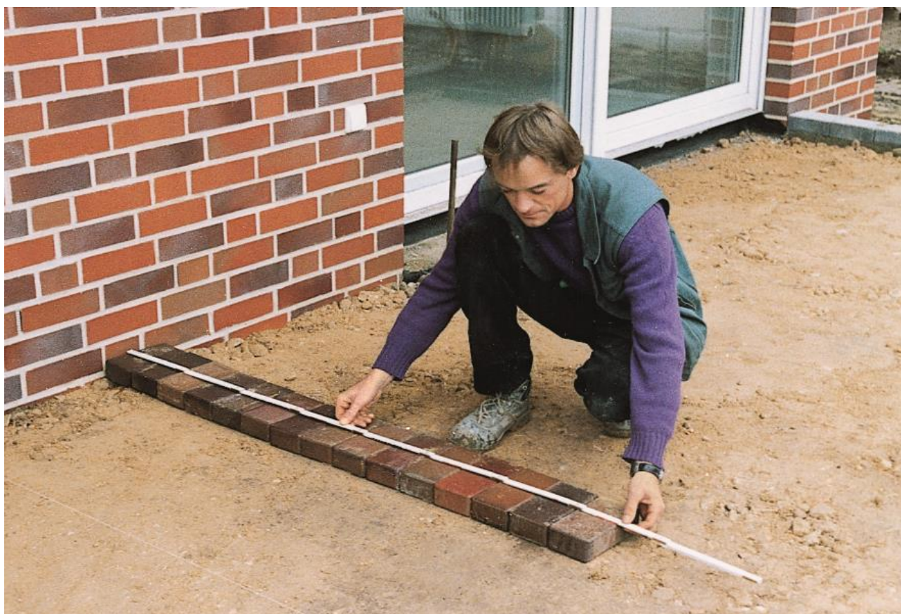
Obrázek 10. - Rozměření polohy okraje dlažby položením cihel nasucho
