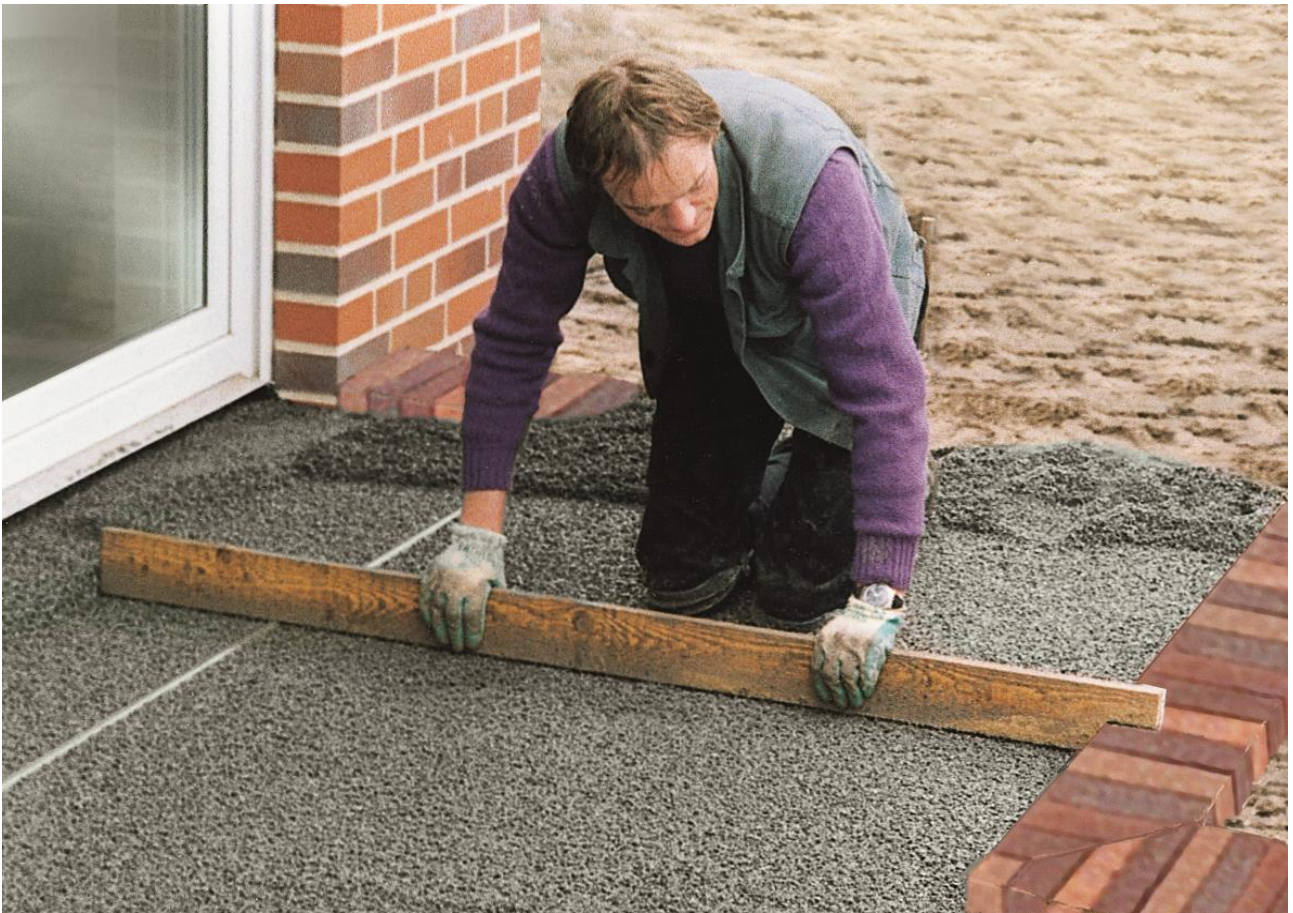
Obrázek 19. - Spádování lože mezi okrajem a vodicí tyčí
