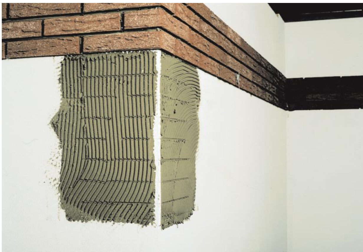
Obrázek 57. - Lepení keramických pásků– roh
