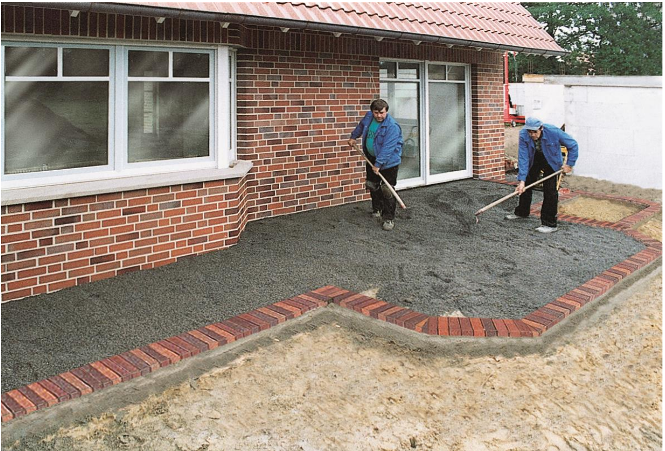
Obrázek 17. - Rovnoměrné rozptření v ploše
