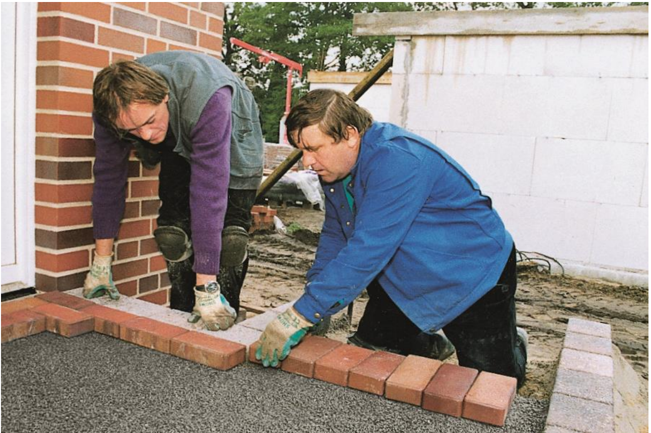
Obrázek 22. - Pokládka první řady cihel na nejvyšší stupeň plánovaného schodiště
