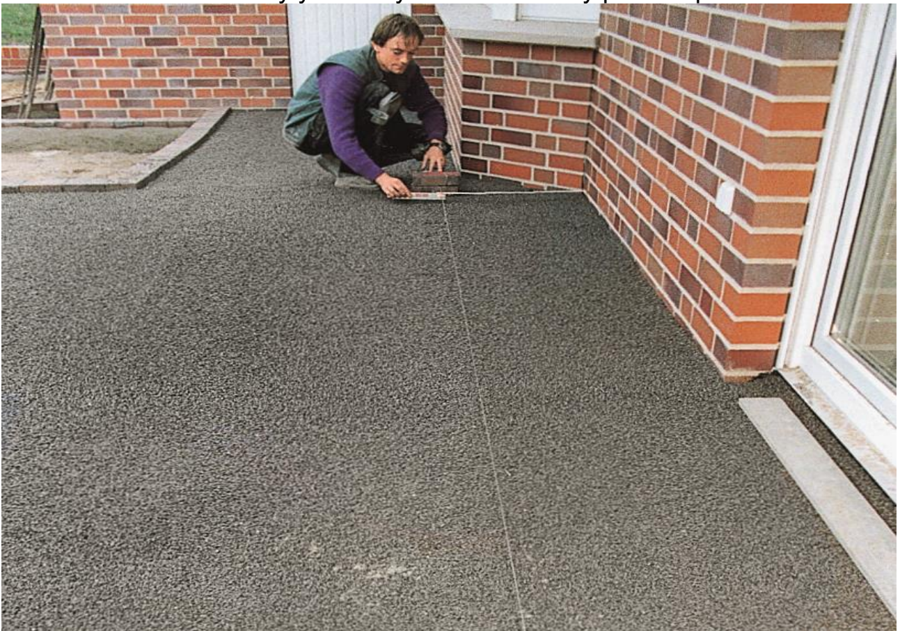
Obrázek 25. - Vytyčení zbytku vzoru dlažby pomocí provázků
