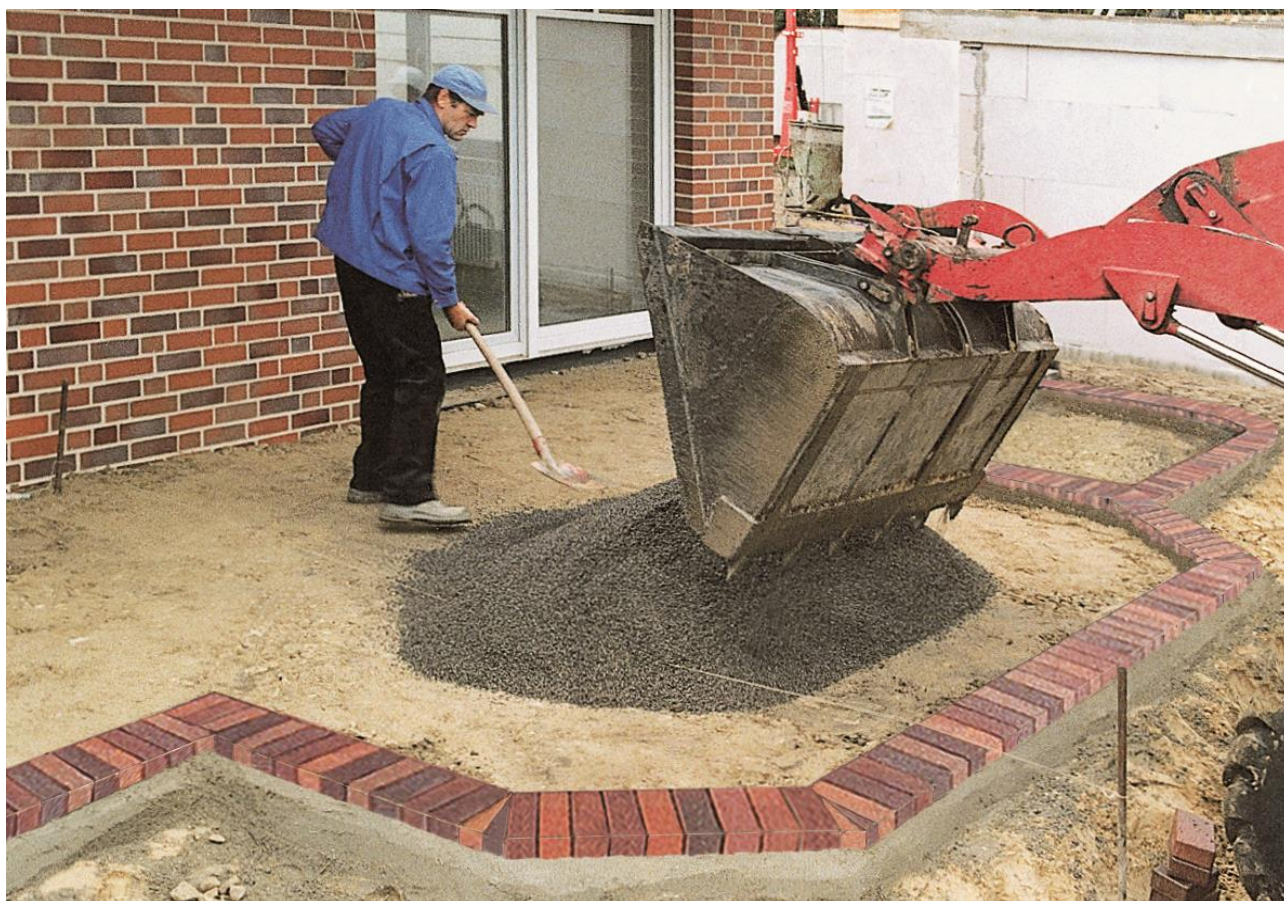
Obrázek 16. - Navezení materiálu pro vytvoření lože
