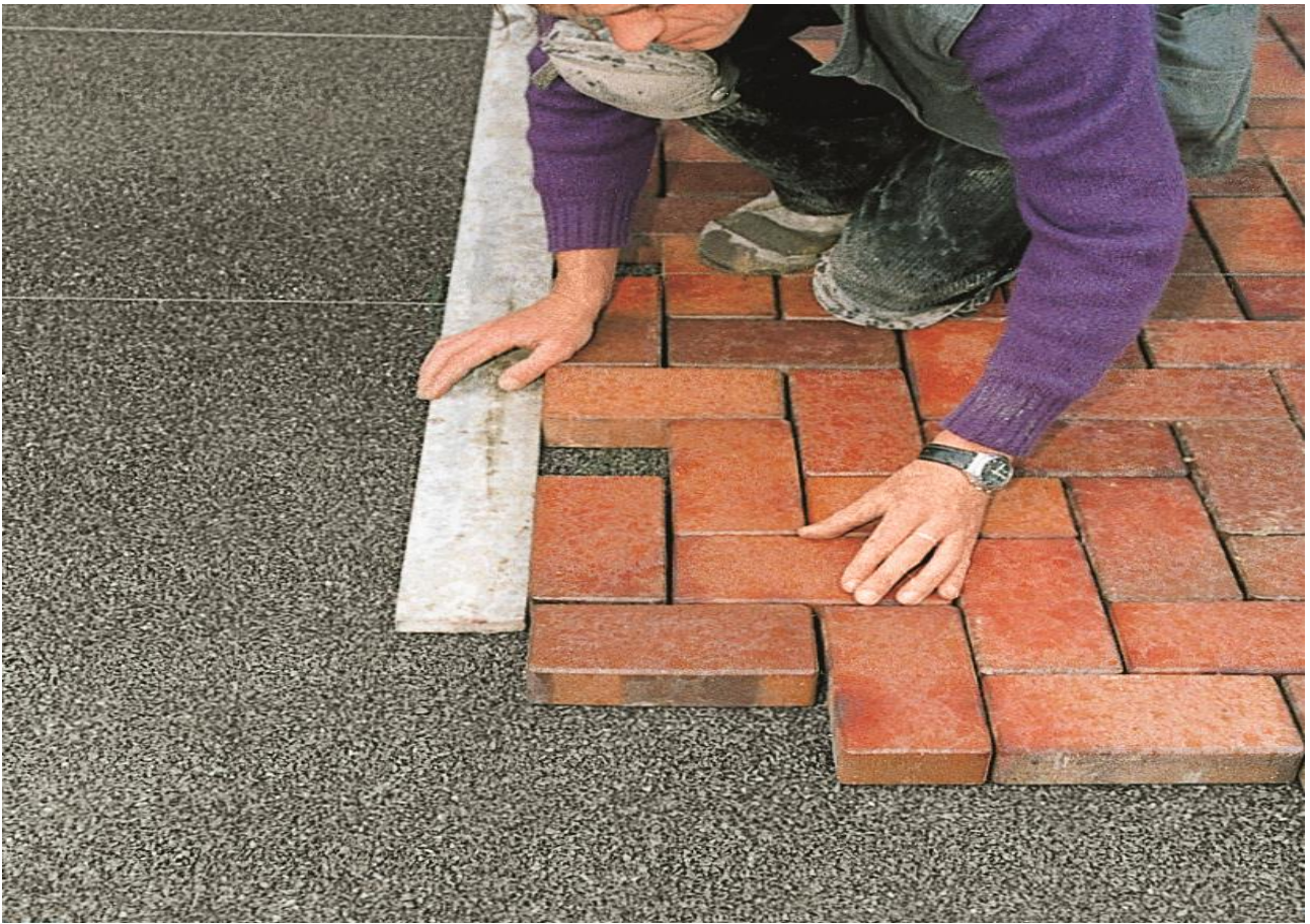
Obrázek 26. - Kontrola lícování dlažby
