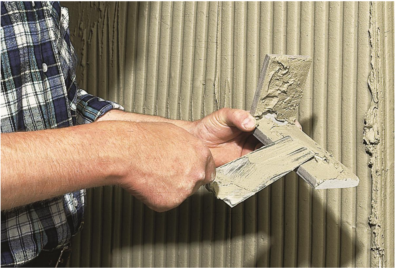
Obrázek 49. - Nanášení lepidla na obě lepené plochy
