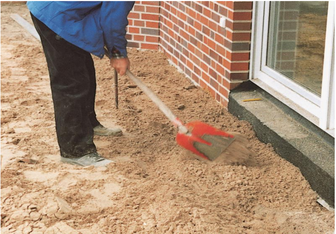
Obrázek 4. - Nanesení první nosné vrstvy
