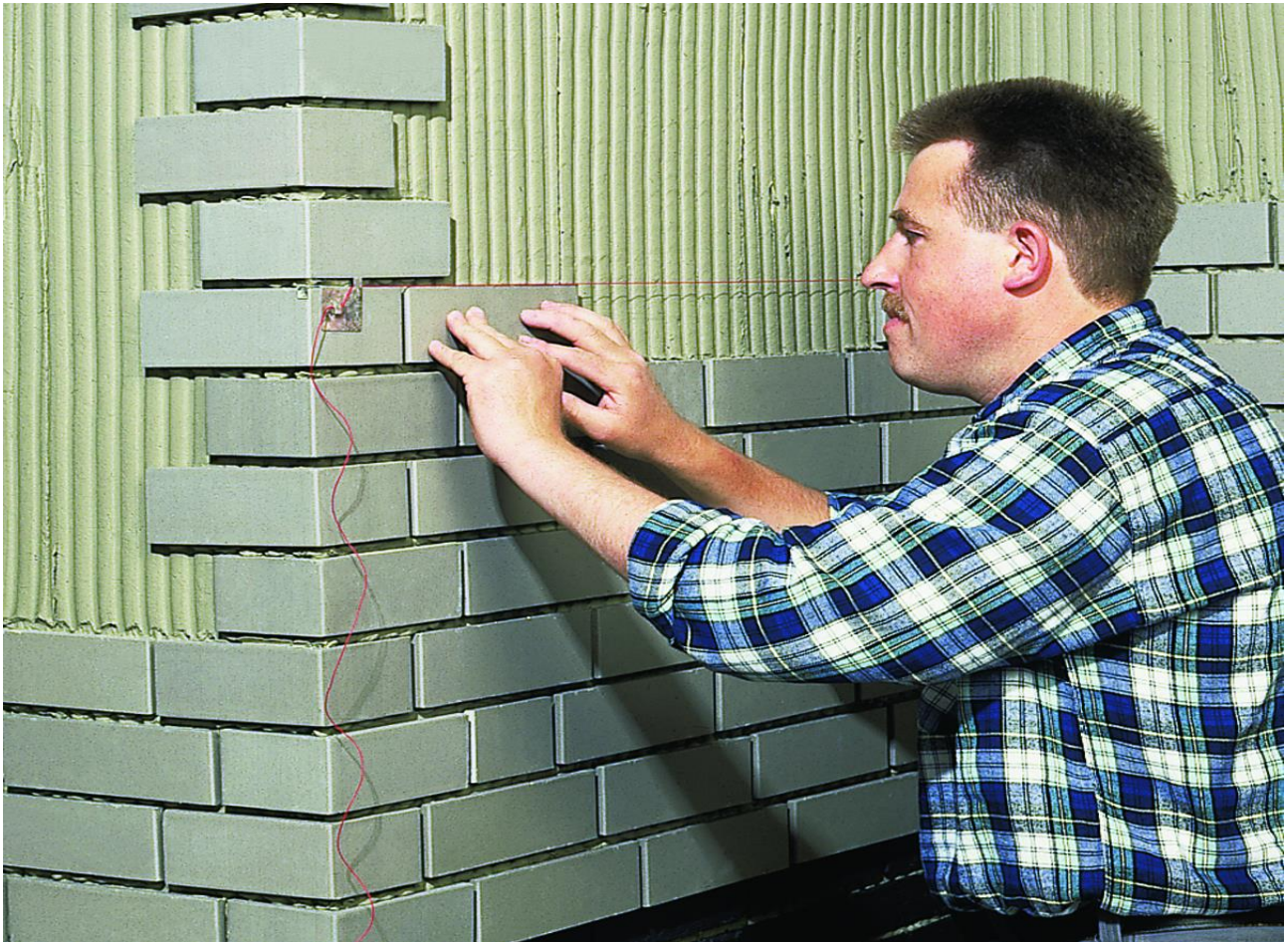
Obrázek 50. - Lepení pásků dle pomocné šňůry
