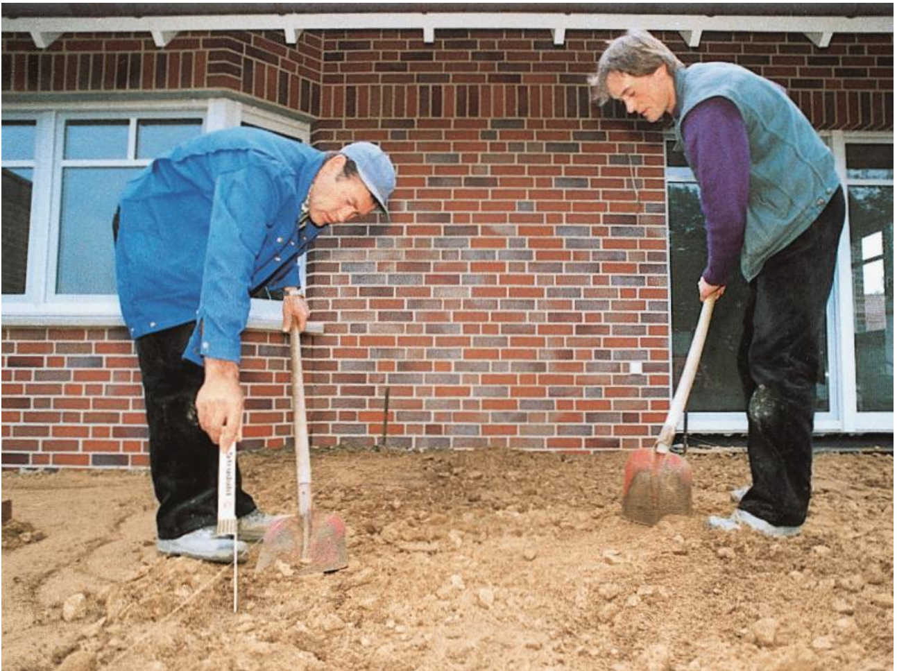
Obrázek 8. - Rozprostření další vrstvy podle zvoleného spádu
