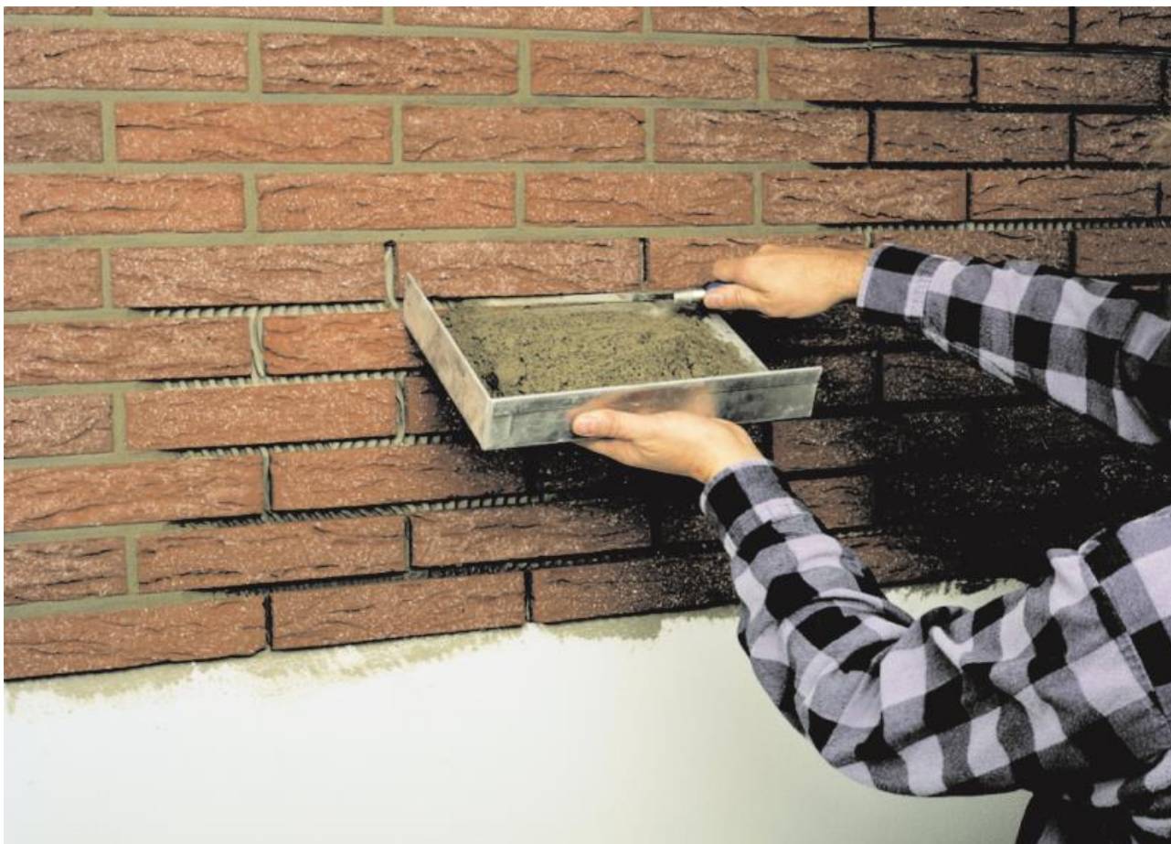
Obrázek 59. - Spárování ocelovou spárovačkou
