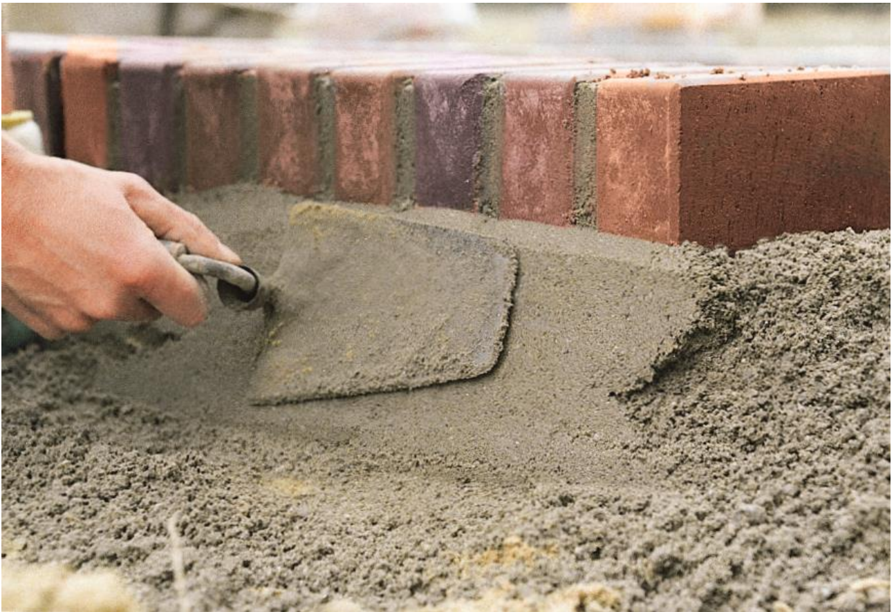
Obrázek 14. - Tvarování lože
