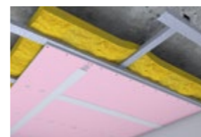
DEK PODHLED PH.1003A exteriér, cementovláknité desky, tenkovrstvá omítka, přímo montovaný
