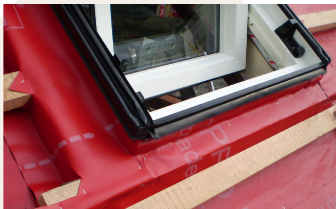
Napojení doplňkové hydroizolační vrstvy na rám okna
