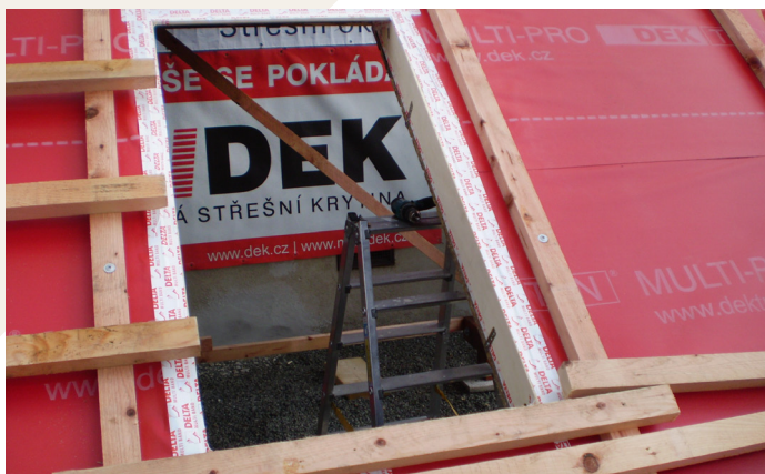
Ukončení pojistné hydroizolace na dílci
