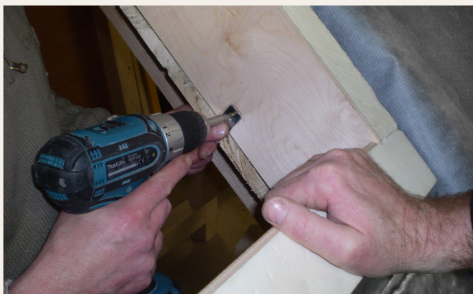
Upevnění dílce k bednění
