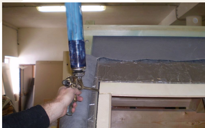
Vyplnění spár montážní pěnou
