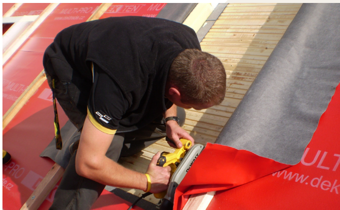
Upevnění dílce k bednění
