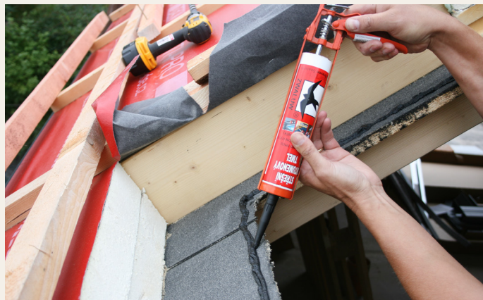
Vyplnění spár montážní pěnou
