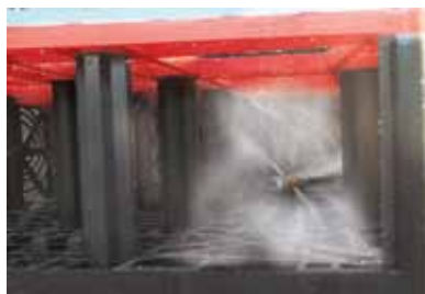
Čištění vsakovací galerie
