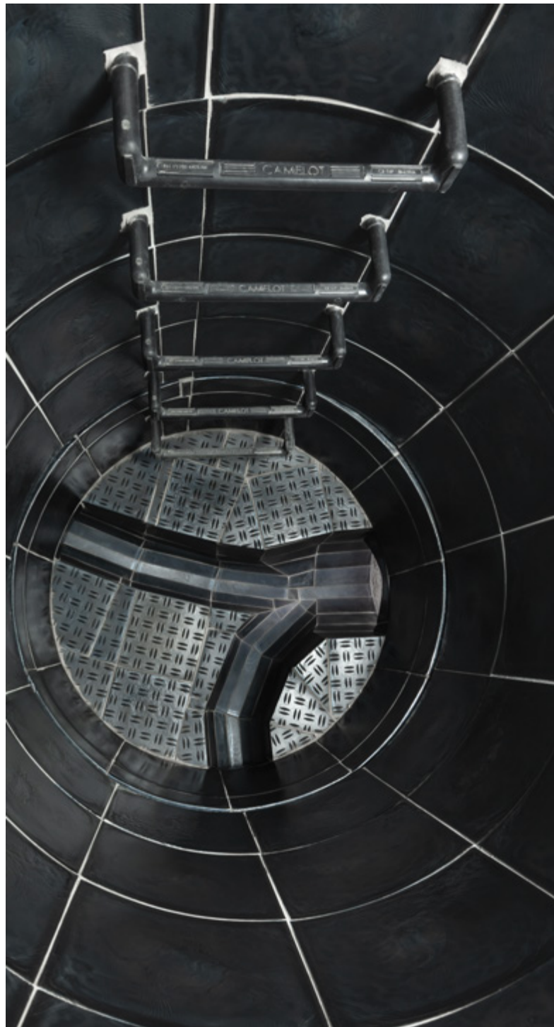
Vnitřní obklad spadištvé šachty čedičem
