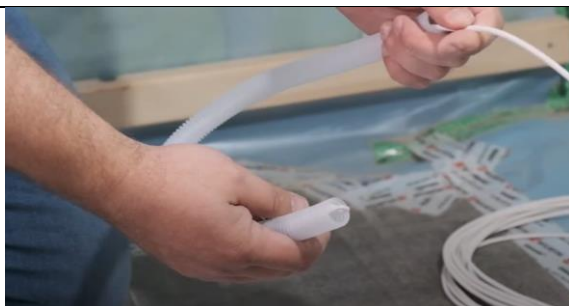
3. Zasuňte senzor s kabelem do chráničky. Senzor musí být v místě vytvořených otvorů.
