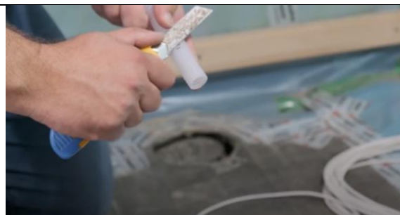
2. Seřízněte povrch konce chráničky tak, aby se ve stěnách vytvořily malé otvory.
