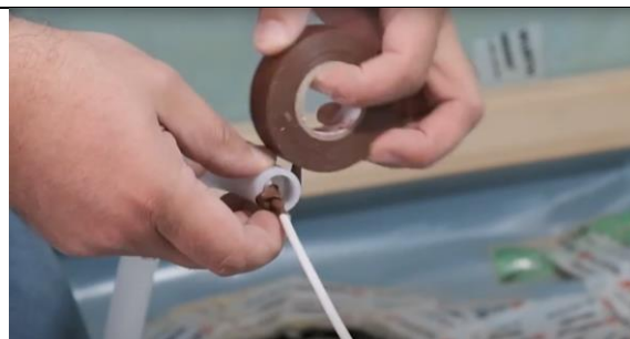
4. Na druhém konci upevněte kabel páskou. Senzor se nebude v chráničce posouvat.
