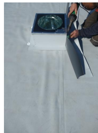
Krok 7 - napojení hydroizolace střechy na střešní základnu
