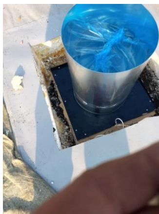
Krok 4 - usazení Thermoizolačního prvku do parotěsného tmelu
