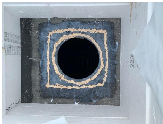
Krok 3 - nanesení parotěsného tmelu
