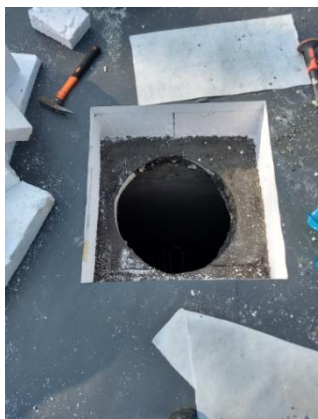
Krok 1 – vyřezání tepelné izolace dle velikosti Thermoizolačního prvku
