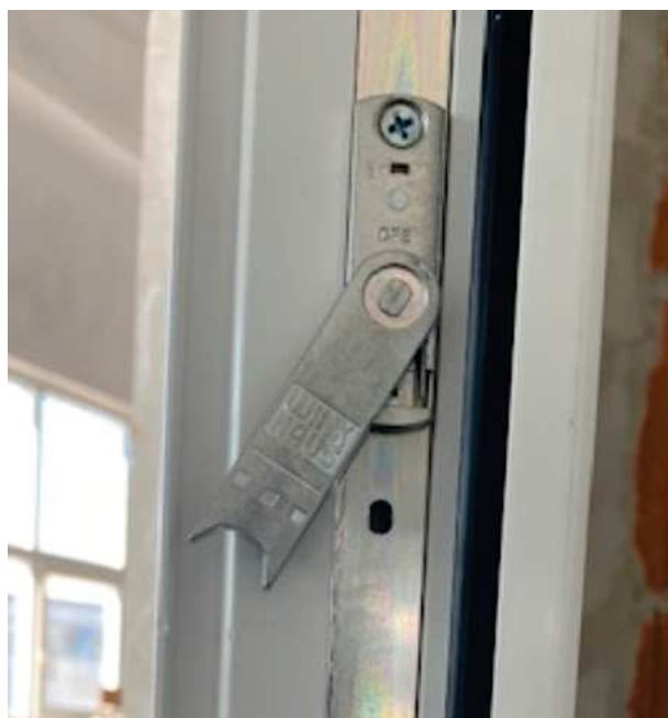
Obr. 90 – Pojistka proti chybné manipulaci kliky
