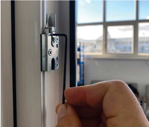
Obr 75 – Svislý posun protiplechu pojistky proti chybné manipulaci
