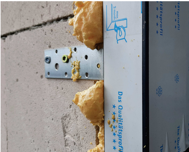
Obr. 66 – Kotvení HST portálu na exteriérové straně
