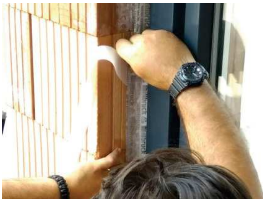
Obr. 45 – Nalepování exteriérové těsnicí fólie
