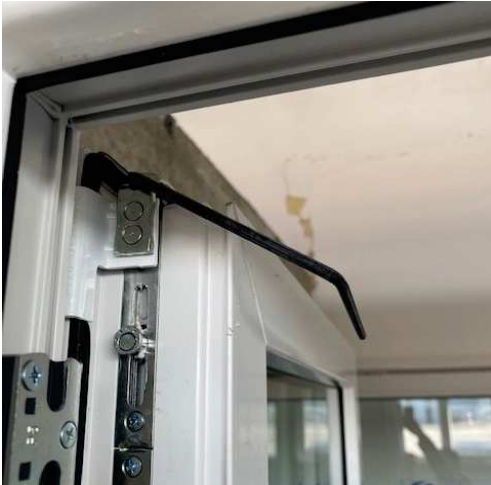
Obr. 71 – Vodnorodný posun horní části křídla
