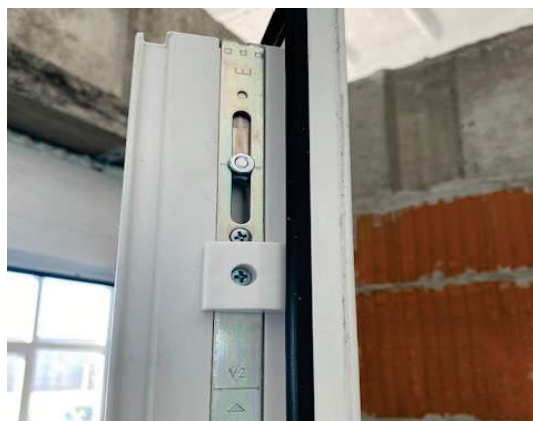
Obr. 77 – Čep kování na křídle, pod čepem bílý náběhový klínek PVC
