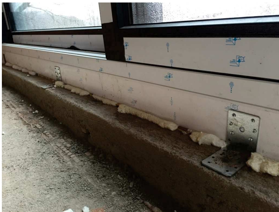
Obr. 60 – Provedení betonového prahu pod portálem v dostatečné šířce pro kotvení
