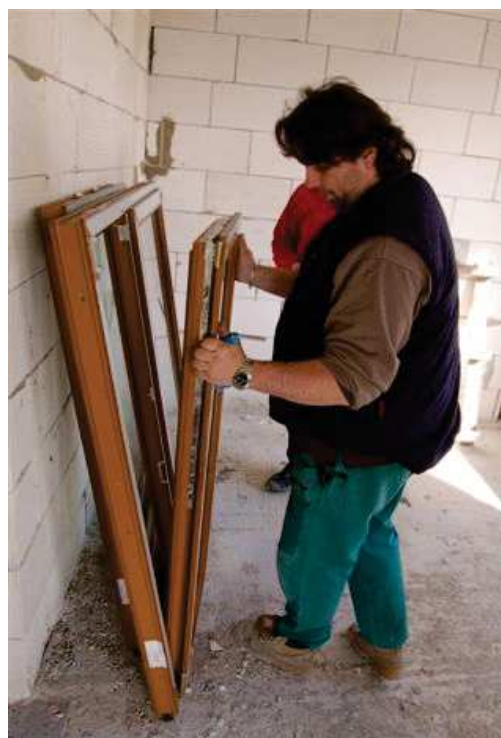
Obr. 22 – Vyjmutí křídla z rámu
