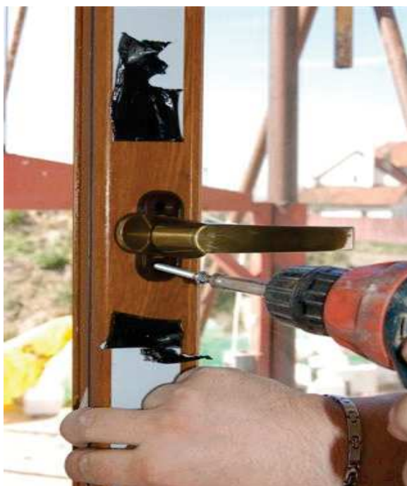
Obr. 47 – Osazení krytek na okno
