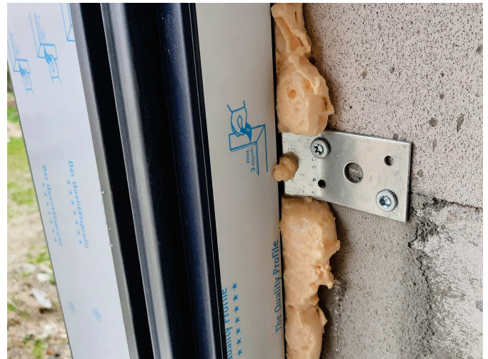
Obr. 67 – Kotvení HST portálu na interiérové straně
