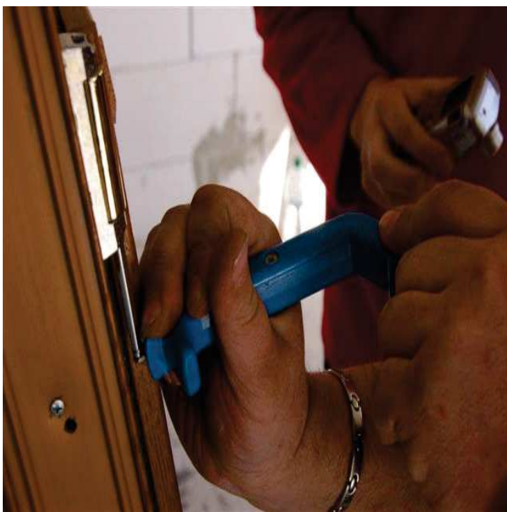
Obr. 21 – Vytažení závlačky z horního závěsu
