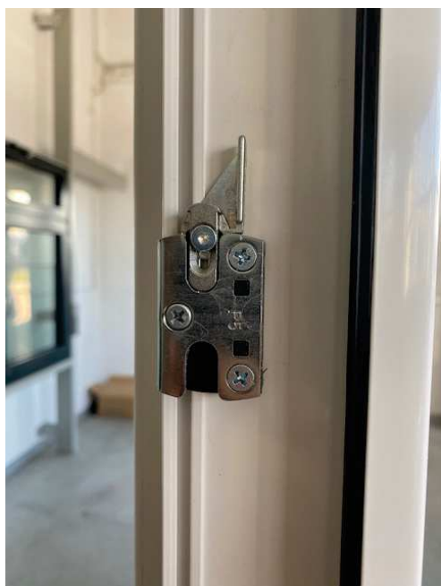
Obr. 89 – Protiplech balkónové pojistky v uzávěru
