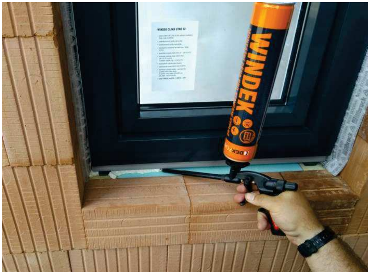
Obr. 43 – Vyplnění přípojovací spáry pěnou DEKFOAM WINDEK
