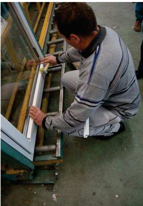
Obr. 98 – Osazení vodorovné zasklívací lišty
