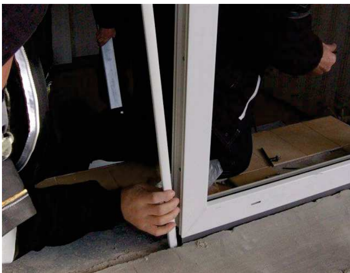
Obr. 13 – Vložení spojovacího profilu
