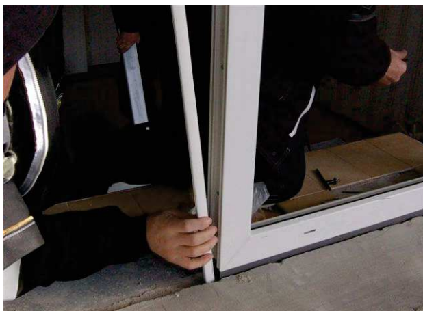
Obr. 50 – Osazení spojovacího profilu
