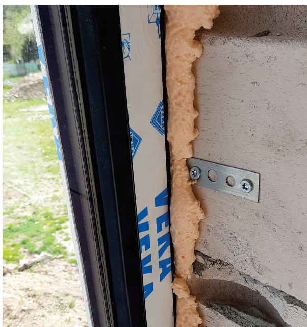
Obr. 39 – Připevnění okenní pásové kotvy do ocelové výztuhy rámu
