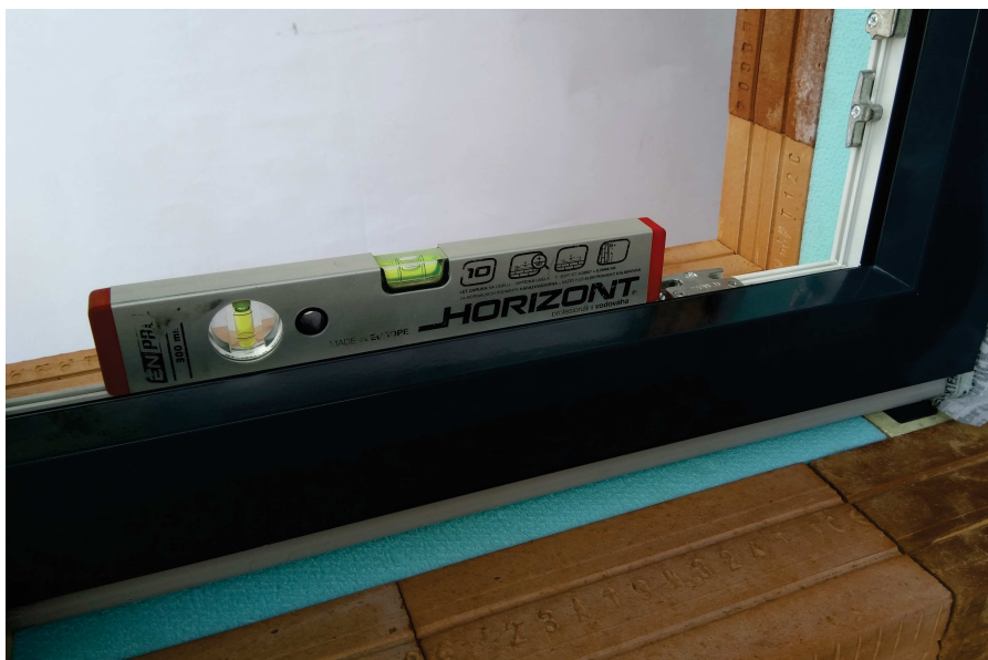
Obr. 30 – Kontrola vyrovnaní pomocí vodováhy
