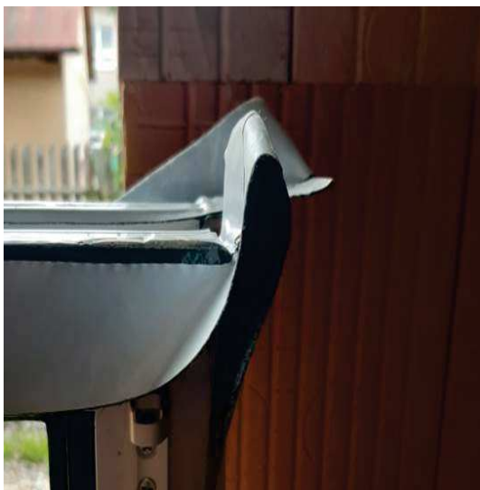
Obr. 24 – Nařazení těsnicí fólie v rohu
