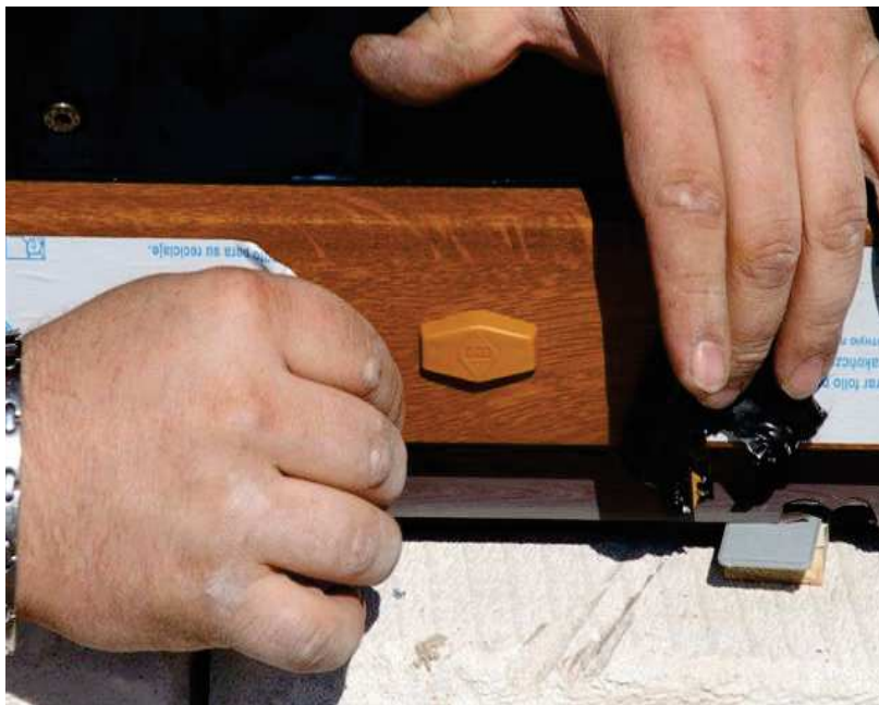
Obr. 47 – Osazení krytek na okno
