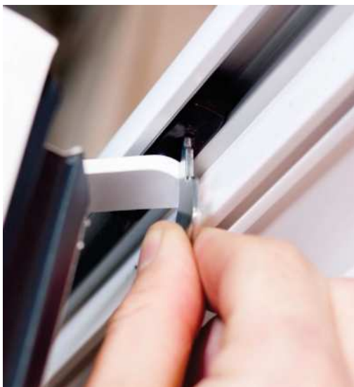
Obr. 56 – Odjištění horního pojezdu ve vodící liště
