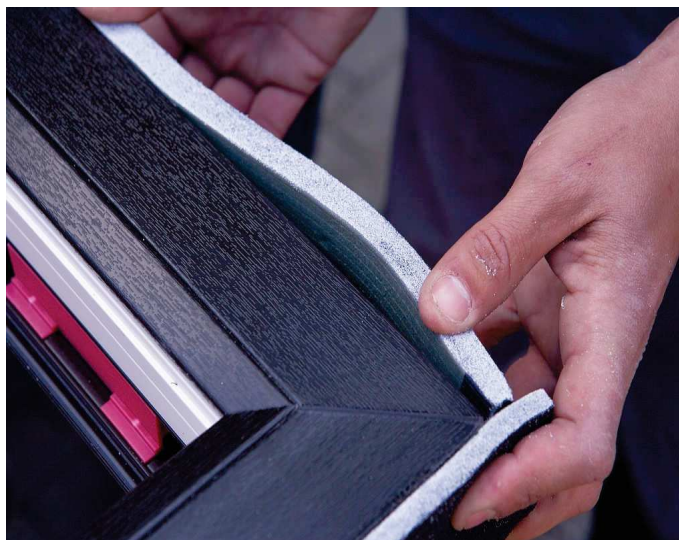
Obr. 27 – Provedení komprimační pásky na rohu výplně
