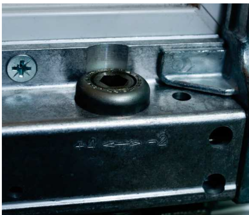
Obr. 59 – Servisní šroub na vozíku spodního pojezdu
