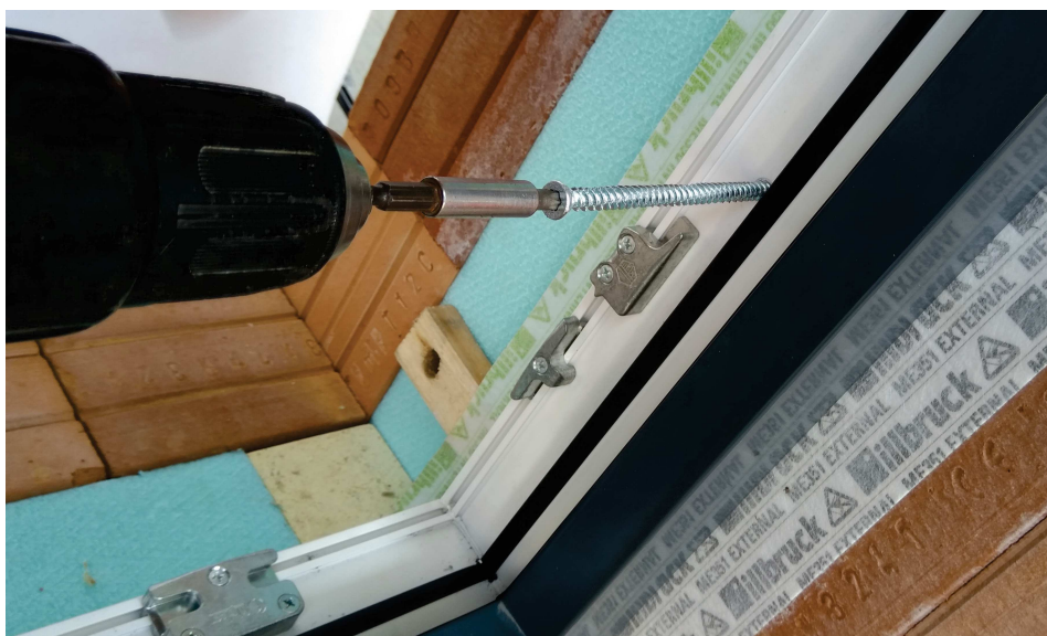
Obr. 38 – Kotvení okna pomocí turbošroubu
