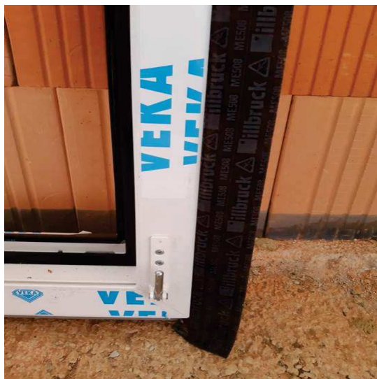
Obr. 25 – Nalepená těsnicí fólie na rámu
