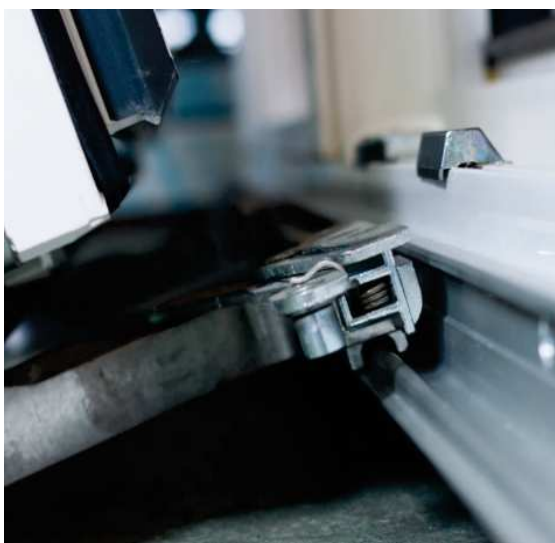
Obr. 58 – Uvolněná kolejnice spodního pojezdu po naklonění křídla
