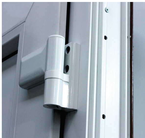
Obr. 54 – Předvrtané montážní otvory
