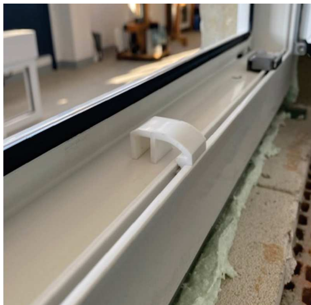
Obr. 18 – Plastový přepravní klínek osazený na okně
