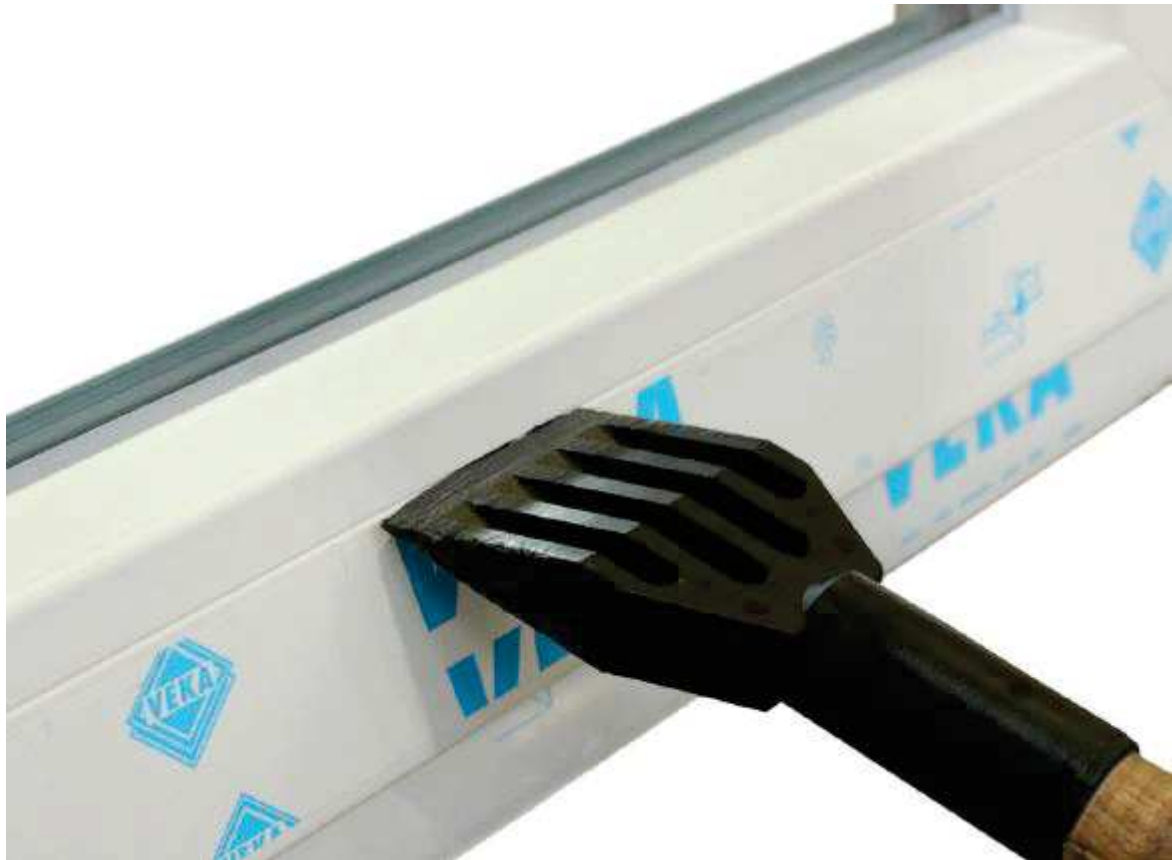
Obr. 91 – Demontáž zasklívací lišty pomocí zasklívací lopatky
