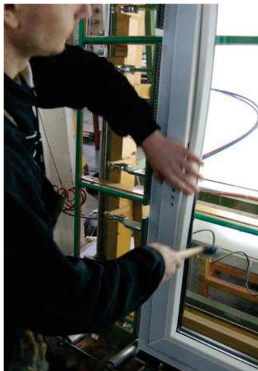
Obr. 99 – Osazení svislé zasklívací lišty
