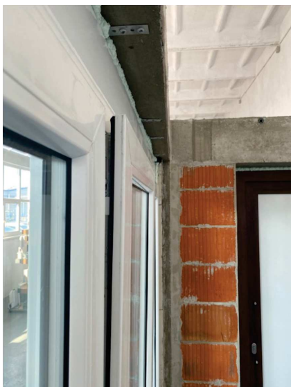
Obr. 85 – Maximální odsunutí mikroventilace křídla
