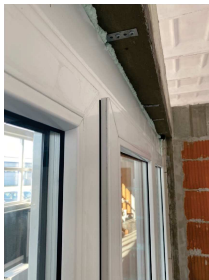
Obr. 86 – Minimální odsunutí mikroventilace křídla
