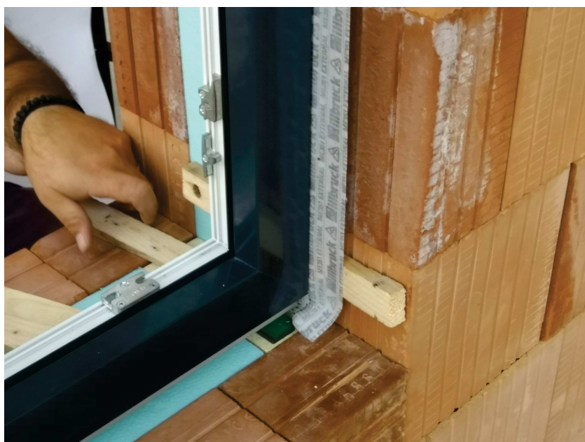
Obr. 29 – Pracovní zaaretování pomocí dřevěných klínů
