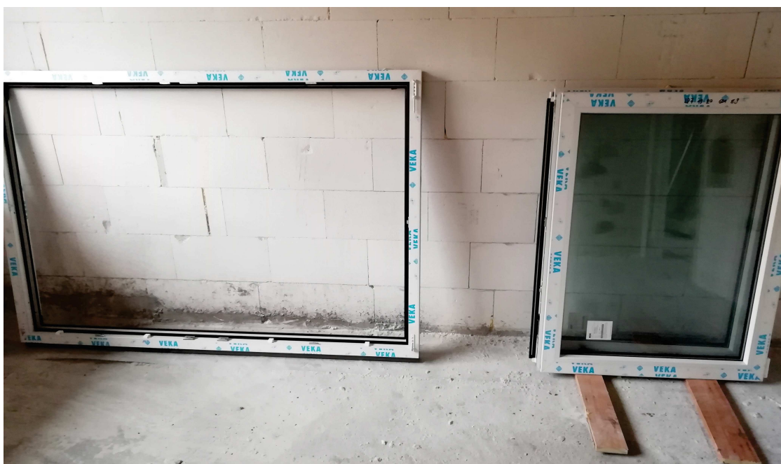
Obr. 19 – Správné uložení na stavbě – rám je uložen na podkladní profil a křídlo na hladké a čisté podložce a mezi rámy a zdívem je EPS podložka
