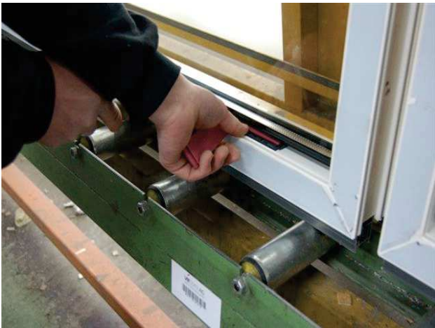
Obr. 96 – Vkládání podložek do rámu křídla
