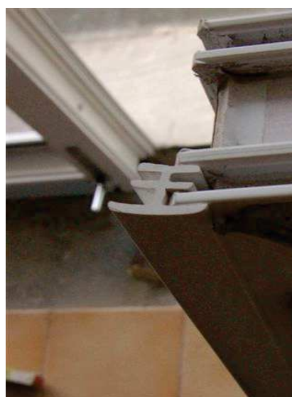
Obr. 14 – Detail osazeného spojovacího profilu
