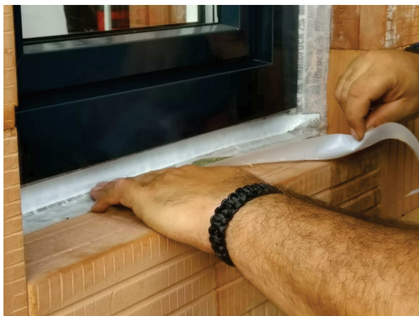
Obr. 46 – Nalepování těsnicí fólie v parapetní části
