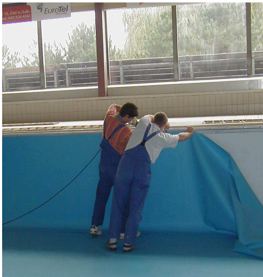
Foto 5. Provádění stěny bazénu.
