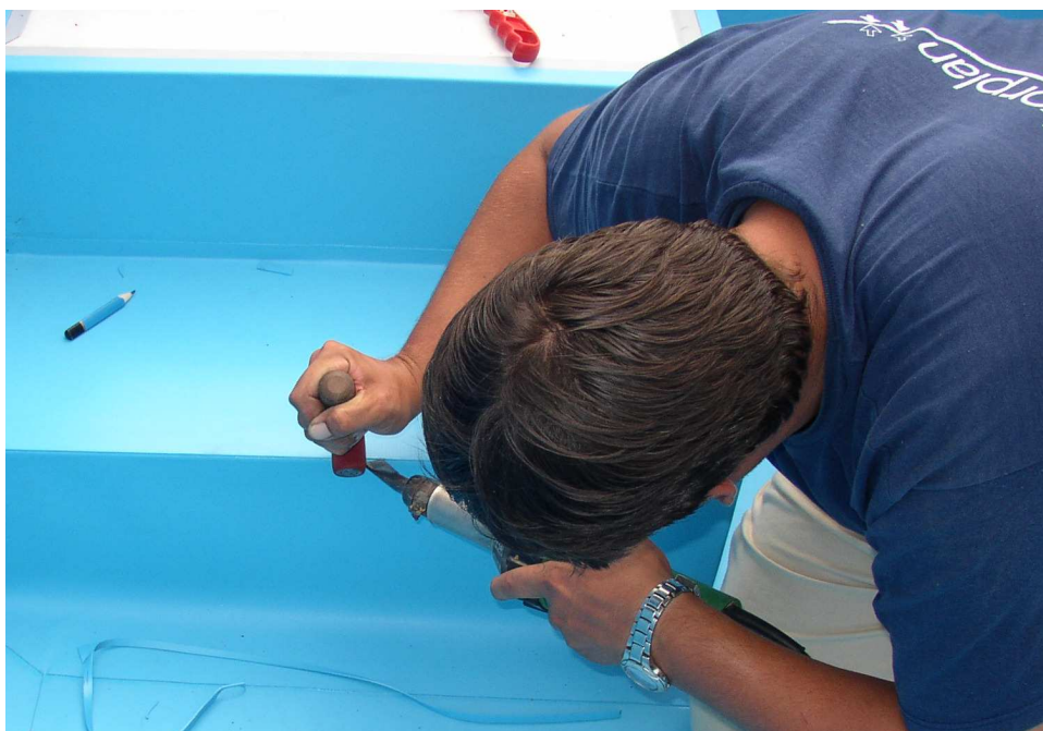
Foto 17. Zaoblění stříhaného okraje fólie na hraně schodu.
