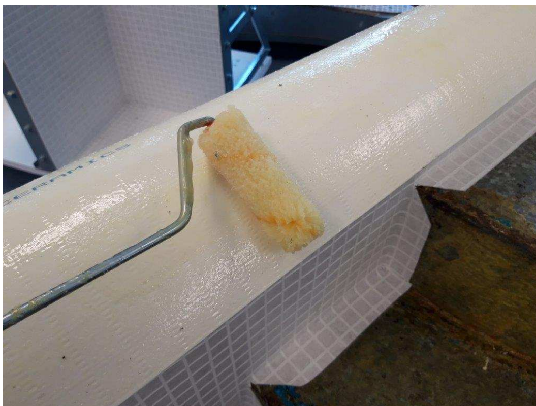
Foto 12. Nanášení lepidla na fólii
