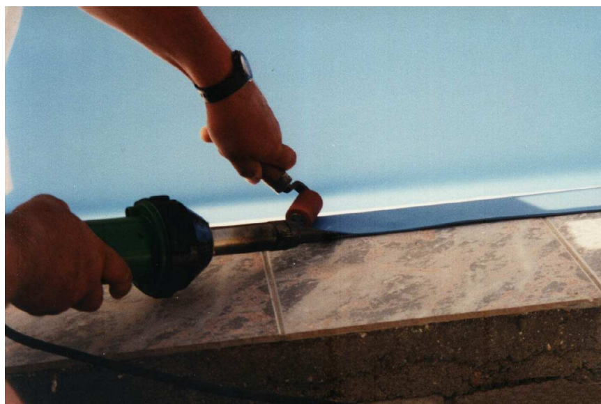
Foto 1. Navařování fólie na profil z poplastovaného plechu
