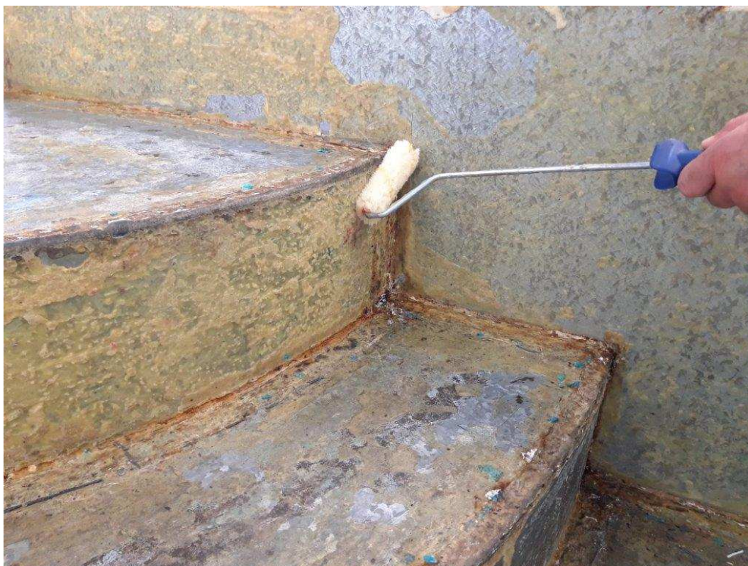
Foto 7. Nanášení lepidla na podklad
