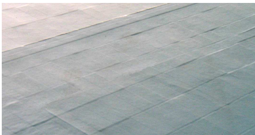
Foto 4. Prokreslení staré dlažby na povrch fólie.
