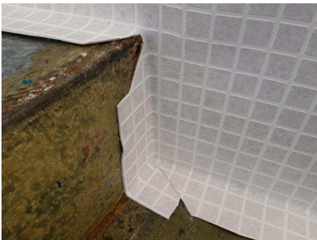
Foto 9. Svaření fólie v detailu
