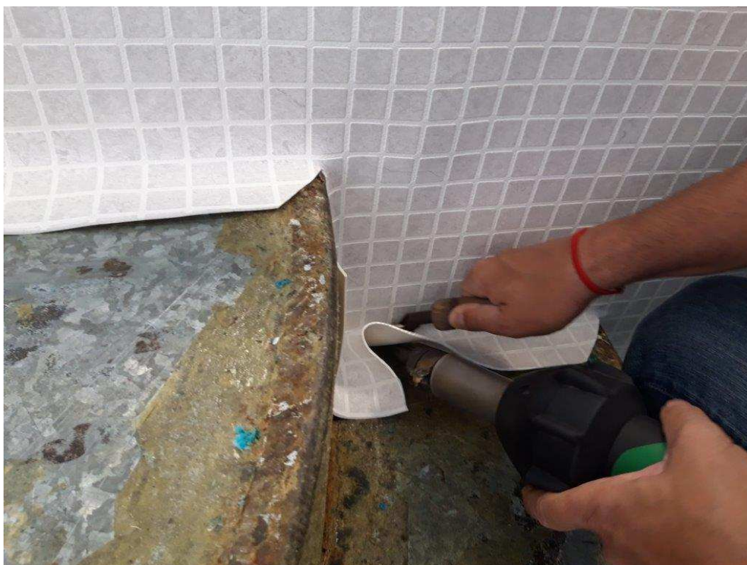
Foto 8. Přivaření fólie do hrany schodů
