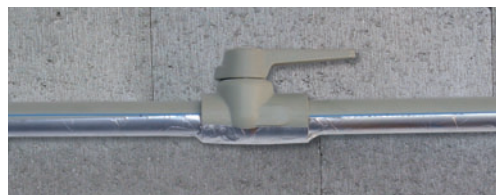
obalení plastového potrubí hliníkovou páskou
