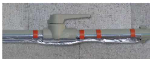
přelepení topného kabelu hliníkovou páskou
