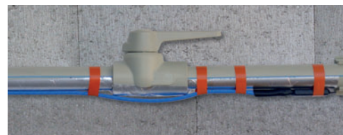
podélné natažení a připevnění topného kabelu montážní páskou
