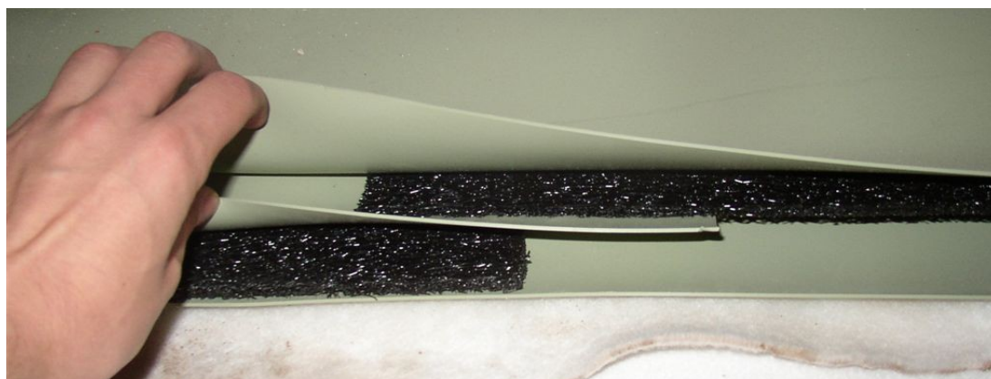
Foto 1. Přesah sektorů pro kontrolu spojů
