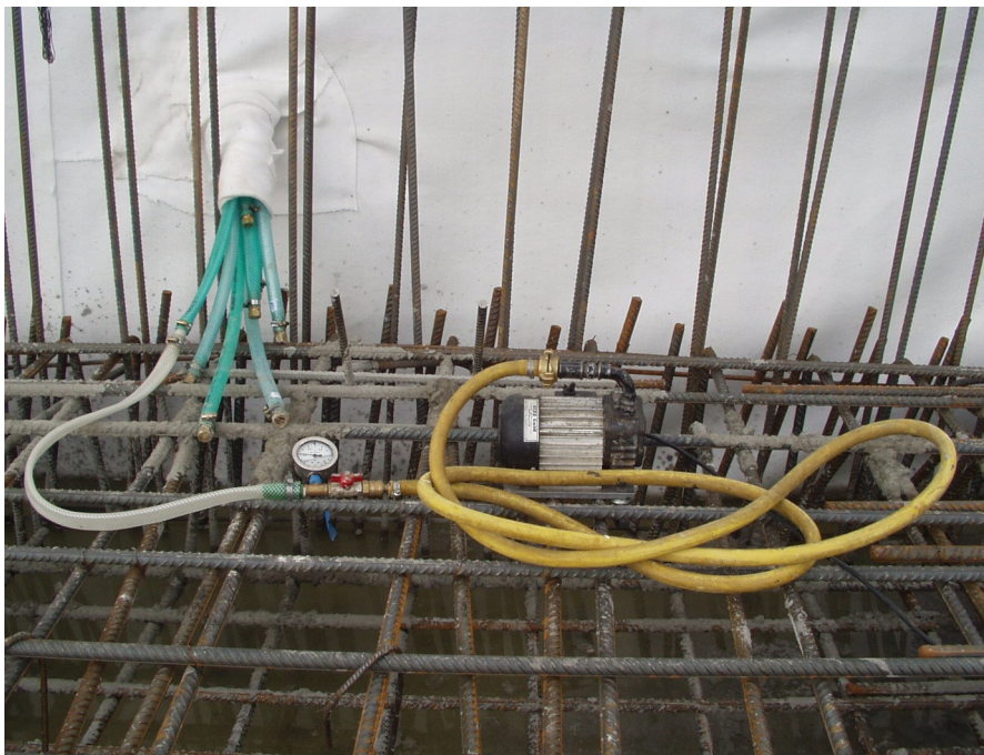
Foto 10. Kontrola těsnosti sektorové hydroizolace po provedení výztuže.
