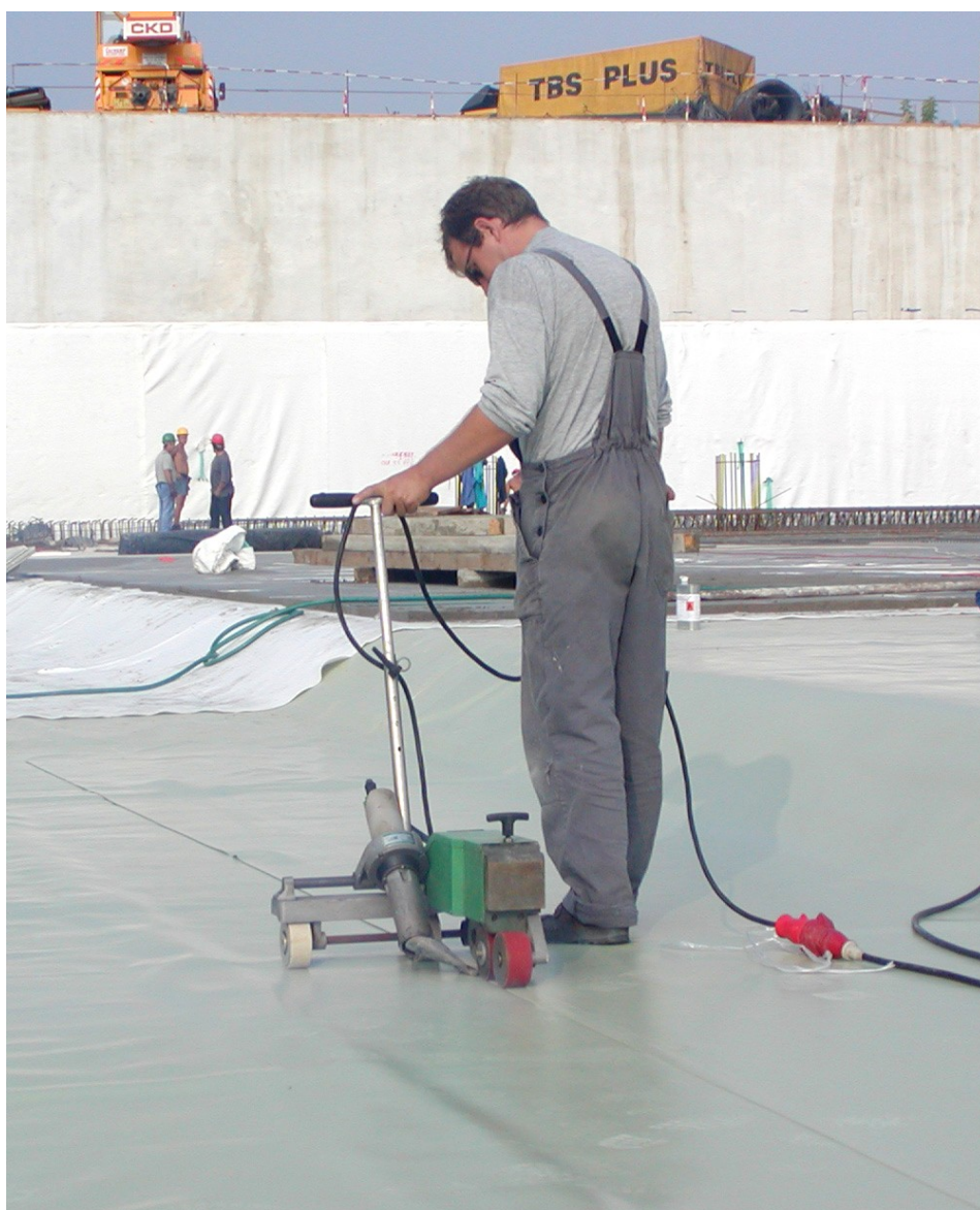
Foto 3. Práce se svařovacím automatem LEISTER VARIMAT.
