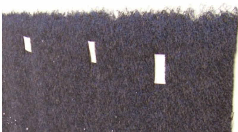
Foto 4. Upevnění drenážní vrstvy pomocí pásků z hydroizolační fólie na svislé stěně.
