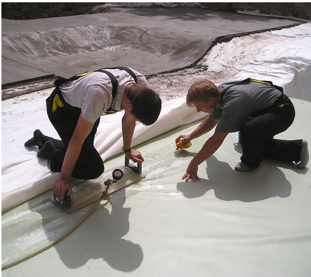
Foto 9. Zkoušení těsnosti spojů vakuovou zkouškou.
