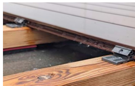
07 | terasová prkna z Thermojasanu a jejich skrytá montáž pomocí klipů
