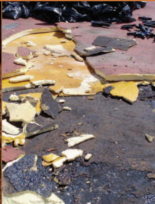
09| Zahájení rekonstrukce odstraněním PUR nástřiku, nástřik nesoudržný s podkladem
