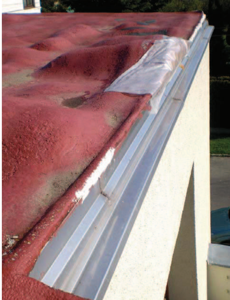
05| Okraj střechy ukončen závětrnou lištou. Klempířské konstrukce z ocelového pozinkovaného plechu z části opatřeny PUR náštříkem
