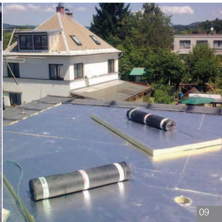
14| Desky tepelné izolace pokládány ve dvou vrstvách. První vrstva z desek Kingspan Thermaroom TR 26 tloušťky 80mm mechanicky kotvena do podkladu
