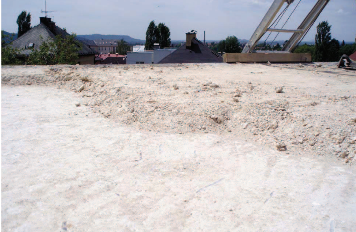
12| Odstraněno souvrství oxidovaných hydroizolačních pásů a násyp až na betonovou mazaninu na stropní konstrukci
