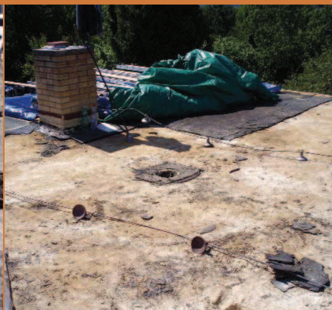
10, 11| Odkryté hydroizolační souvrství z oxidovaných asfaltových pásů, pásy degradovány
