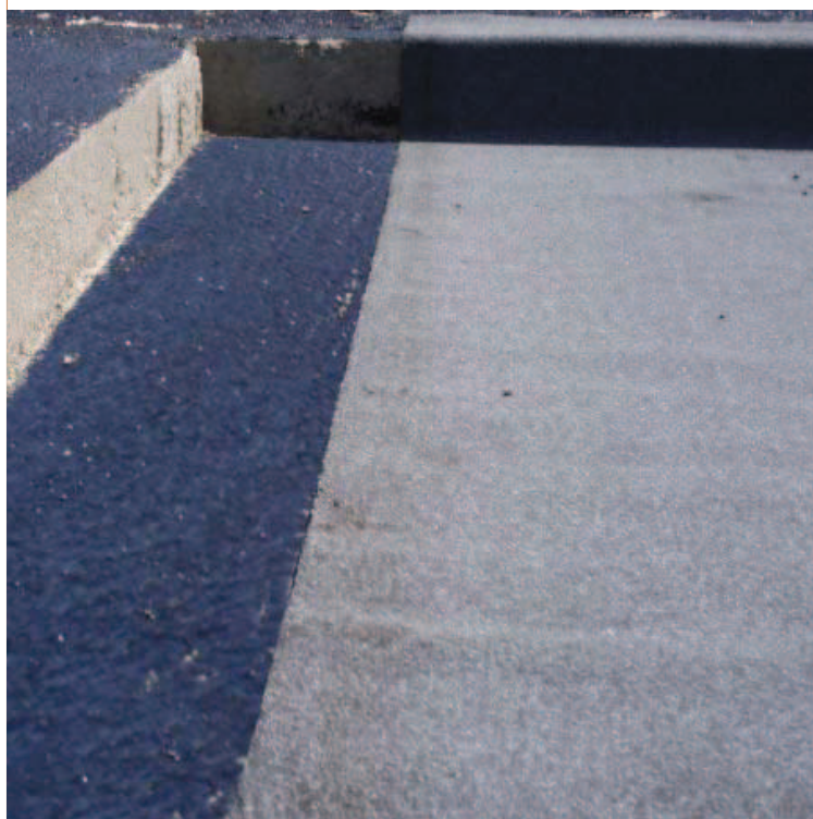
13| Betonová deska vyspravena, nabetonování nízké atiky, podklad napenetrován asfaltovou emulzí DEKPRIMER, bodově natavena parozábrana z asfaltového pásu GLASTEK 40 SPECIAL MINERAL
