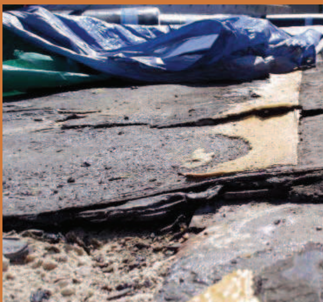
10, 11| Odkryté hydroizolační souvrství z oxidovaných asfaltových pásů, pásy degradovány
