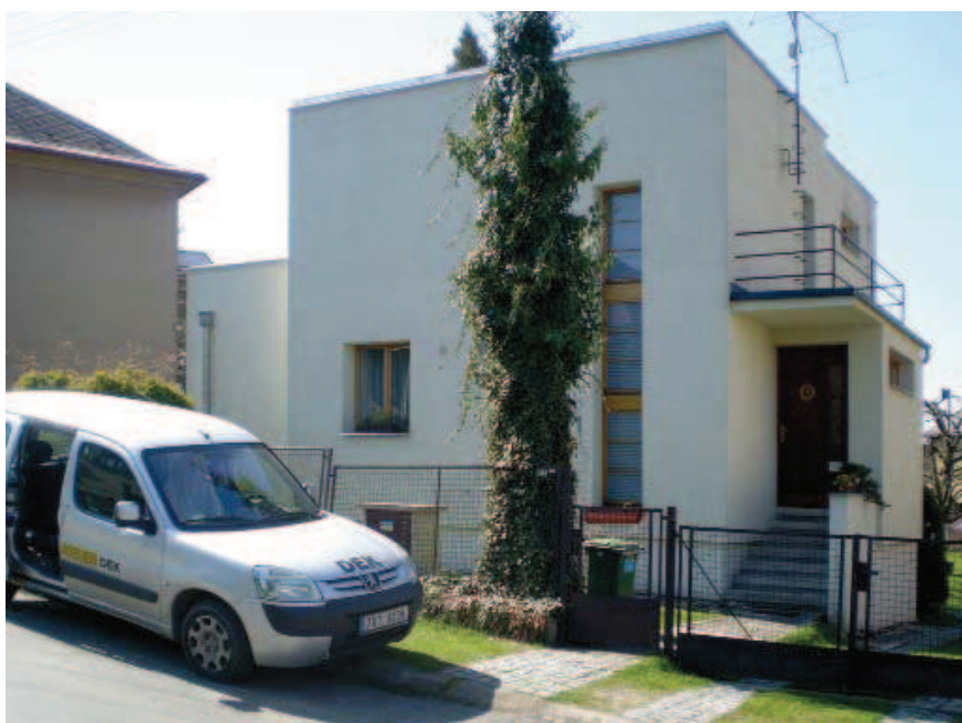
01 | Pohled na vilu před rekonstrukcí střechy
