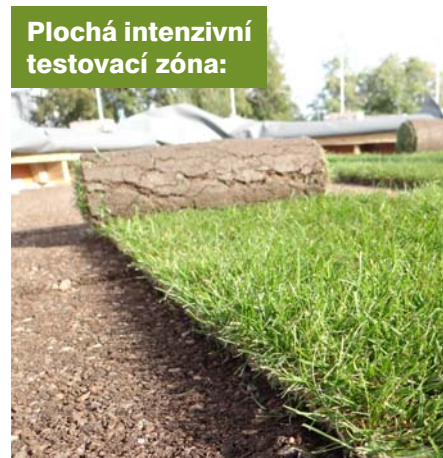
10/2019 – Pokládka travních kobereců.
