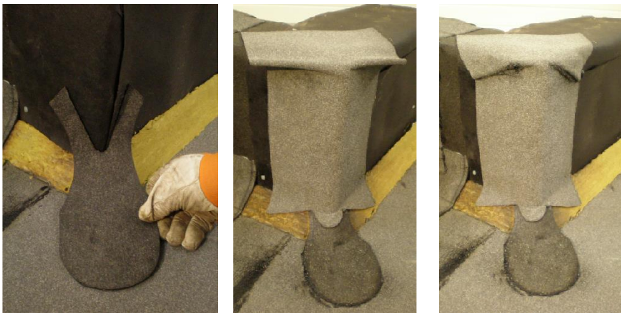
Obrázek /7/ Natavení univerzální tvarovky 1 a 2
