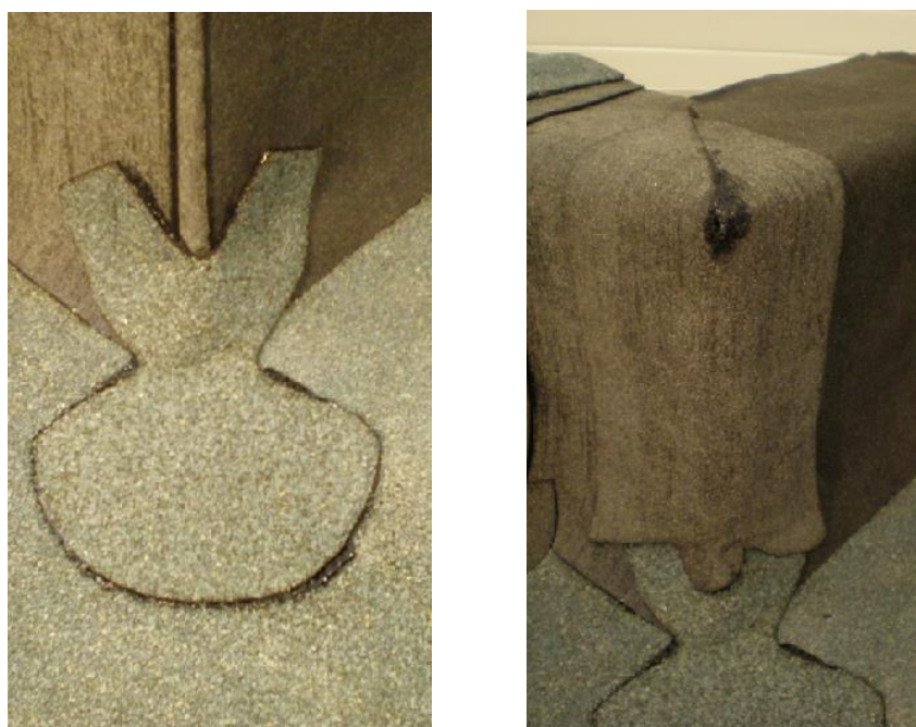
Obrázek /10/ Natavení univerzální tvarovky 3 s posypem a univerzální tvarovky 4 bez posypu (při nedokonalém tvaru podkladu vnějšího rohu doporučujeme použít univerzální tvarovku 4 s posypem pro ulehčení napojení rohových tvarovek 2a a 2b)
