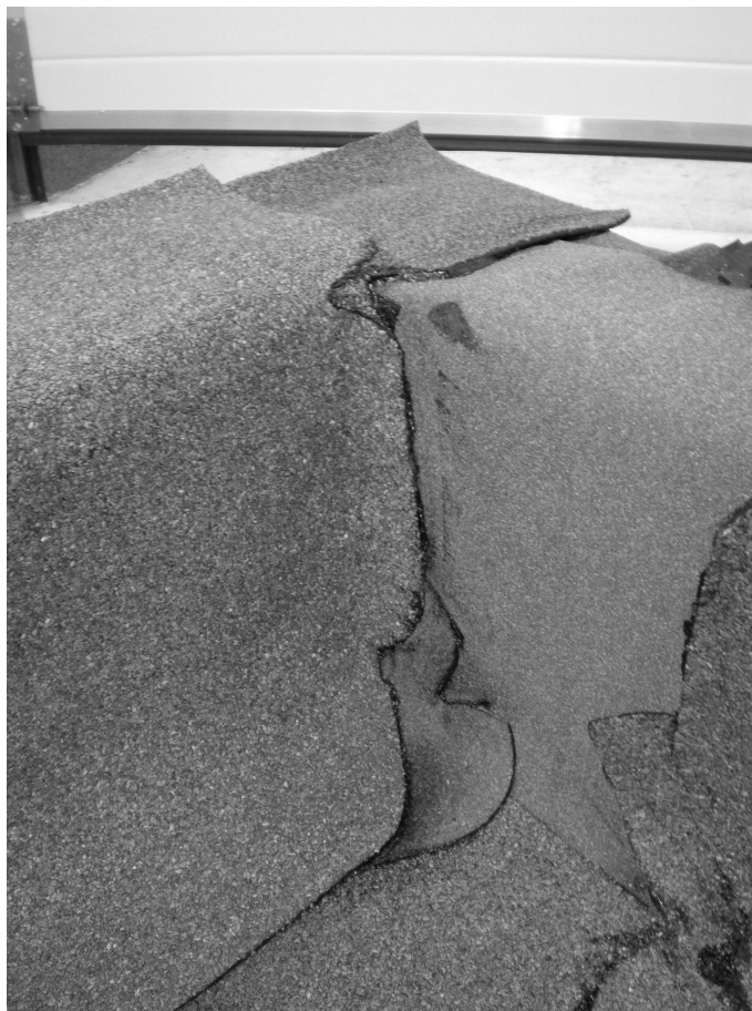
Obrázek /25/ Natavení upraveného asfaltového pásu s posypem přivedeného po atice k detailu vnitřního koutu
