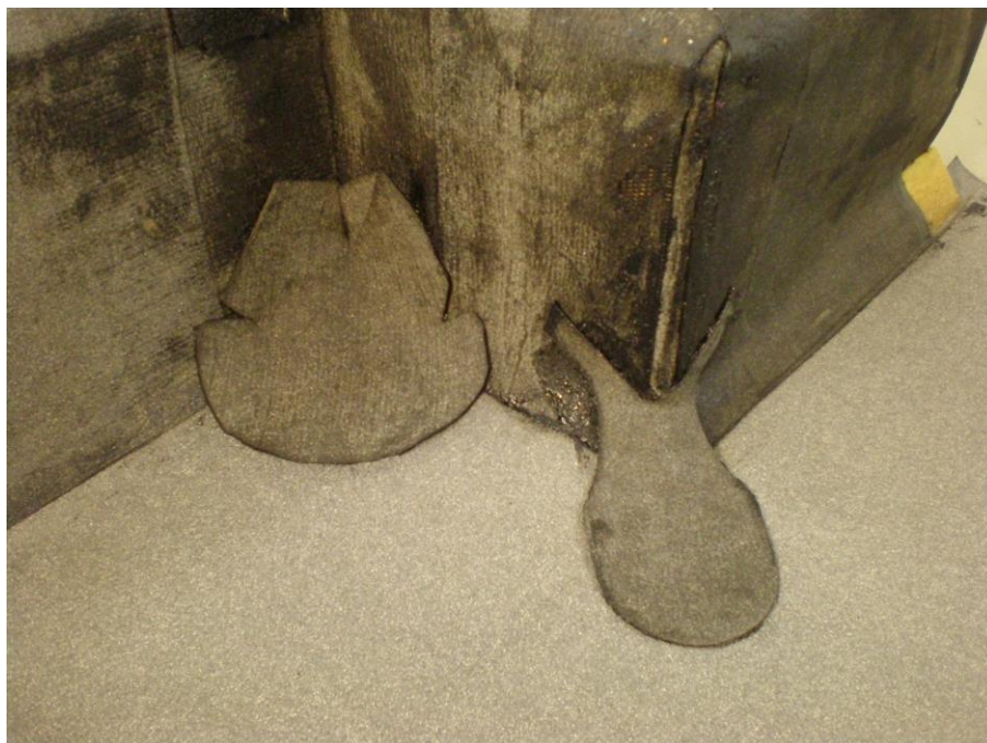
Obrázek /13/ Natavení univerzálních tvarovek 1 a 3 (bez posypu), asfaltový pás z plochy je přiveden k detailu
