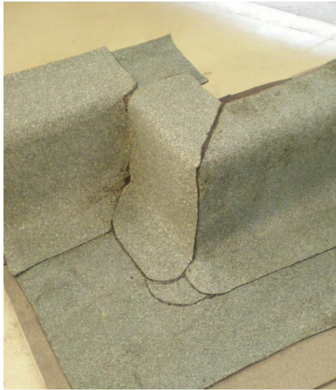
Obrázek /25/ Dokončení detailu vnitřního koutu a vnějšího rohu
