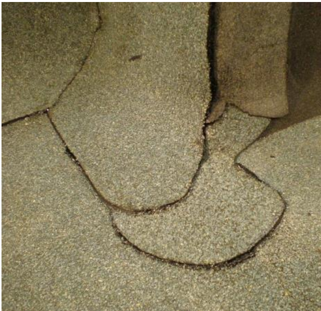
Obrázek / 12/ Detail vnějšího rohu a natavení rohové tvarovky 2a (při použití univerzální tvarovky 4 s posypem nemusí rohová tvarovka 2a a 2b na sebe navazovat)
