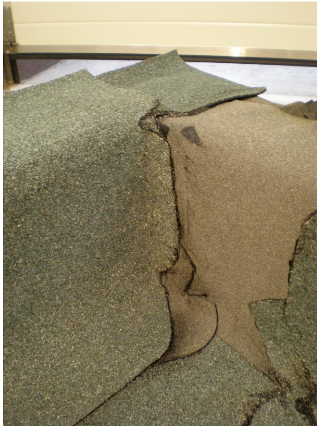
Obrázek /23/ Natavení upraveného asfaltového pásu s posypem přivedeného po atice k detailu vnitřního koutu
