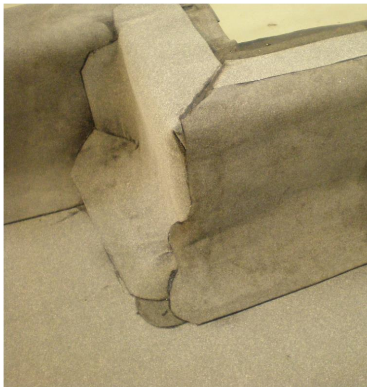
Obrázek /18/ Natavení upraveného asfaltového pásu přivedeného po atice k detailu vnějšího rohu
