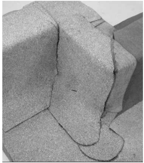
Obrázek /13/ Natavení koutové tvarovky 4b upravené zprava na tvar rohové tvarovky 2b a natavení koutové tvarovky 4a, obě s posypem
