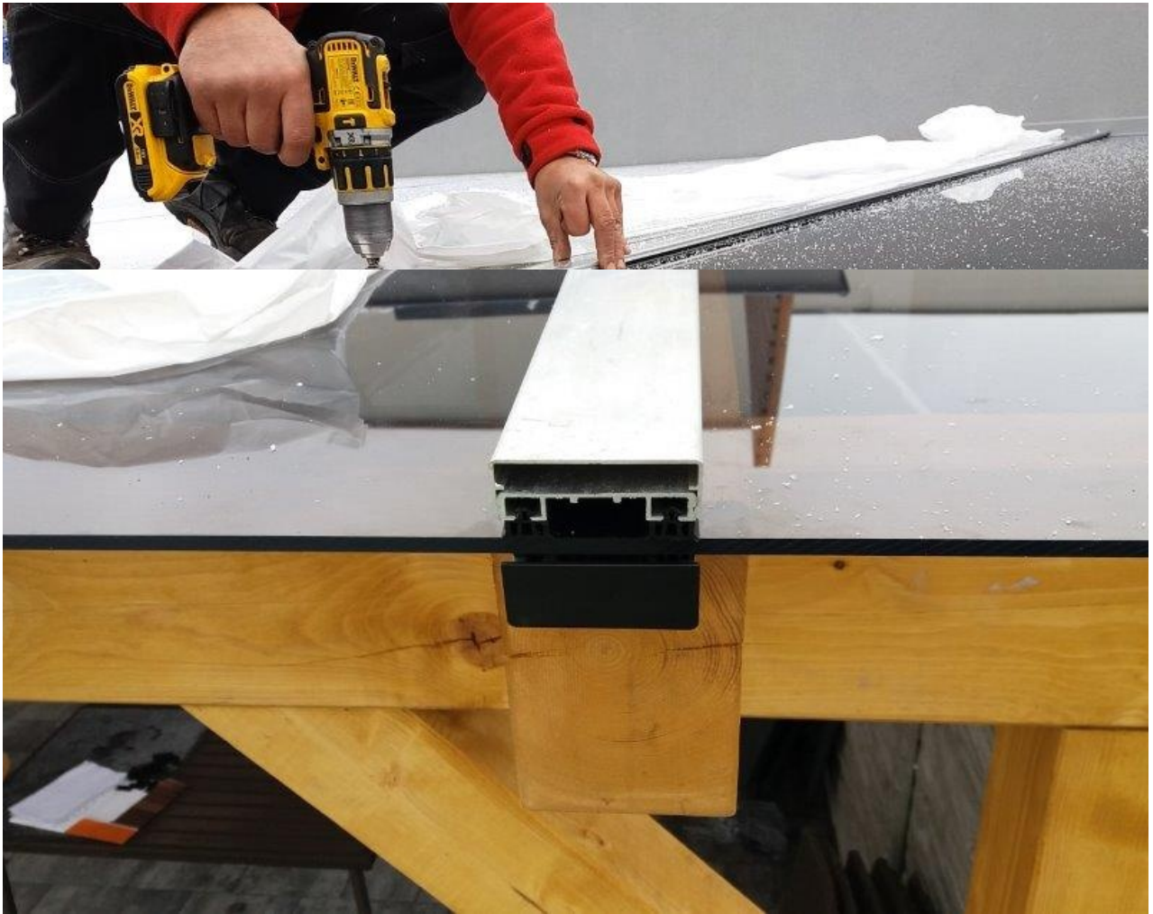
Foto 8. Nacvaknut krycí profil (kotevní prvky jsou tak kryté).
