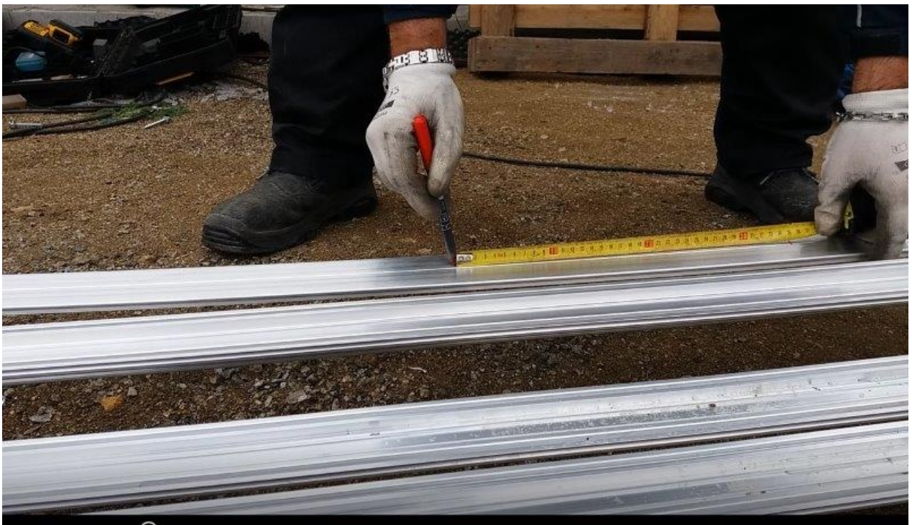
Foto 4. Příprava upevňovacího profilu – rozměření kotvení.
