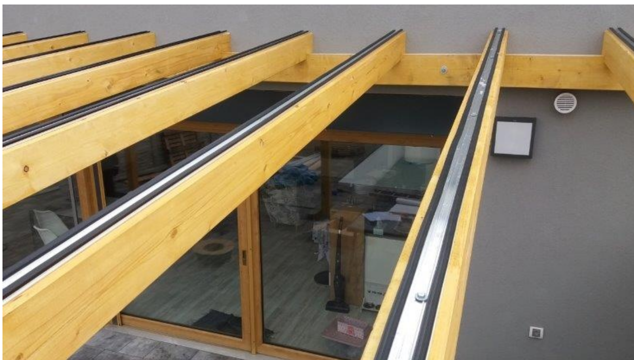
Foto 2. Připravené upevňovací profily.
