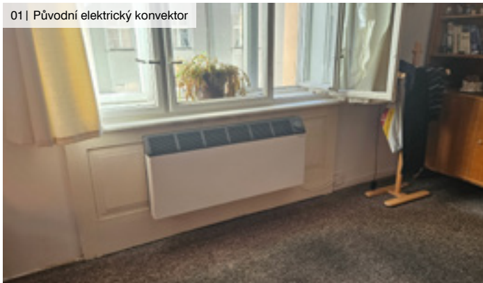
01 | Původní elektrický konvektor
