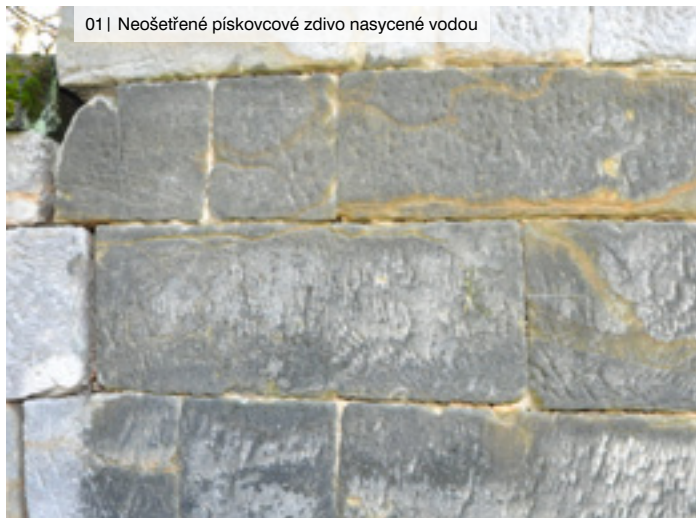
01 | Neošetřené pískovcové zdivo nasycené vodou
