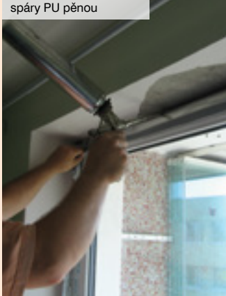
05| Vyplnění připojovací spáry PU pěnou
