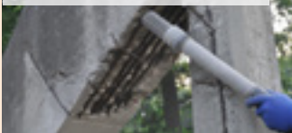
02| Příprava podkladu (odstranění nesoudržných míst)
