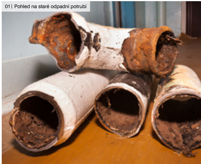
01 | Pohled na staré odpadní potrubí
