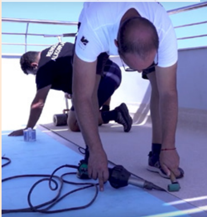
08| Svařování fólií Decking Solid na tupo na podvařovací pásek
