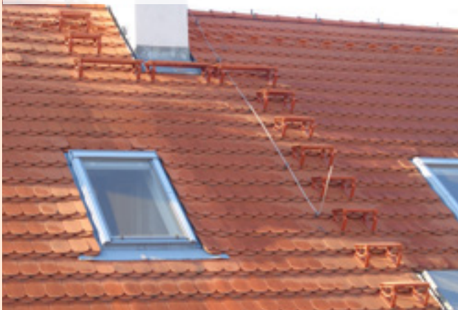
05| Přístup na střechu pomocí stoupacích kompletů
