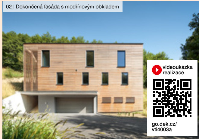
02 | Dokončená fasáda s modřínovým obkladem
