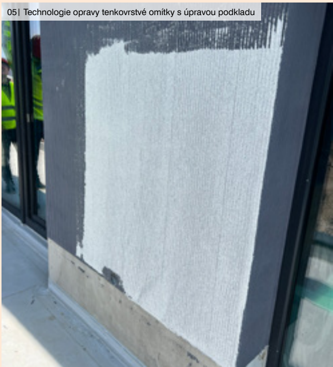
07| Technologie opravy tenkovrstvé omítky s realizací základní vrstvy
