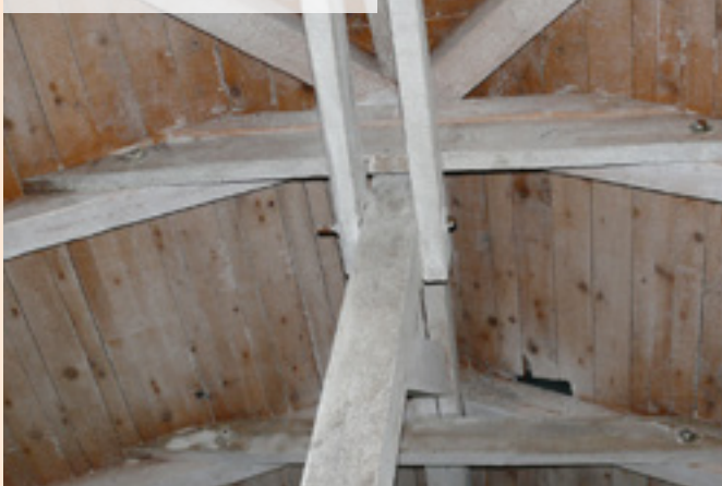
07| Krov ošetřený protipožárním nátěrem
