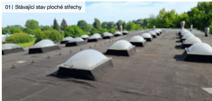
01 | Stávající stav ploché střechy
