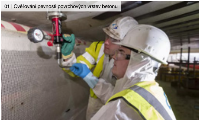
01 | Ověřování pevnosti povrchových vrstev betonu
