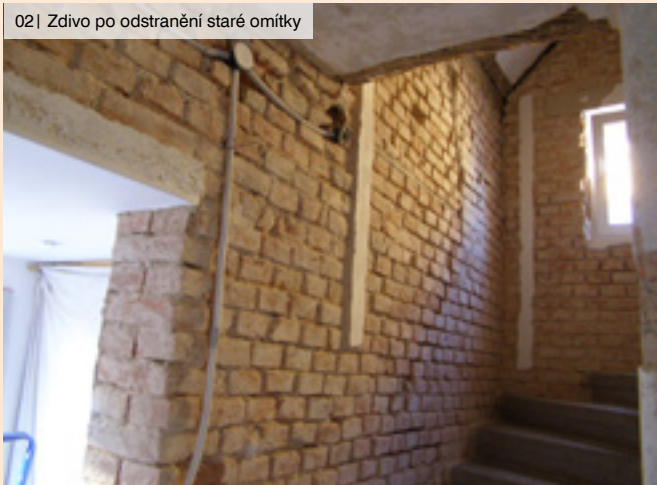
02 | Zdivo po odstranění staré omítky
