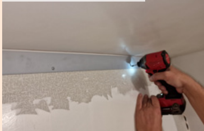
05| Vrchní poplastované profily přejedeme válečkem pro lepší přilnutí a následně zafixujeme vrutem kvůli smyku
