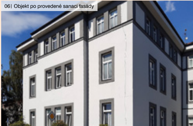
06| Objekt po provedené sanaci fasády
