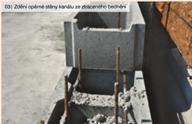
03| Zdění opěrné stěny kanálu ze ztraceného bednění
