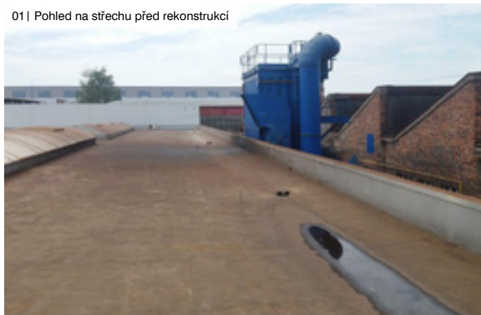
01 | Pohled na střechu před rekonstrukcí
