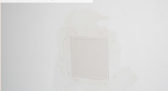
08| Provedené tmelení opravovaného místa
