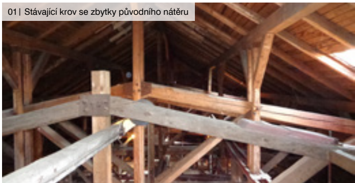
01 | Stávající krov se zbytky původního nátěru
