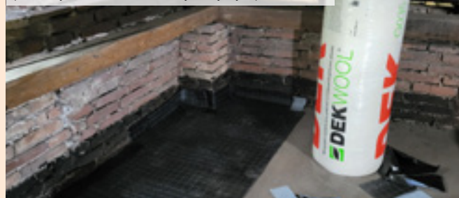
02 | Aplikace parozábrany ze samolepicího asfaltového pásu s vytážením na svislé stěny do výšky tepelné izolace
