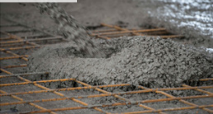
01 | Aplikace betonové směsi
