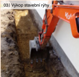
04| Postup výkopu jámy pod základové pasy do požadované hloubky
