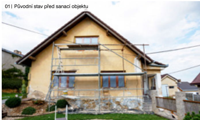
01 | Původní stav před sanací objektu
