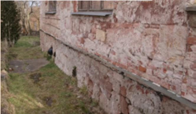
05| Spára vyplněná bobtnající maltou weberbat OH 106
