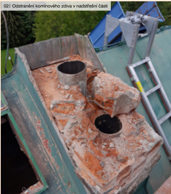
02| Odstranění komínového zdiva v nadstřešní části
