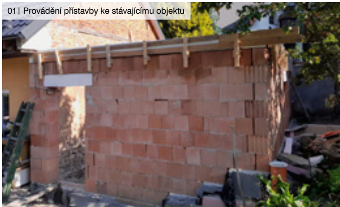
01 | Provádění přístavby ke stávajícímu objektu
