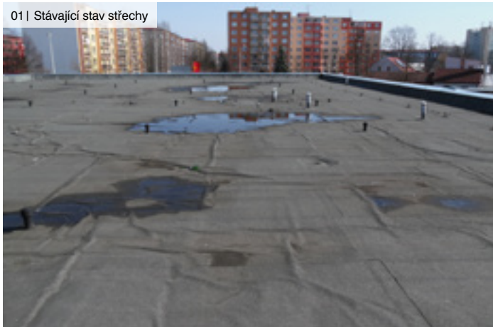
01 | Stávající stav střechy
