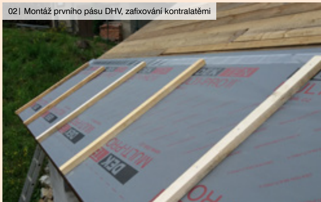
02 | Montáž prvního pásu DHV, zafixování kontralatěmi
