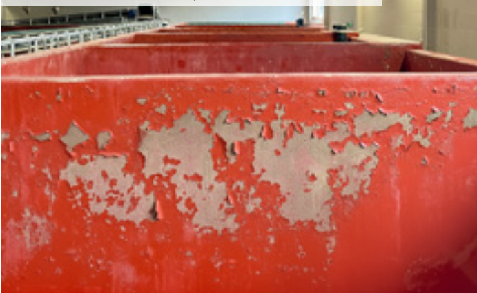
01 | Betonové kvasné kádě na zelí před obnovou ochranného nátěru
