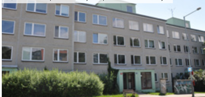
01 | Původní nezateplená fasáda objektu s potenciálními hnízdišti rorýse
