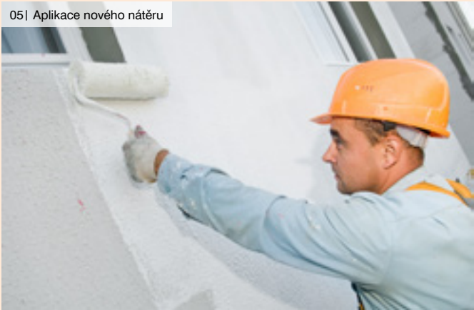
05| Aplikace nového nátěru
