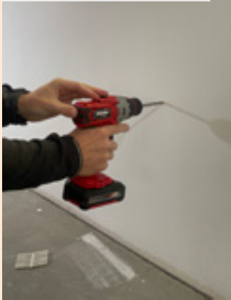
04| Vytváření otvorů pro hmoždinky
