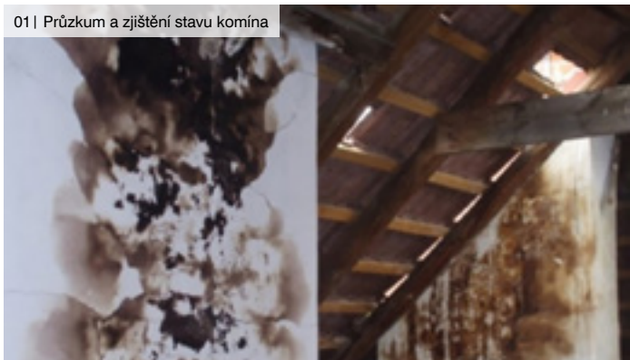
01 | Průzkum a zjištění stavu komína
