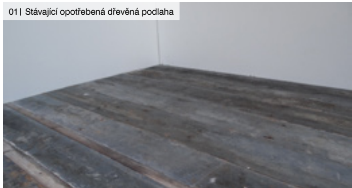
01 | Stávající opotřebovaná dřevěná podlaha
