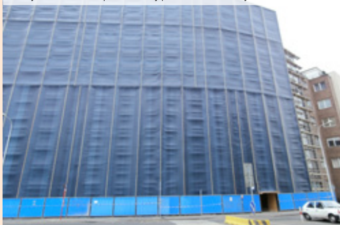
02 | Vytvoření uzavřené pracovní zóny při likvidaci azbestových materiálů
