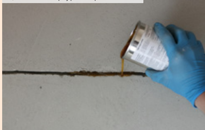
03 | Zalití smršťovací spáry pružnou epoxidovou hmotou
