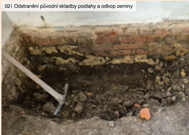
02 | Odstranění původní sklady podlahy a odkop zeminy
