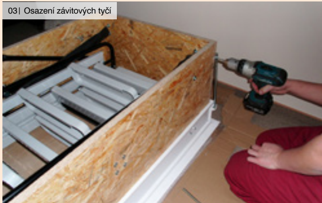
03| Osazení závitových tyčí
