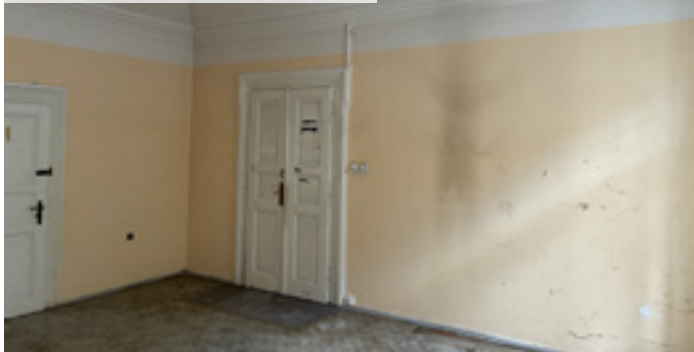
01 | Pohled do místnosti před renovací maleb
