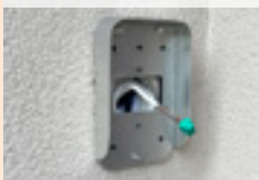
02 | Montážní deska s ochrannou stříškou pro vstupní panel s připraveným kabelem
