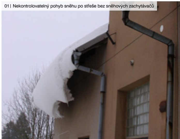
01 | Nekontrolovatelný pohyb sněhu po střeše bez sněhových zachytávačů
