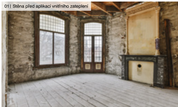
01 | Stěna před aplikací vnitřního zateplení
