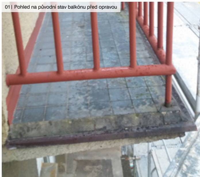
01 | Pohled na původní stav balkónu před opravou
