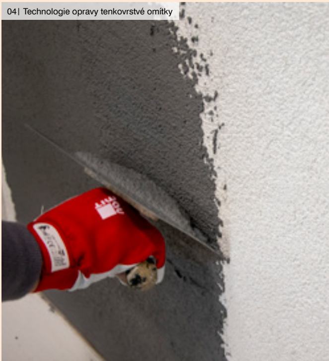
05| Technologie opravy tenkovrstvé omítky s úpravou podkladu
