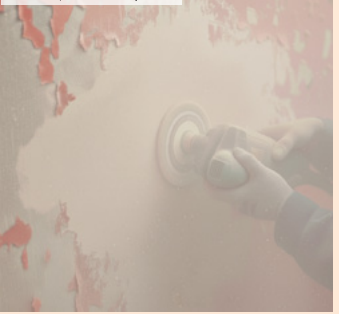
02 | Broušení původních ochranných nátěrů
