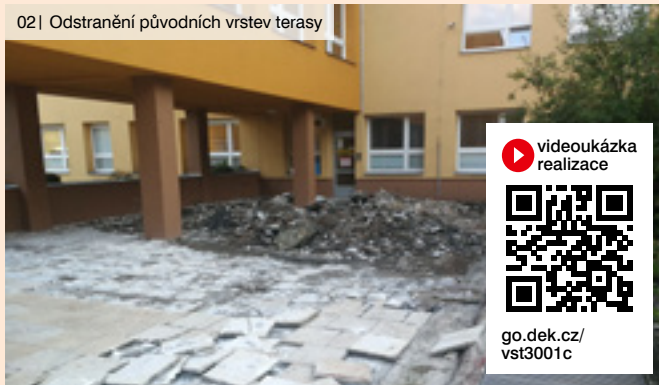
02 | Odstranění původních vrstev terasy
