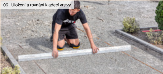
06| Uložení a rovnání kladecí vrstvy
