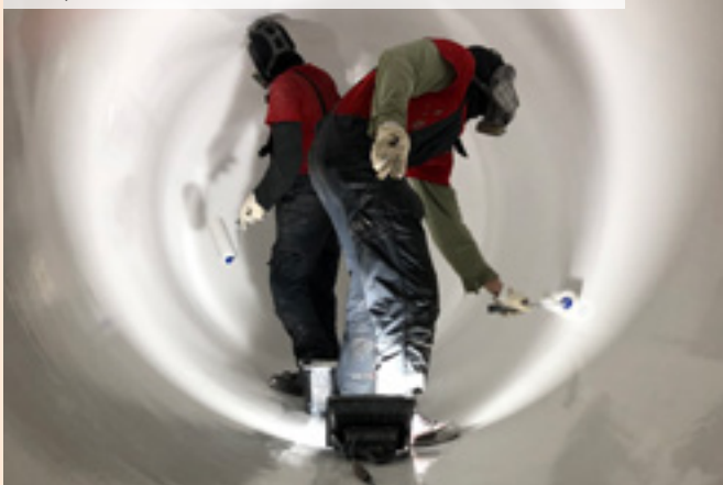
08 | Betonové kvasné kádě na zelí po obnově ochranného nátěru
