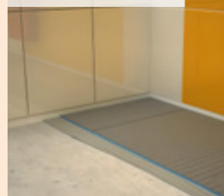
03 | Usazení tepelněizolačních desek F-BOARD
