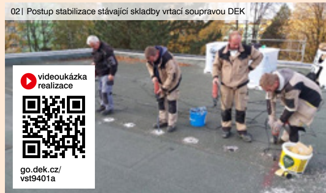
02 | Postup stabilizace stávající skladby vrtací soupravou DEK
