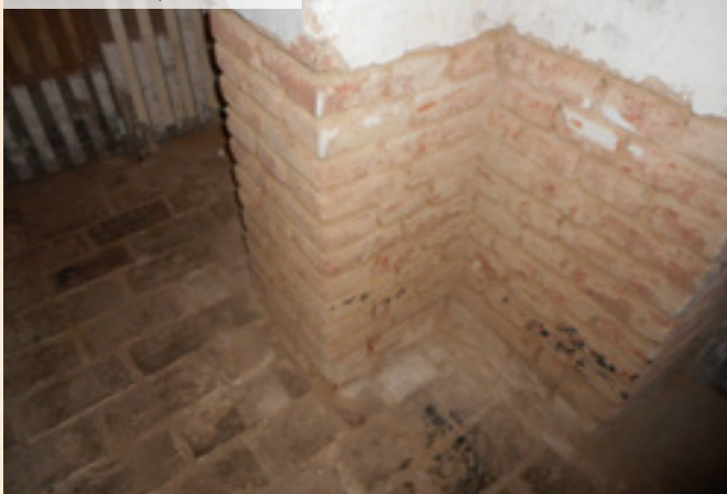
03 | Vyvrtání otvorů do stěny
