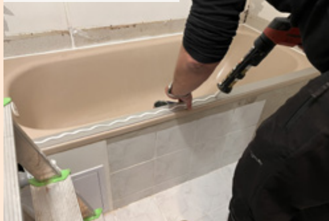
05| Vrchní poplastované profily přejedeme válečkem pro lepší přilnutí a následně zafixujeme vrutem kvůli smyku
