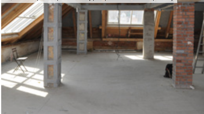
01 | Betonová podlaha půdní vestavby před položením akustické podložky
