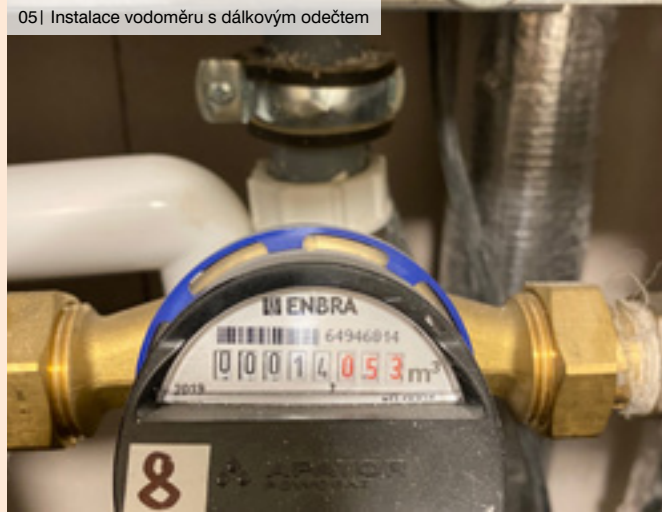
05| Instalace vodoměru s dálkovým odečtem
