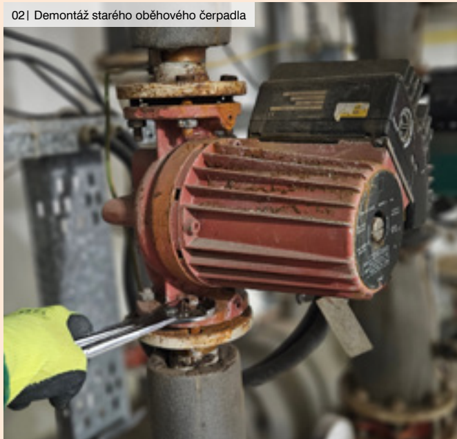
02 | Demontáž starého oběhového čerpadla
