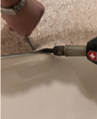
14| Navařování fólie na lepidlo ALKORGLUE 81043
