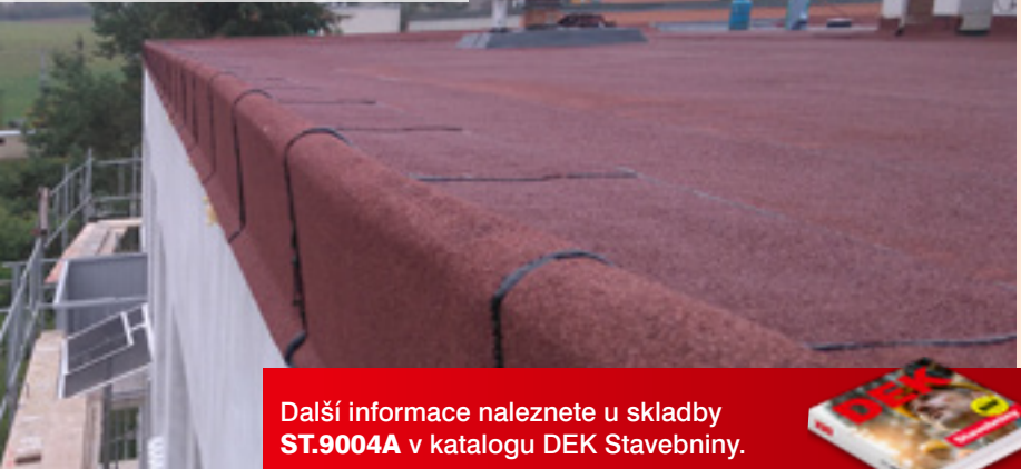
12| Dokončený detail UNIDEK A s asfaltovými pásy
