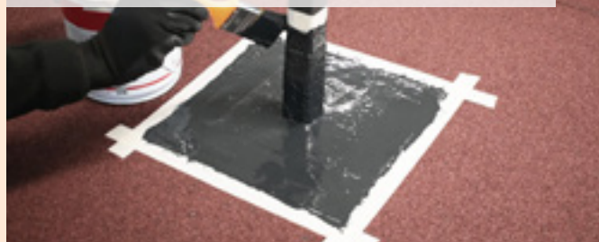
07| Detail po aplikaci systému Enkopur
