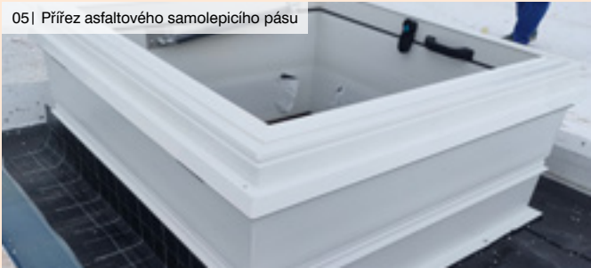
05| Přířez asfaltového samolepicího pásu
