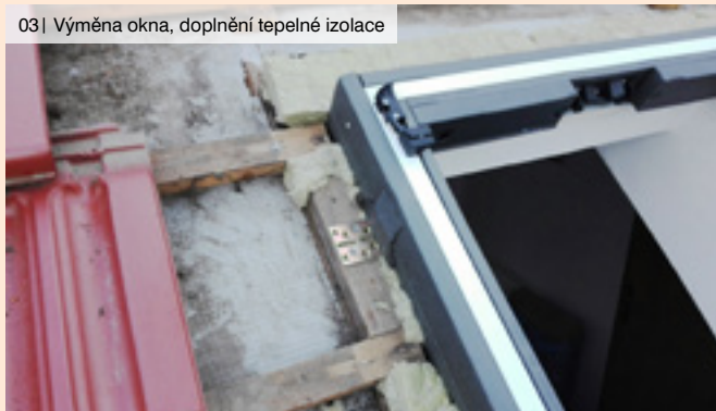
03 | Výměna okna, doplnění tepelné izolace
