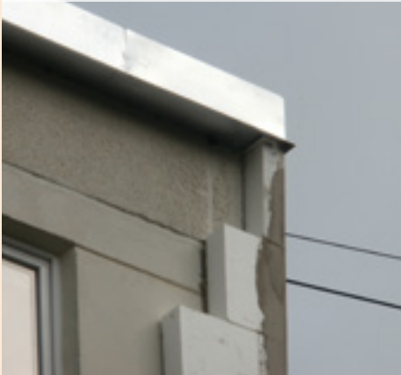
11| Tepelná izolace fasády doražená k prvku UNIDEK A
