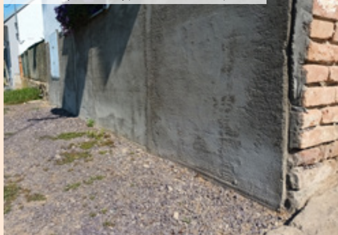
05| Provedení jádrové omítky pro dosažení rovinnosti podkladu
