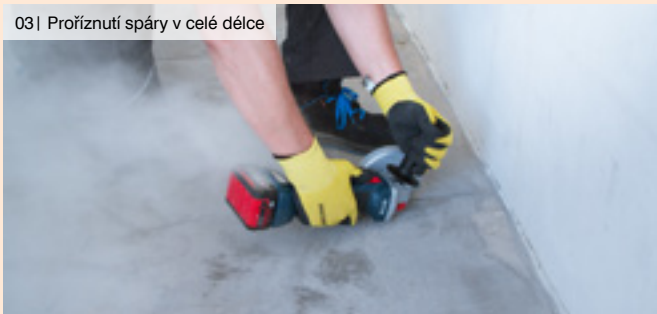
03 | Proříznutí spáry v celé délce
