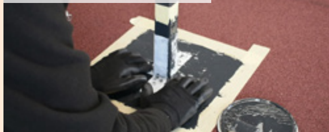
06| Provedení druhé vrstvy nátěru na výztužnou vložku a první vrstvu nátěru
