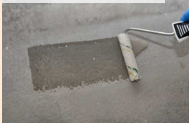
04| Aplikace hydrofobizačního přípravku FH100 stříkáním na hrubý povrch betonu
