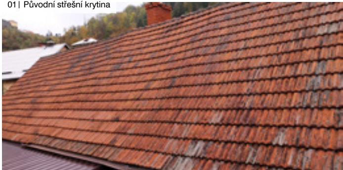
01 | Původní střešní krytina
