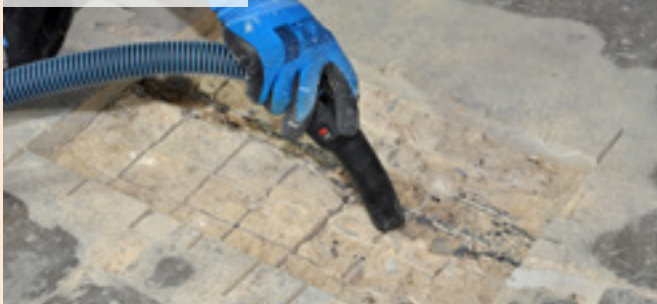
04 | Vyčištění (vysátí) výtluku
