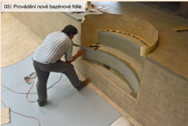
03 | Provádění nové bazénové fólie
