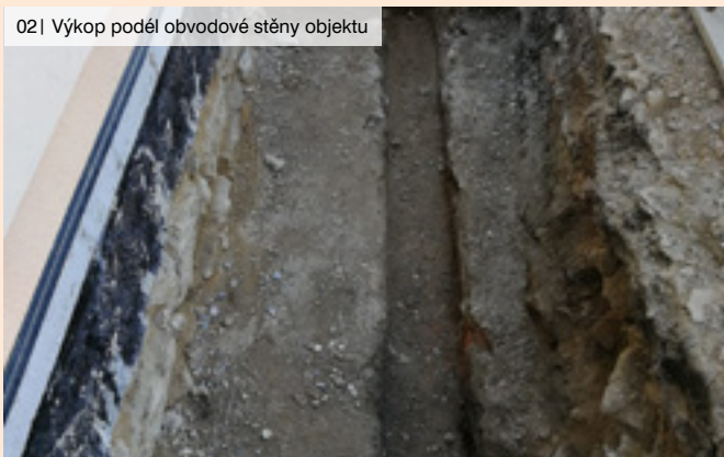
02 | Výkop podél obvodové stěny objektu
