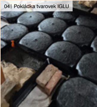
04| Pokládka tvarovek IGLU
