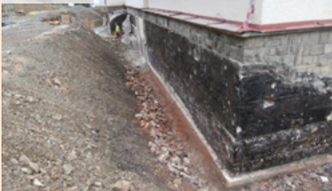
04| Vyrovnaní povrchu zdiva omítkou
