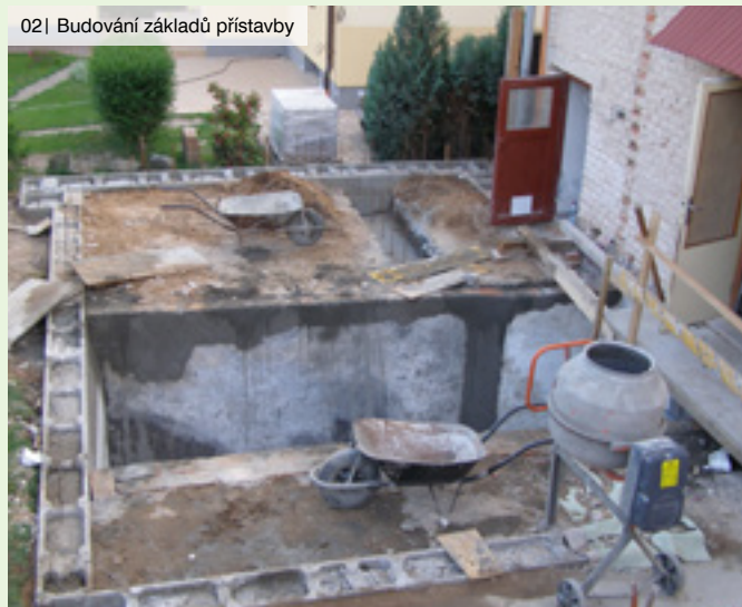
02| Budování základů přístavby
