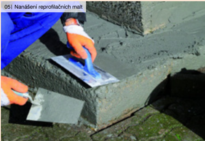
05| Nanášení reprofilačních malt
