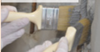
03| Aplikace ochrany výztuže
