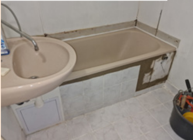
02| Zednické úpravy – odstranění starého obkladu na obvodu vany, zatmelení spáry
