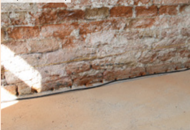
04 | Vyfouknutí nečistot z vyvrtaného otvoru pomocí pumpičky
