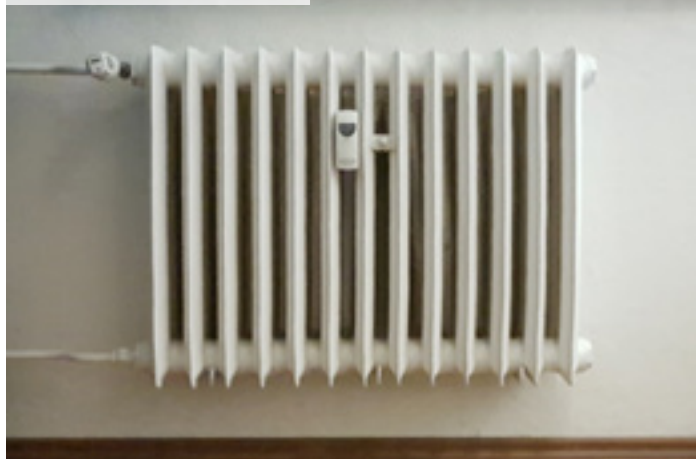
01 | Stávající článkové otopné těleso
