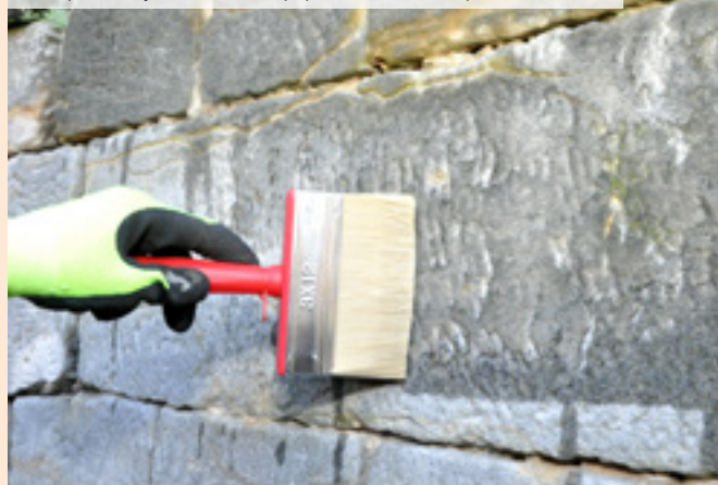
03| Aplikace hydrofobizačního přípravku FH390 válečkem na hladký povrch betonu
