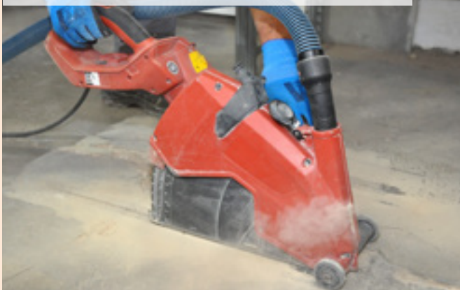
03 | Výtluk po zařízení okrajů
