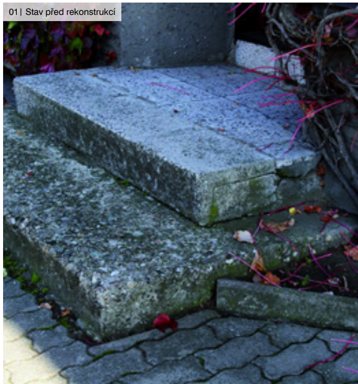
01 | Stav před rekonstrukcí
