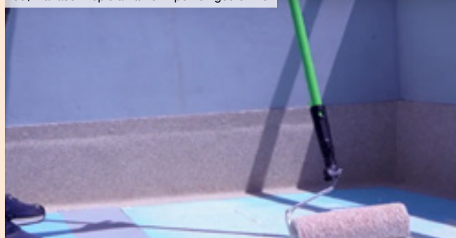
06| Nanášení lepidla na horní povrch geotextilie
