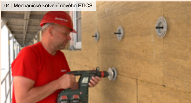
04 | Mechanické kotvení nového ETICS
