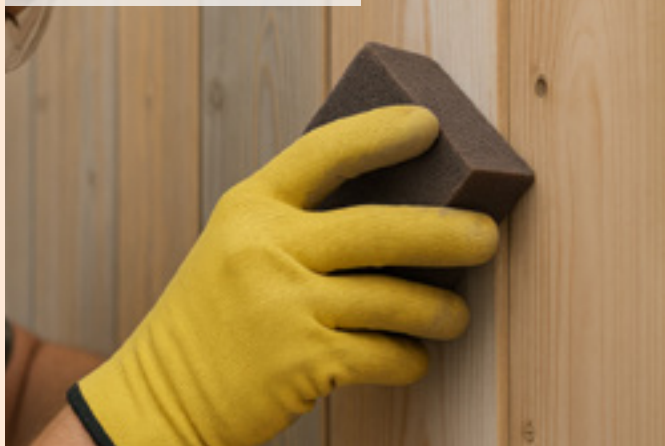
06| Ometení povrchu fasády
