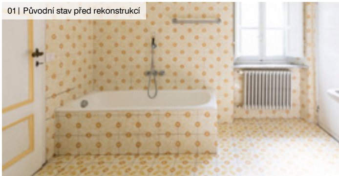
01 | Původní stav před rekonstrukcí
