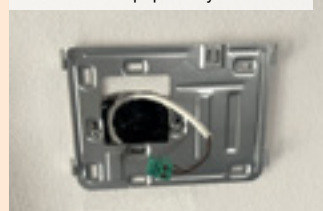
03 | Montážní deska pro videotelefon s připraveným kabelem
