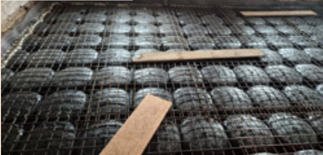
06| Betonáž podlahové desky
