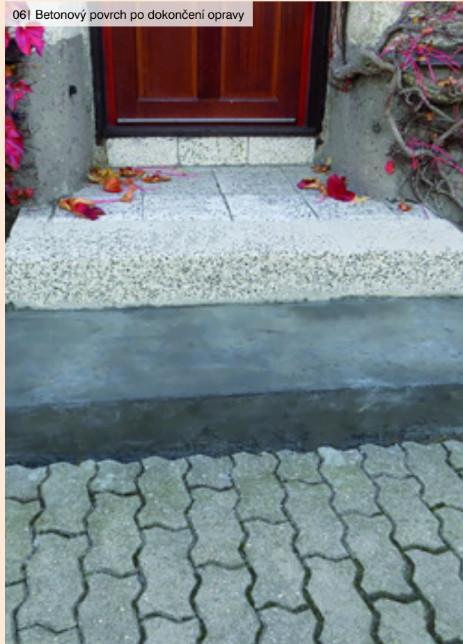
06| Betonový povrch po dokončení opravy
