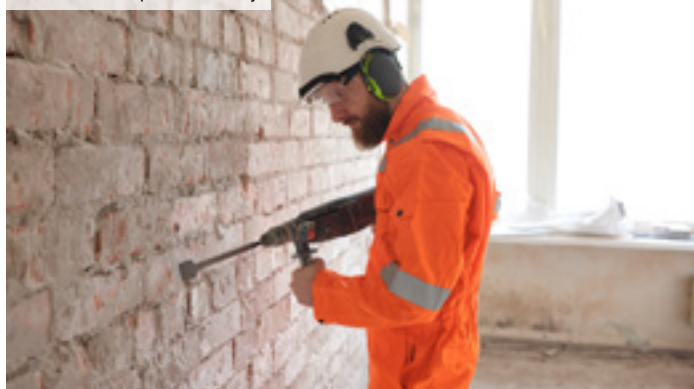
01 | Odstranění původní omítky
