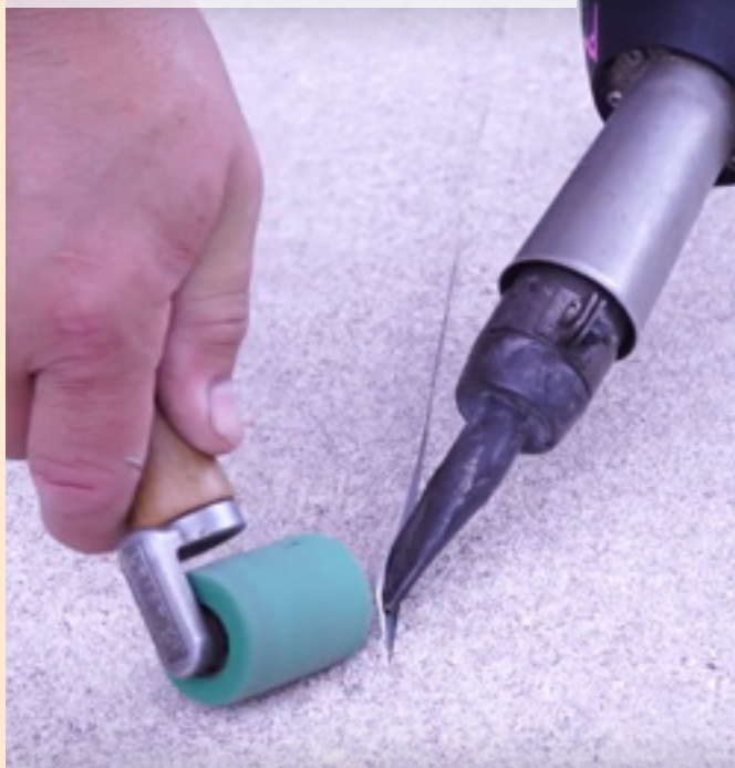
08| Svařování fólií Decking Solid na tupo na podvařovací pásek
