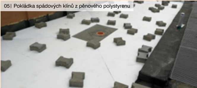
05| Pokládka spádových klínů z pěnového polystyrenu
