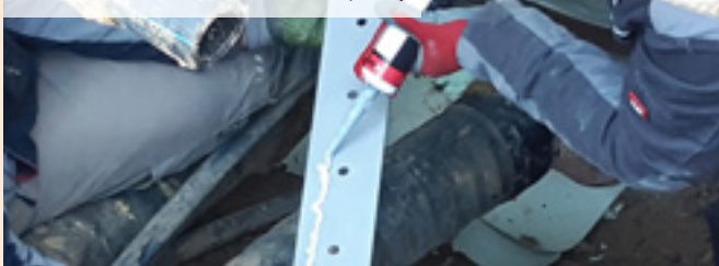
03 | Nanášení PU tmelu na volnou část příruby
