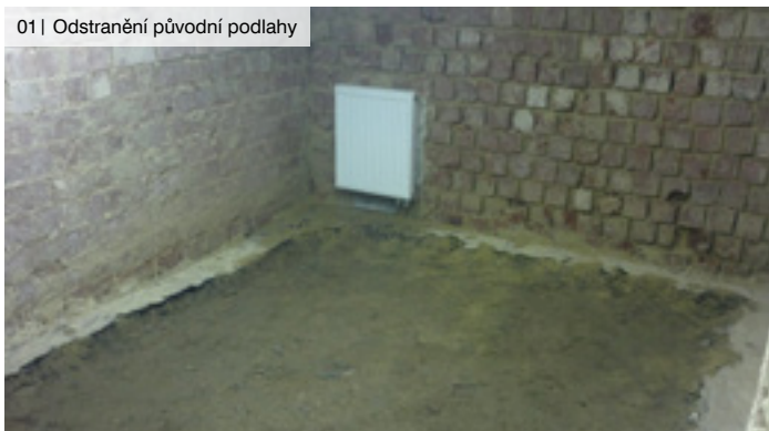
01 | Odstranění původní podlahy
