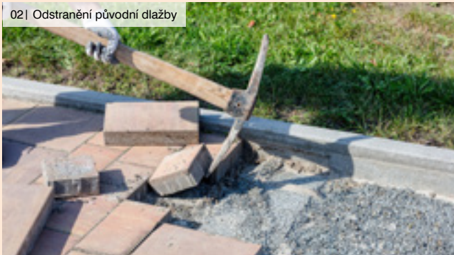
02 | Odstranění původní dlažby
