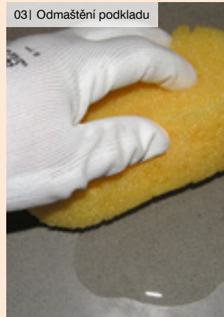
03 | Odmaštění podkladu
