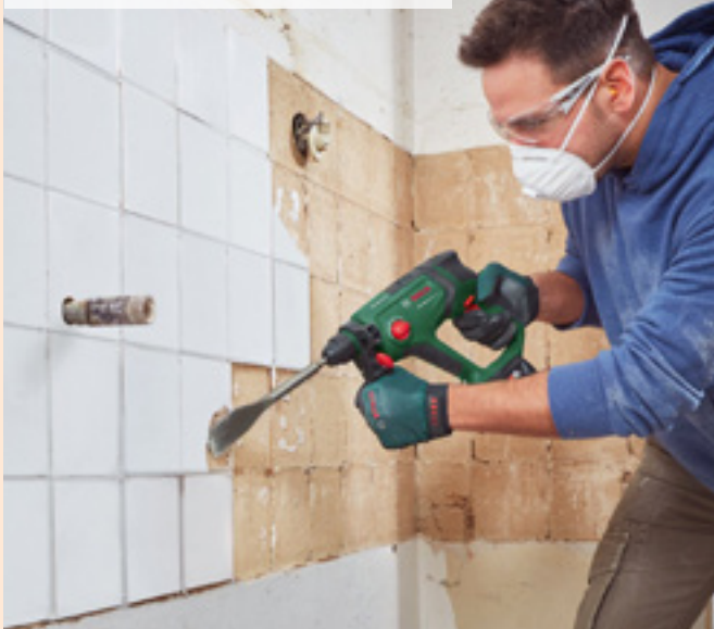
02 | Vybourání obkladu a drážek pro nové rozvody
