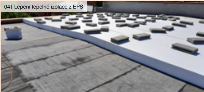
04| Lepení tepelné izolace z EPS
