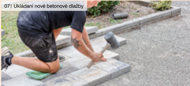
08| Nová betonová dlažba
