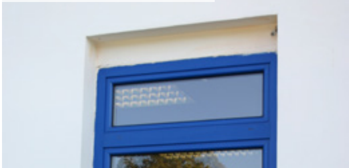
01 | Okno připravené pro montáž venkovních žaluzií
