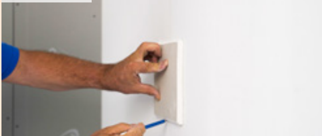
03 | Vyříznutí poškozené části sádrokartonové desky
