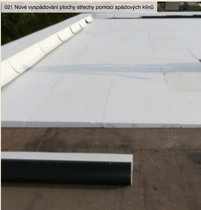
02 | Nové vyspádování plochy střechy pomocí spádových klínů
