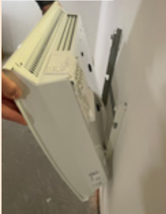
07| Nasazení konvektoru
