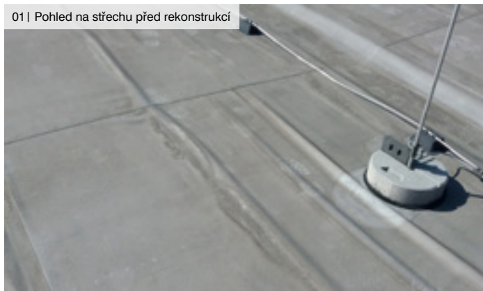
01 | Pohled na střechu před rekonstrukcí
