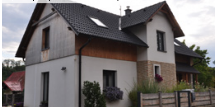
01 | Rodinný dům před renovací dřevěné fasády
