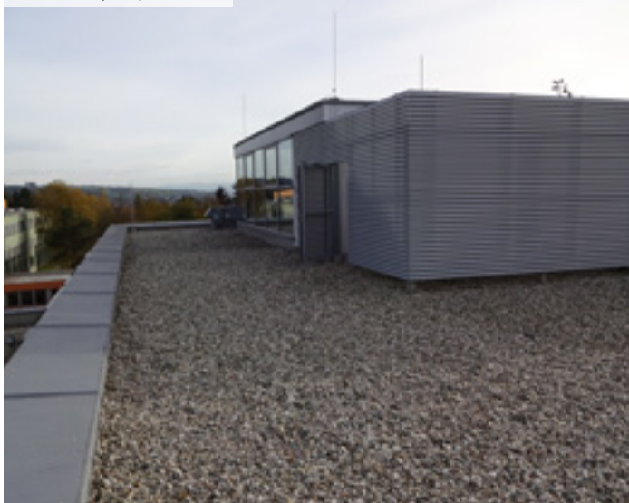
01 | Střecha před průzkumem
