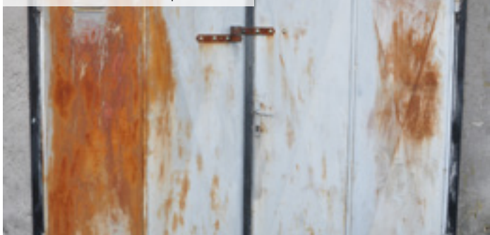
01 | Původní stav konstrukce před renovací
