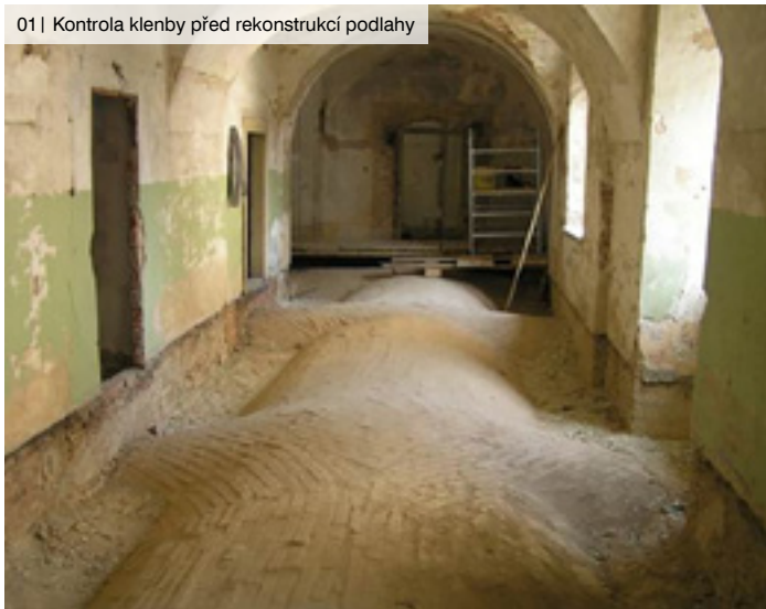
01 | Kontrola klenby před rekonstrukcí podlahy
