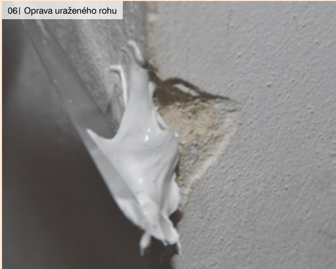
06| Oprava uraženého rohu
