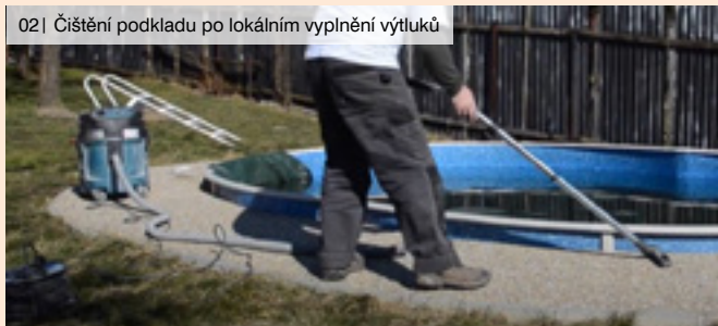
02 | Čištění podkladu po lokálním vyplnění výtluků
