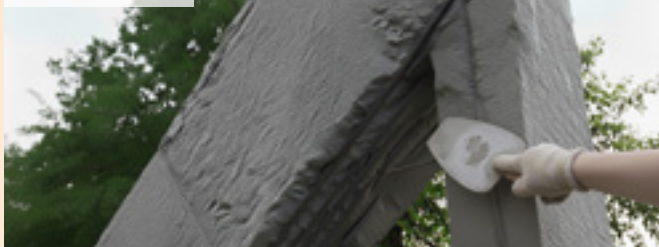
05| Jemná reprofilace betonové konstrukce
