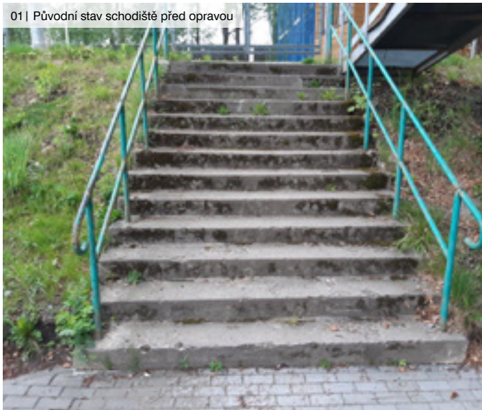
01 | Původní stav schodiště před opravou
