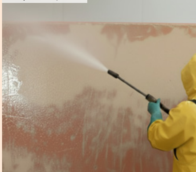
03| Omytí konstrukce po broušení
