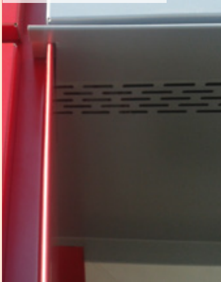
08| Detail větrací mřížky pod parapetem
