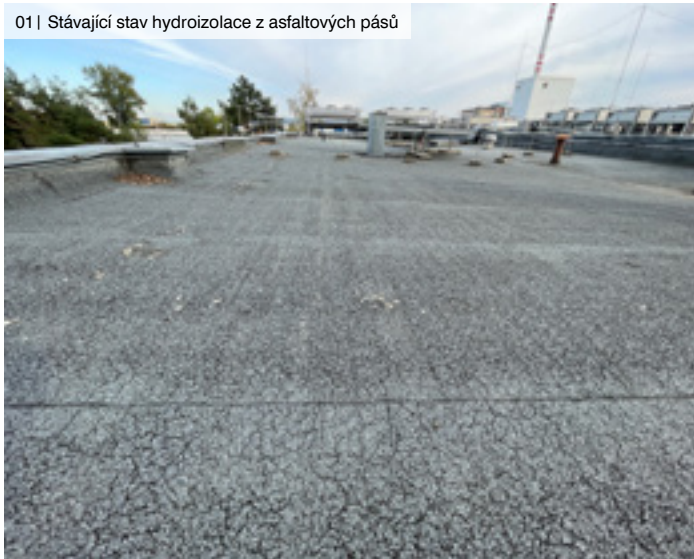
01 | Stávající stav hydroizolace z asfaltových pásů
