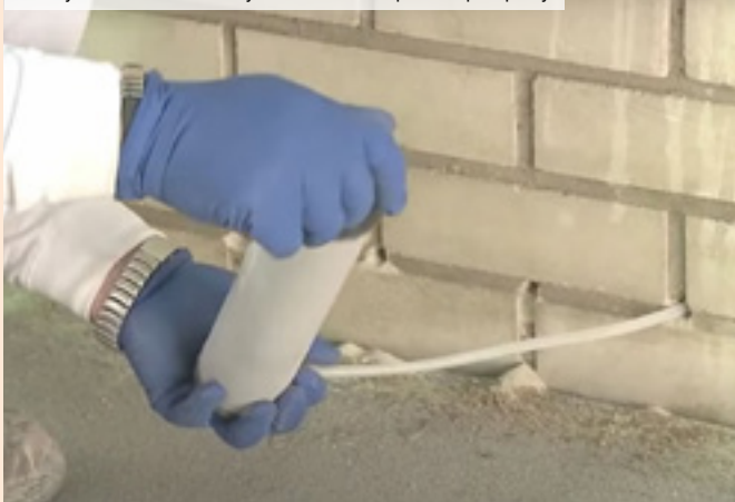
04 | Vyfouknutí nečistot z vyvrtaného otvoru pomocí pumpičky
