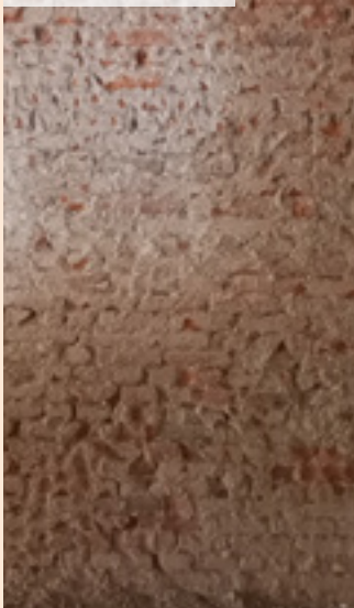
02 | Zdivo po odstranění původní omítky
