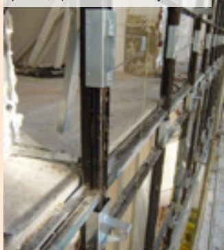
04| Odhalená konstrukce fasádních panelů, upevněné A-konzoly
