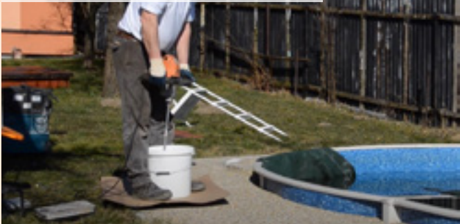
04| Aplikace nátěru štětcem na hůře přístupných místech
