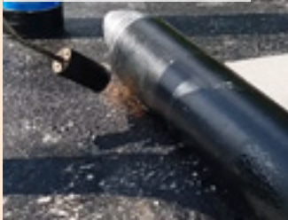
05| Natavení hydroizolace GLASTEK 40 SPECIAL MINERAL
