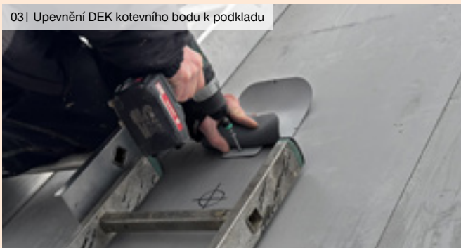
03 | Upevnění DEK kotevního bodu k podkladu
