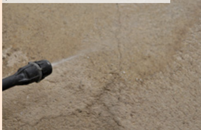
04| Aplikace hydrofobizačního přípravku FH100 stříkáním na hrubý povrch betonu
