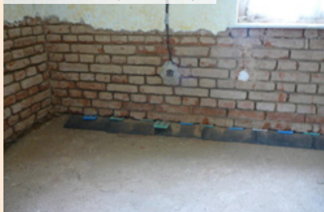
05| Provedení jádrové omítky pro dosažení rovinnosti podkladu
