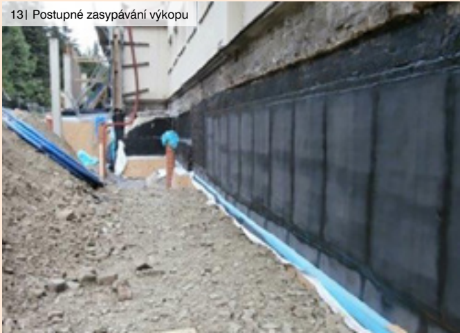
14| Realizace zpevněných nepropustných ploch okolo objektu
