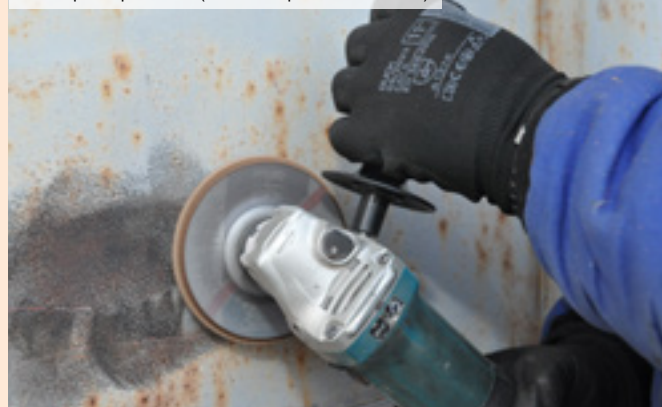
02 | Příprava podkladu (obroušení původního nátěru)
