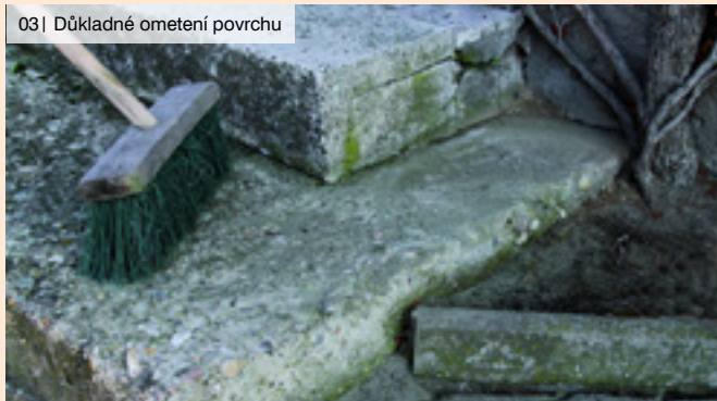
03 | Důkladné ometení povrchu
