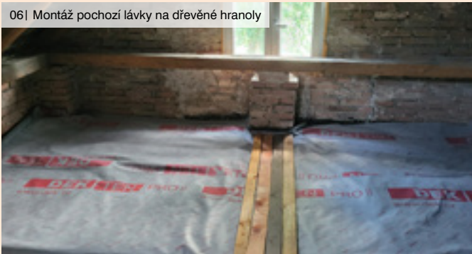
06| Montáž pochozí lávky na dřevěné hranoly
