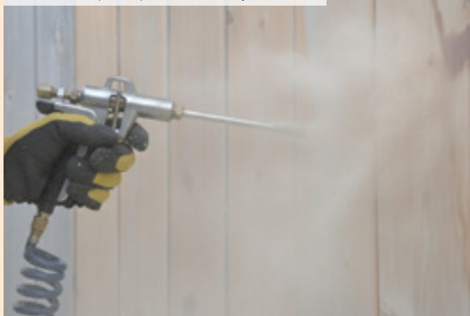
07| Odstranění prachu po broušení tlakovým vzduchem
