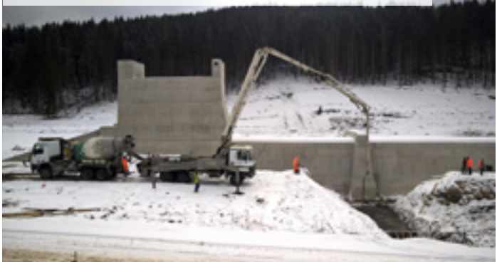
02 | Betonáž vodohospodářské konstrukce při teplotách pod bodem mrazu
