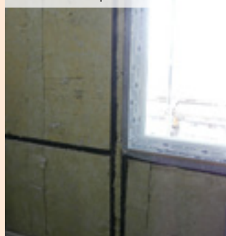
05| Tepelná izolace vložená do původního ocelového rámu fasádního panelu
