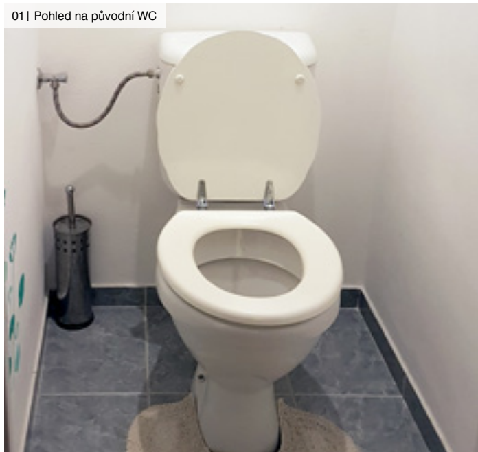
01 | Pohled na původní WC
