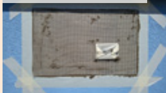
07| Dodatečné osazení budky do staršího ETICS – provedení základní vrstvy s výztužením
