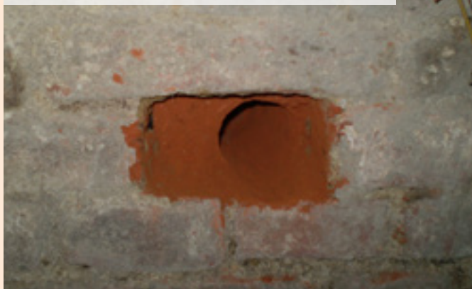
02| Odběr materiálu zdiva za účelem vyhodnocení vlhkostního stavu
