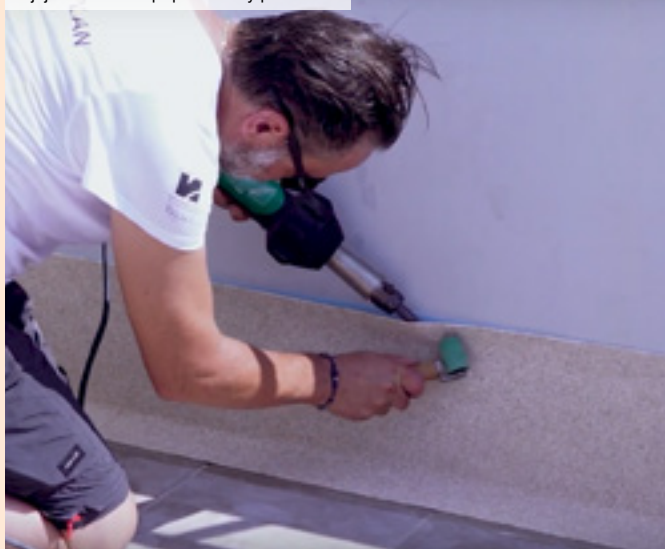
03| Nalepená pochozí fólie Decking Solid a její navaření na poplastovaný pásek
