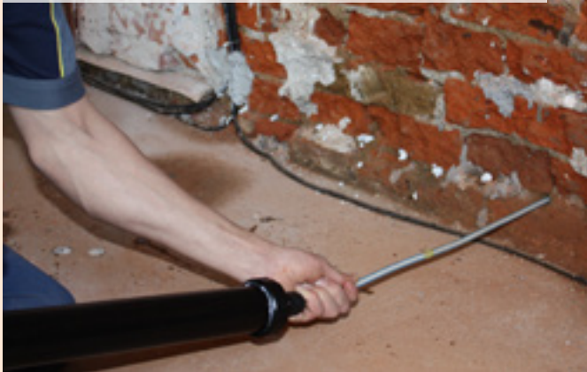
06| Utěsnění otvorů po injektáži
