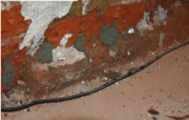
06| Utěsnění otvorů po injektáži
