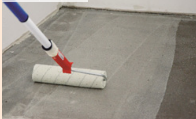
03 | Zalití smršťovací spáry pružnou epoxidovou hmotou
