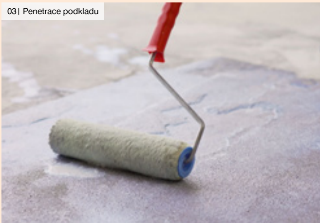
03 | Penetrace podkladu
