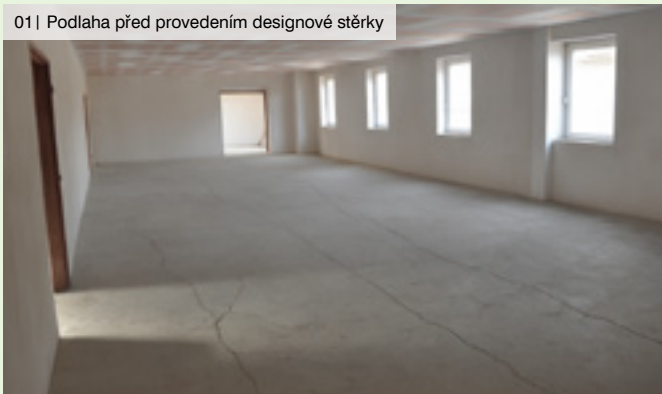
01 | Podlaha před provedením designové stěrky
