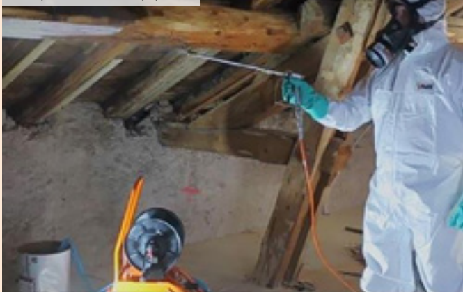
04| Krov po ošetření biocidním přípravkem
