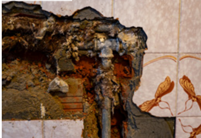
01 | Pohled na staré rozvody
