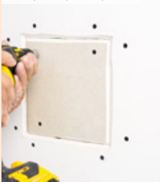
07| Připevnění přířezu k profilům
