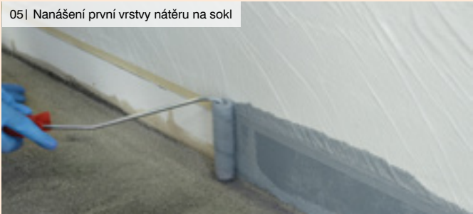
05| Nanášení první vrstvy nátěru na sokl
