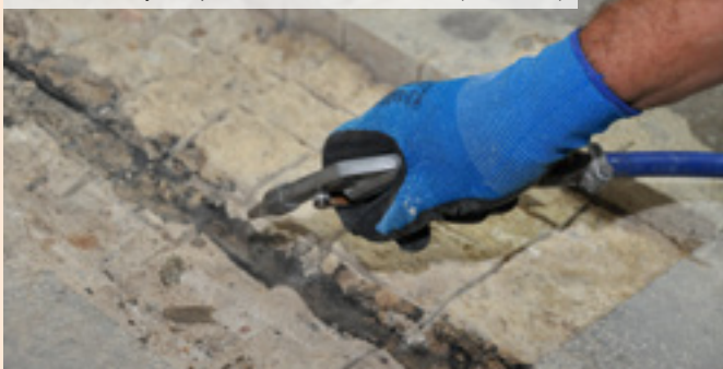
05| Dočištění výtluhu proudem stlačeného vzduchu (ofouknutím)
