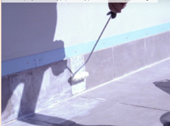
03| Nalepená pochozí fólie Decking Solid a její navaření na poplastovaný pásek
