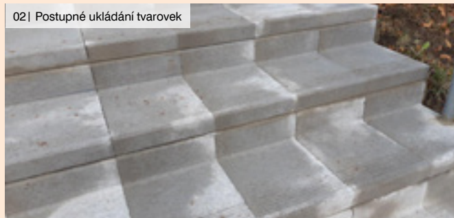
02 | Postupné ukládání tvarovek
