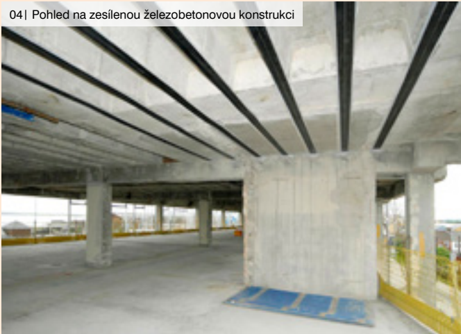
04| Pohled na zesílenou železobetonovou konstrukci
