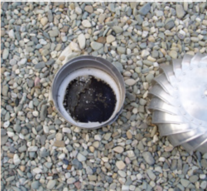
05| Pohled do otevřeného komínku s viditelnou vodou ve skladbě střešního pláště
