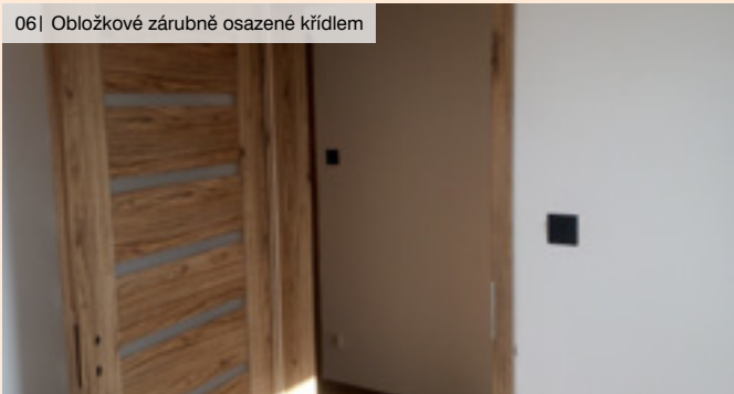
06| Obložkové zárubně osazené křídlem
