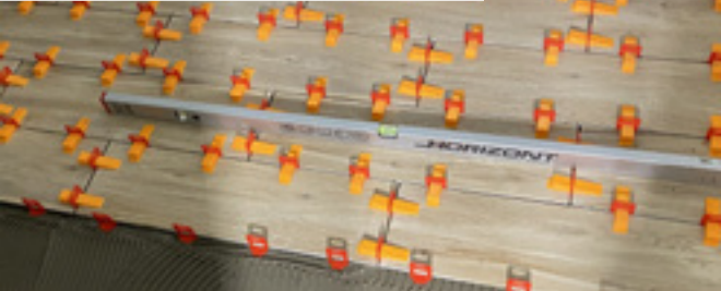
07| Pokládka finální vrstvy podlahy (dlažby do lepidla)
