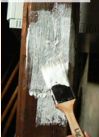
05| Aplikace protipožárního nátěru
