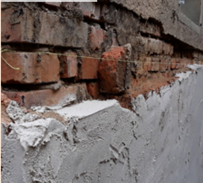
04| Vyrovnaní povrchu zdiva omítkou
