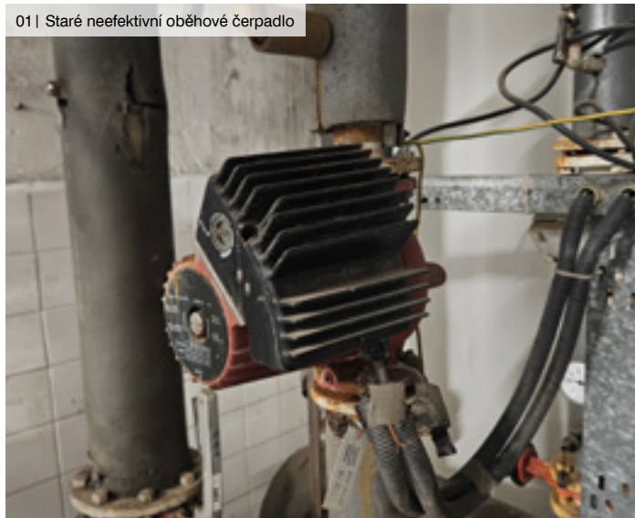
01 | Staré neefektivní oběhové čerpadlo
