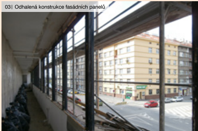
03| Odhalená konstrukce fasádních panelů
