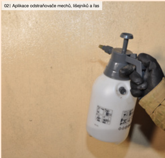
02 | Aplikace odstraňovače mechů, lišejníků a řas
