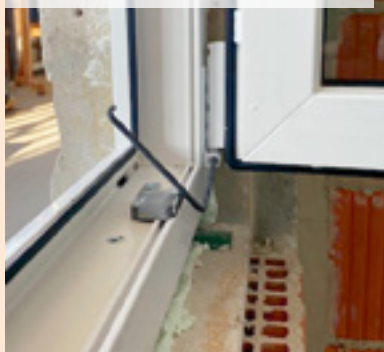
02 | Svislý a vodorovný posun křídla okna spodním závěsem
