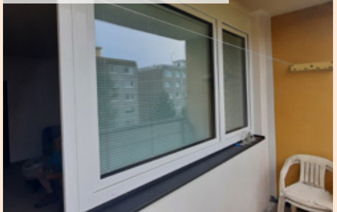
08| Dokončená nová sestava okna a balkónových dveří
