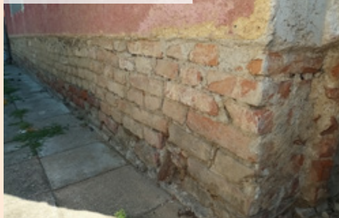
04| Podřezání zdiva, vložení přířezů asfaltového pásu
