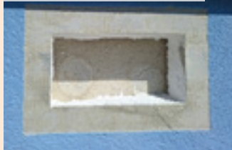
07| Dodatečné osazení budky do staršího ETICS – provedení základní vrstvy s výztužením
