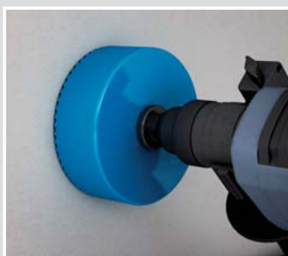
Vytvořte instalační otvor pomocí frézy o Ø 120 mm (např. bimetalová fréza, obj. č. 1082-20).
