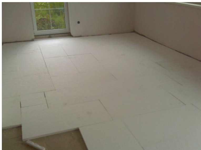
Obr. 1 - Příklad použití izolace Isover EPS RigiFloor 4000
