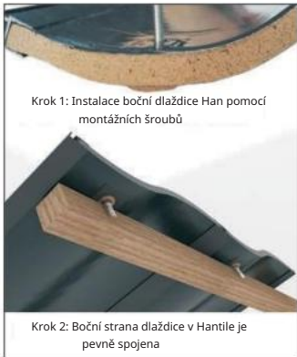
5-2-1.6 Instalace bočního titulu tašky Han na betonovou střechu
