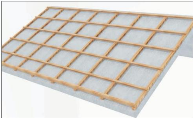
5-2-1.2 Instalace střešních latí na betonovou střechu
