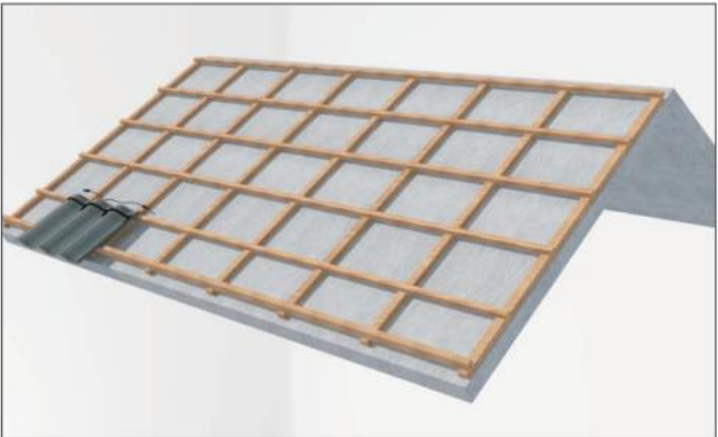
5-2-1.3 Instalace hlavních tašek Han na betonovou střechu
