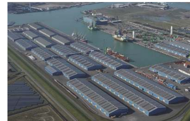
Nízká nosná střecha Nizozemsko | 3,2 MW
