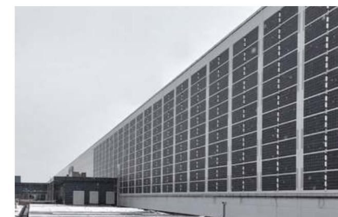
Solární fasáda Německo | 33 kW
